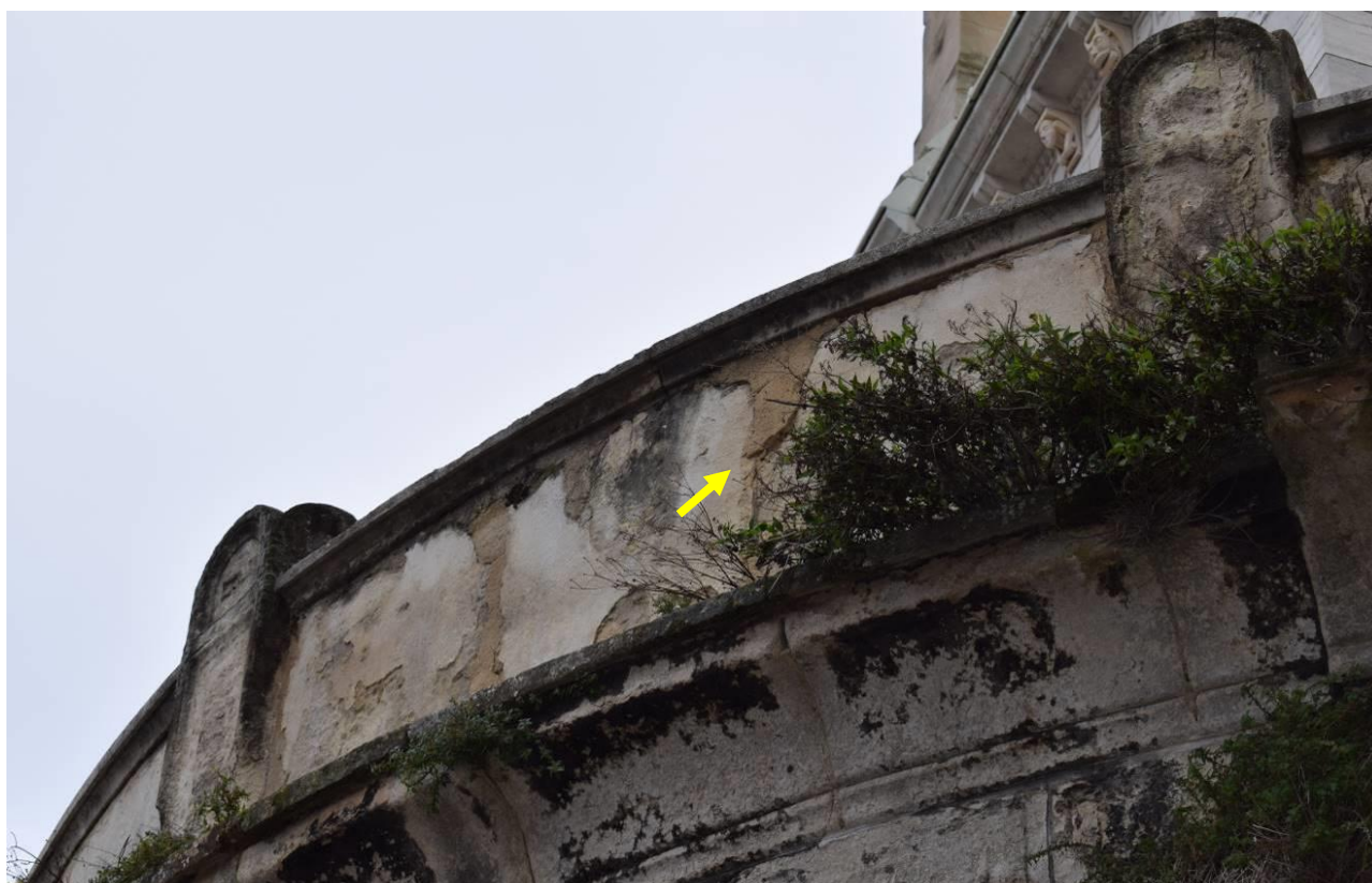
Section de parapet présentant des décollements de ragréages
