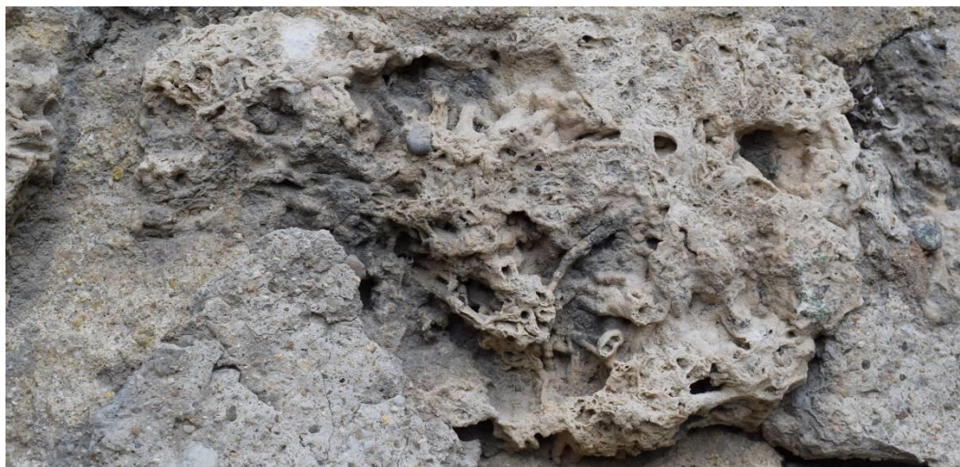
Détails de blocs de tuf calcaire ou de cargneule
