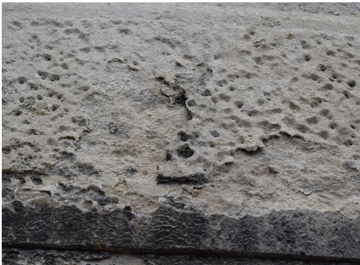
Détails d'un bloc en cours de desquamation
