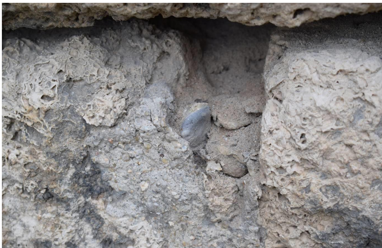
Détail du mortier de hourdage
