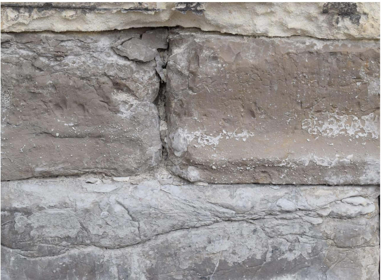
Détail du calcaire dur de Crussol employé en soubassement
