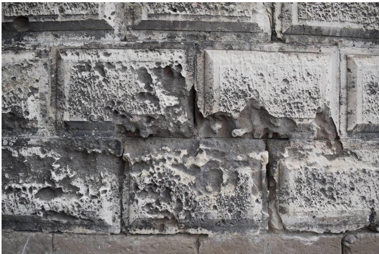
Exemple d'alvéolisation particulièrement importante sur le parement à bossages
