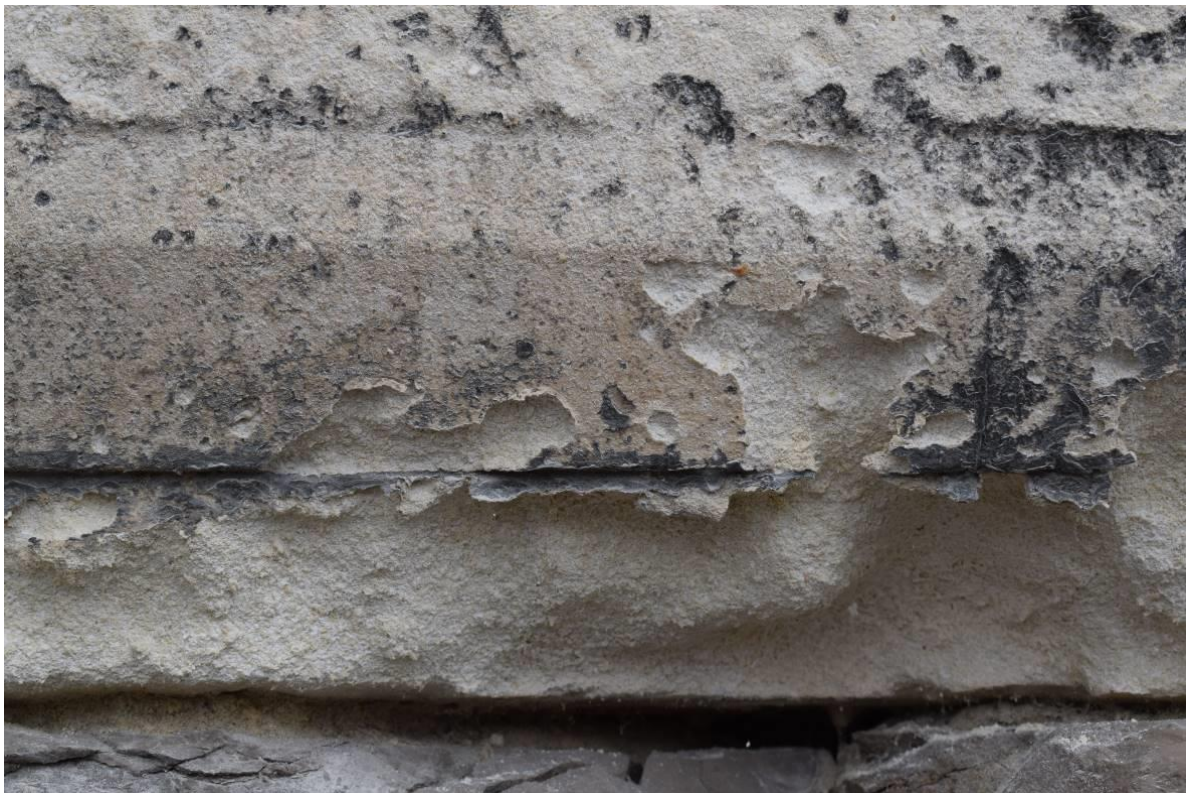
Alvéolisation en cours avec desquamation de l'épiderme au droit des creusements
