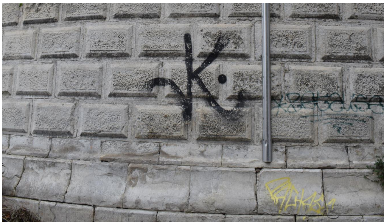
Exemple de graffiti affectant le parement en calcaire et le soubassement en pierre de Crussol
