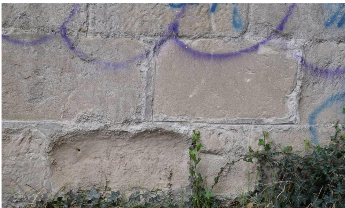
Détail du faciès de molasse majoritaire sur l'extrémité Sud du mur de soutènement
