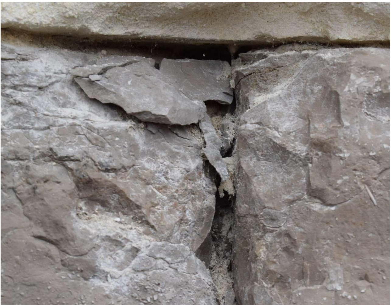
Détail de blocs de calcaire de Crussol éclatés
