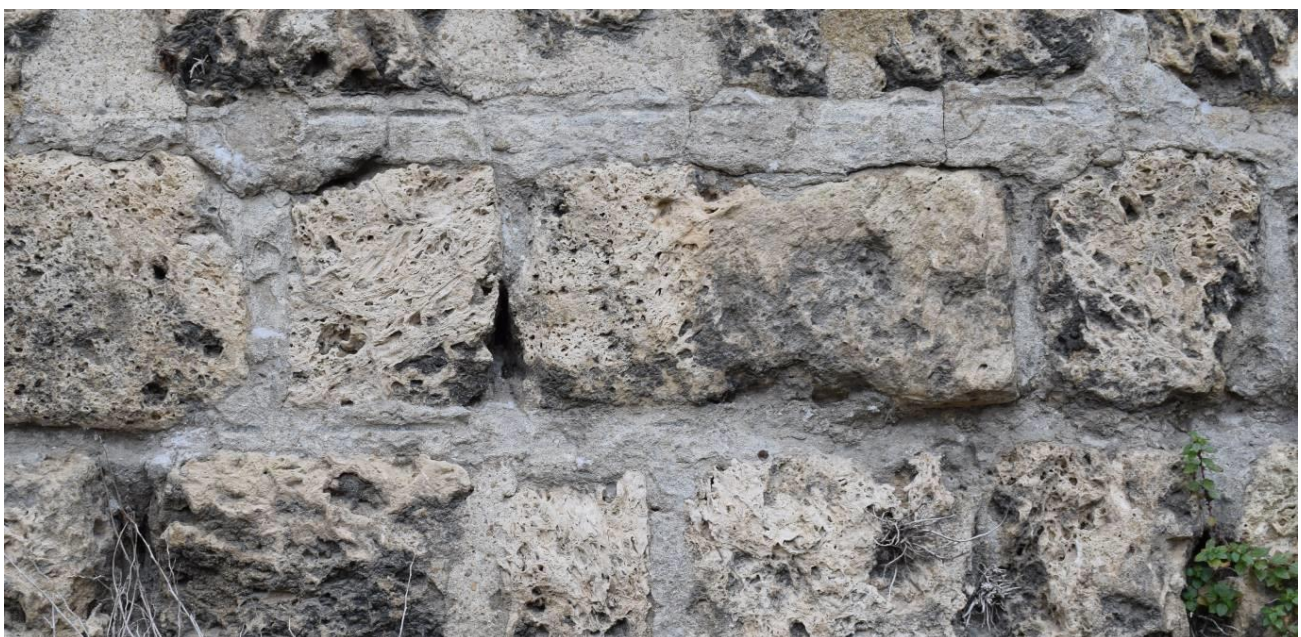
Détail d'une portion de parement conservant les joints anciens
