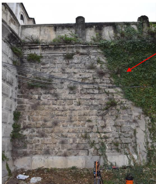
Parement en blocs de tuf calcaire
