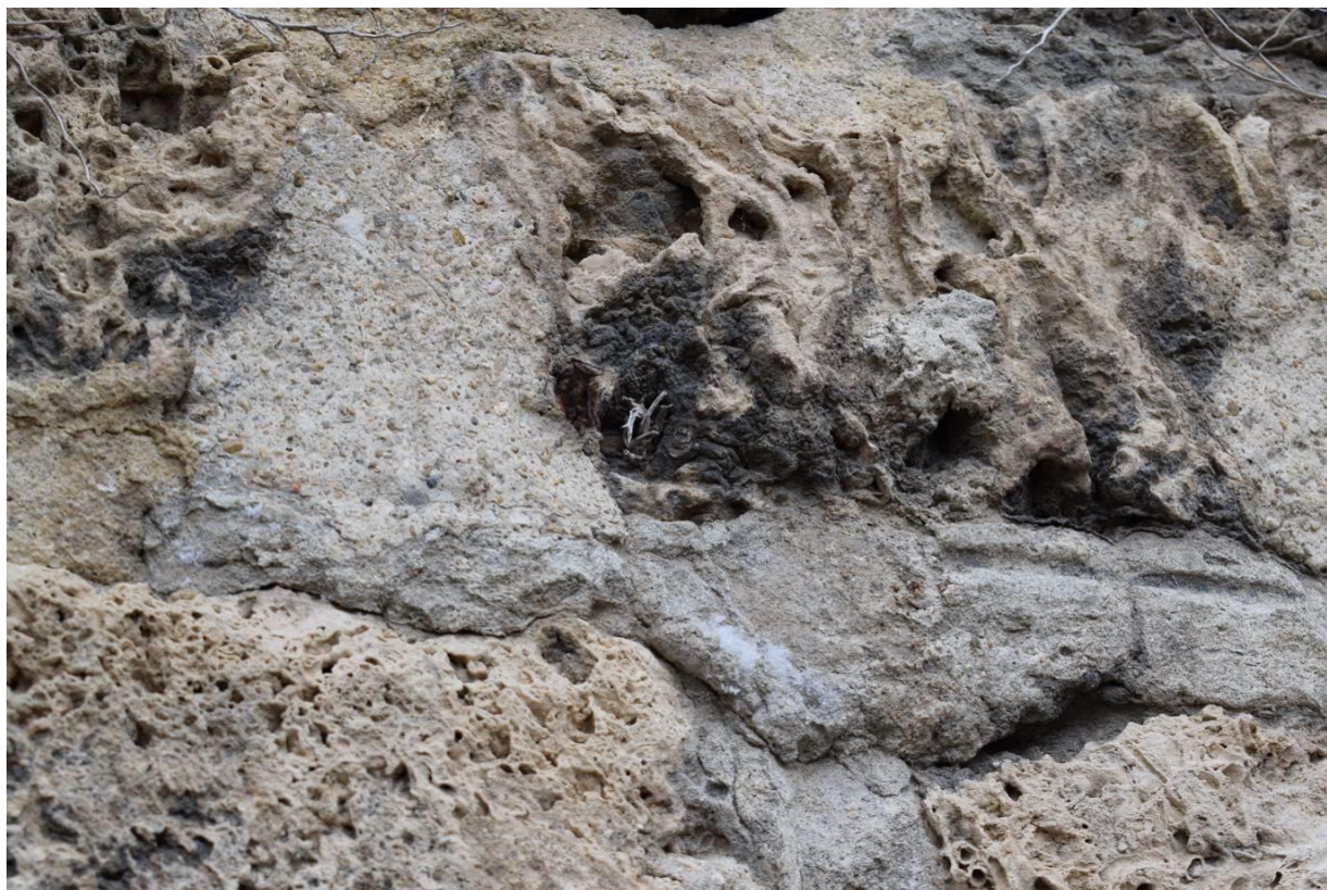
Détail des joints anciens partiellement repris par le mortier plus récent
