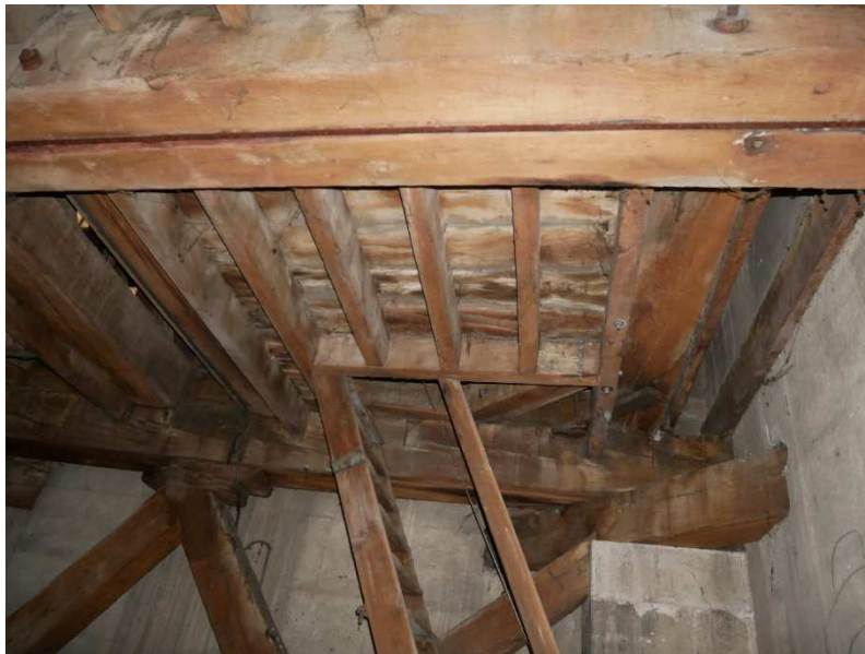
Fig 31. Appui des poutres du plancher supérieur sur les maçonneries d'angles / EQ 2021
