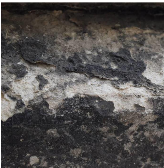
Détail des croûtes noires et des desquamations affectant les pierres de corniche
