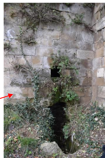
Détail et localisation sur l'élévation du mur de soutènement des regards permettant d'accéder au canal d'évacuation
