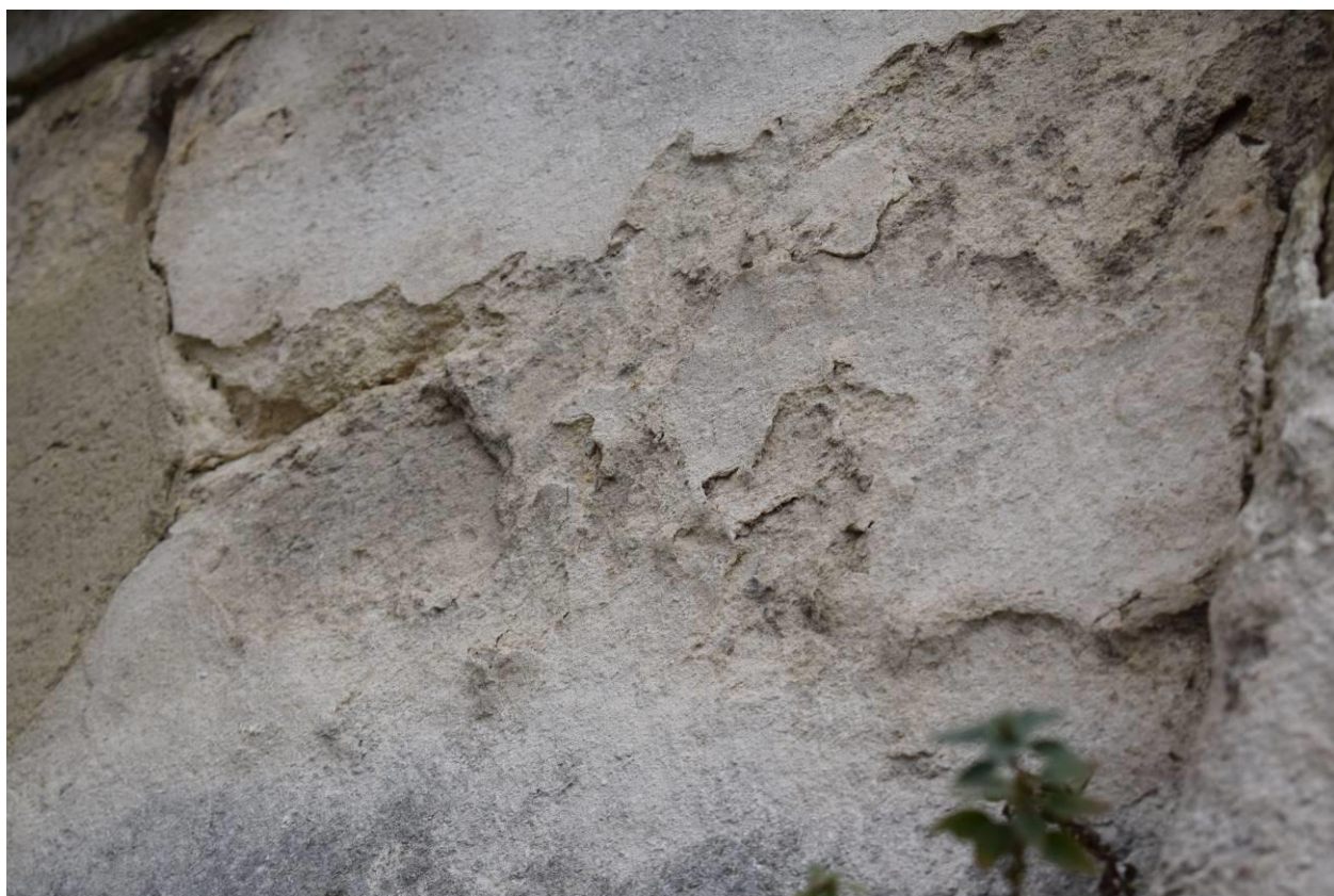
Détail d'une partie altérée du parapet présentant des desquamations
