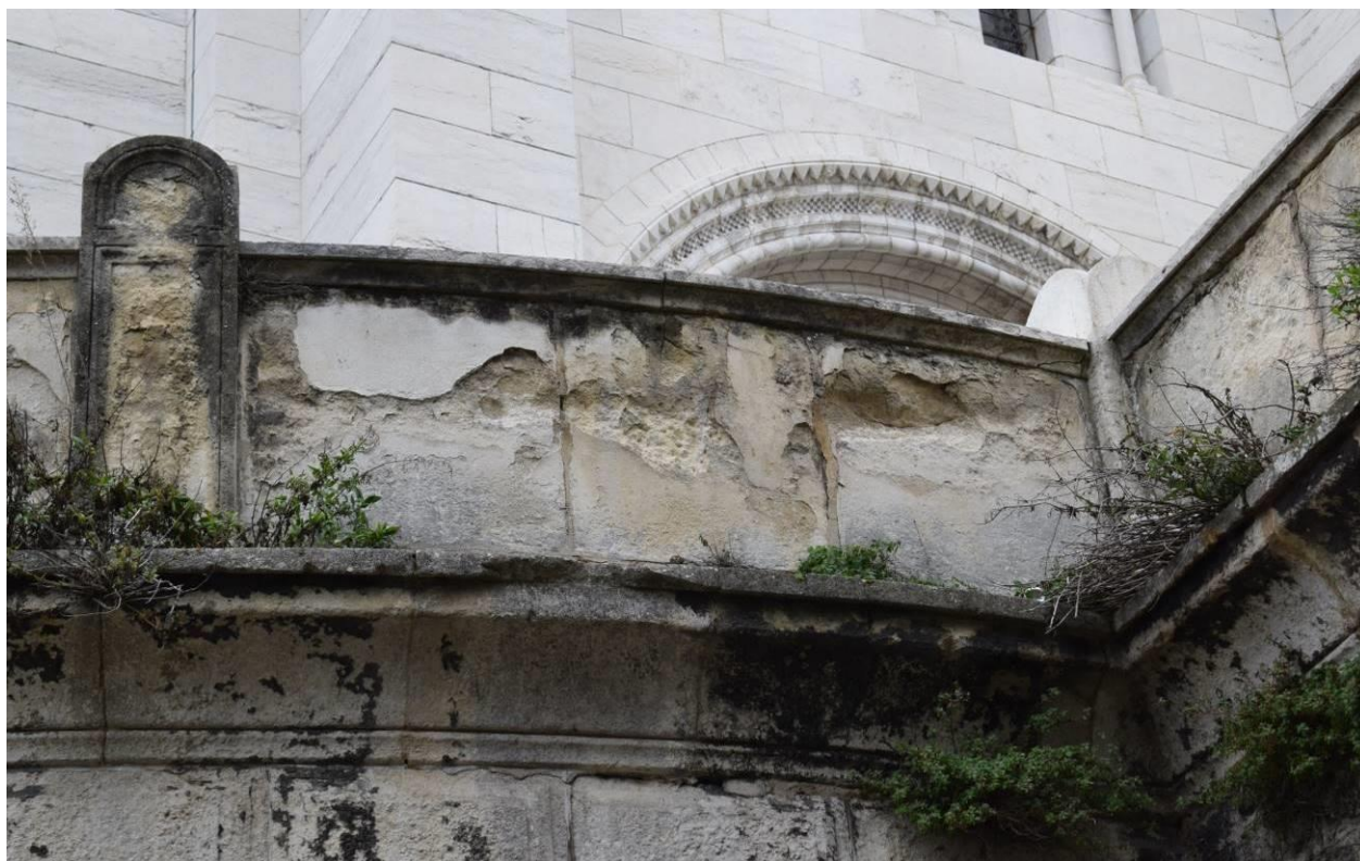
Détail d'une portion de parapet comportant de profondes lacunes
