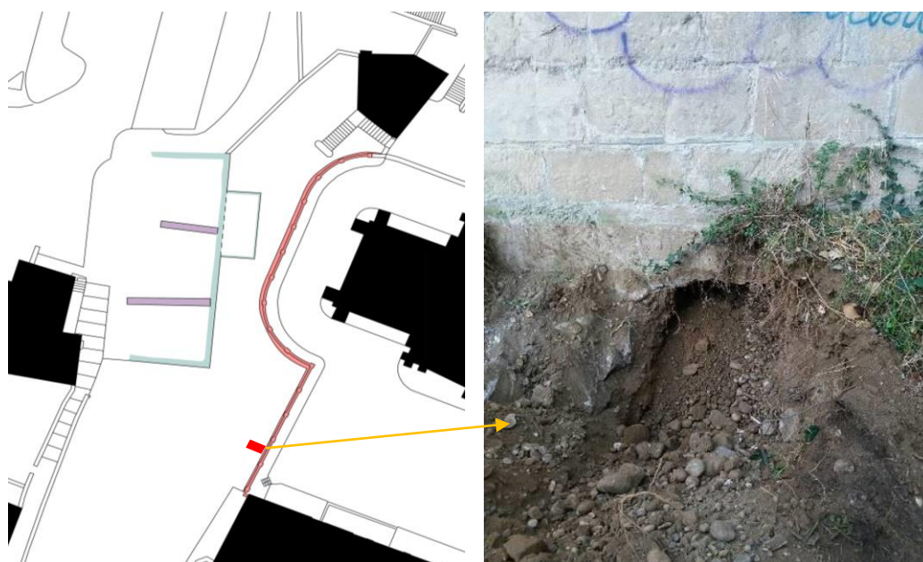
Localisation et détail du sondage de reconnaissance à la minipelle
