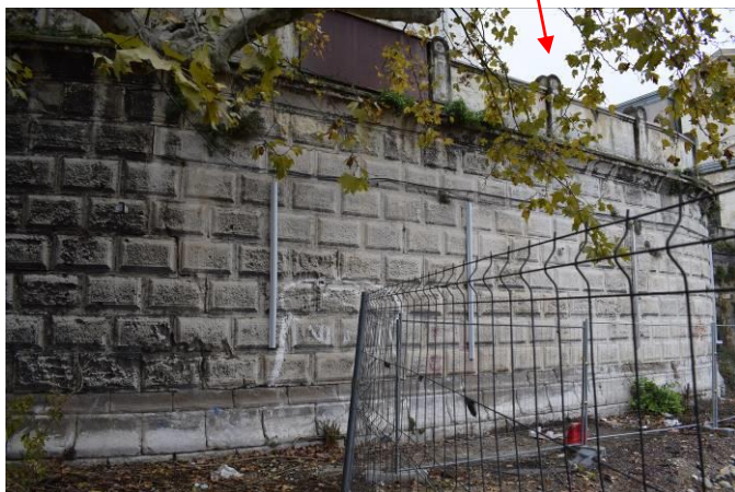
Détail du parement XIX ème siècle en calcaire type Saint-Paul-Trois-Châteaux et en calcaire type Crussol
