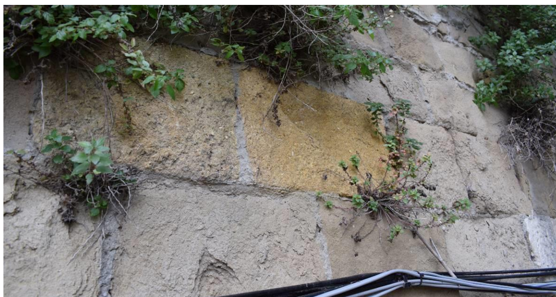
Exemple de greffes réalisées avec un faciès de molasse de teinte ocre jaune plus prononcée
