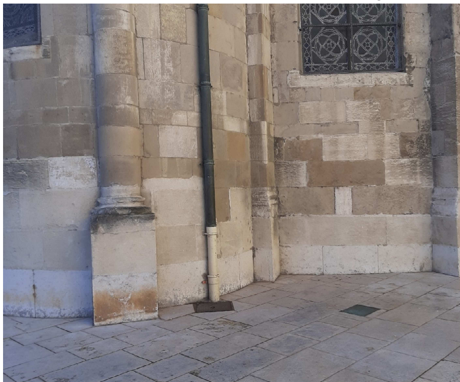
Figure 8 : Photographies des gouttières et boîtes de branchement façade Est.
