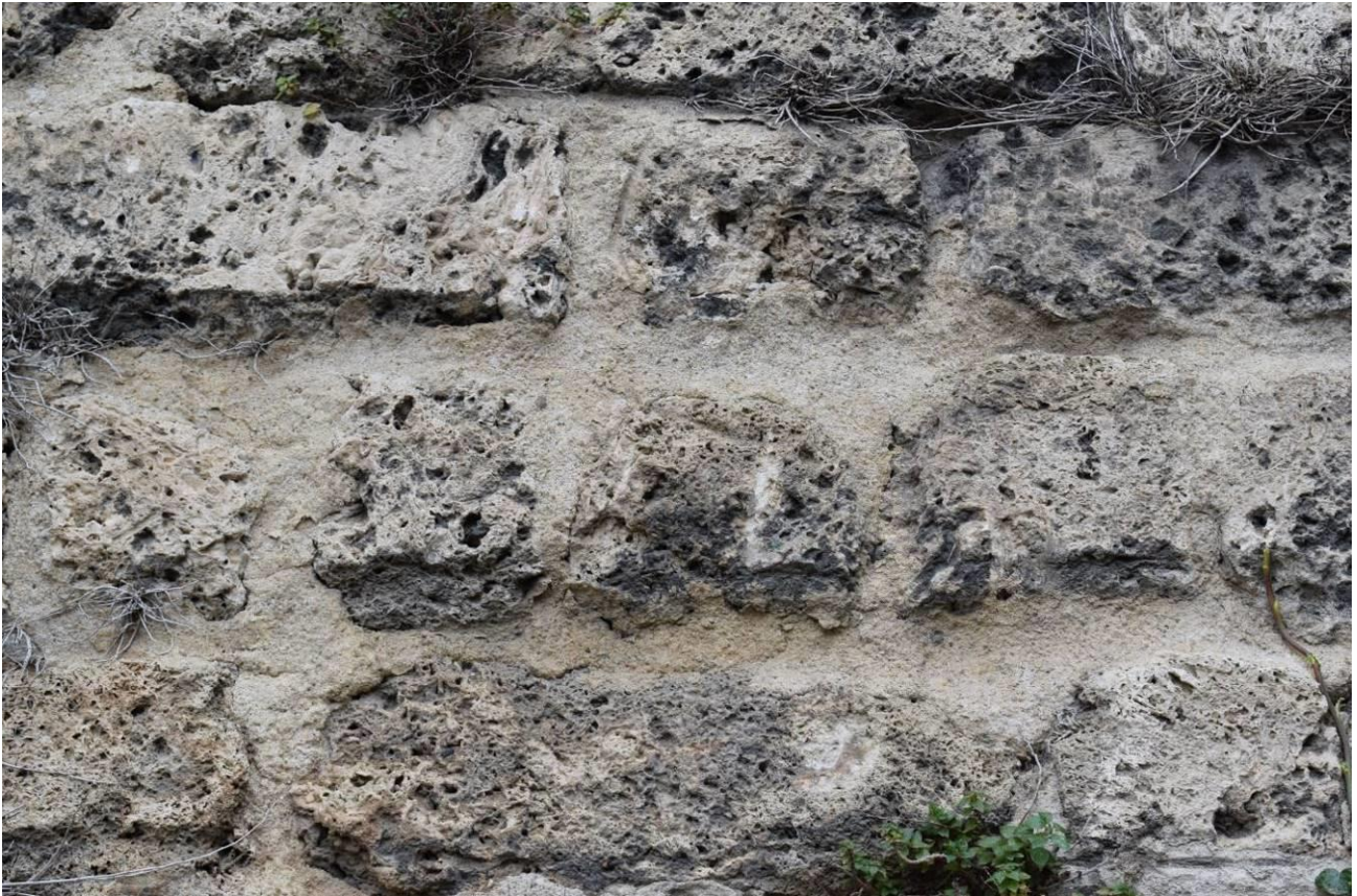
Détail d'une zone rejointoyée à l'aide d'un mortier de chaux et de sable
