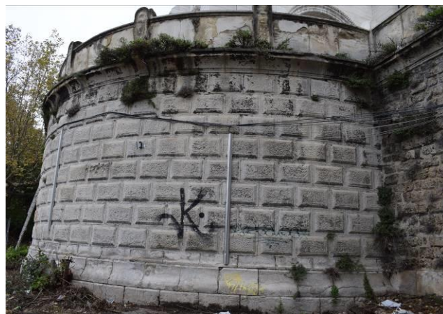
Détail du parement XIX ème siècle en calcaire type Saint-Paul-Trois-Châteaux et en calcaire type Crussol
