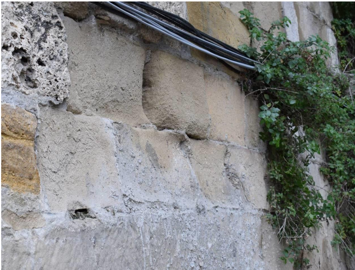
Parement en molasse présentant des pertes de matière hétérogènes
