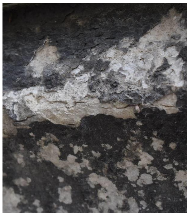
Détail des croûtes noires et des desquamations affectant les pierres de corniche
