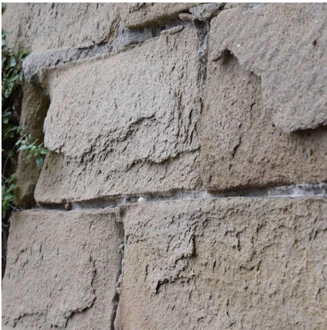
Exemple de blocs subissant des desquamations d'intensités différentes
