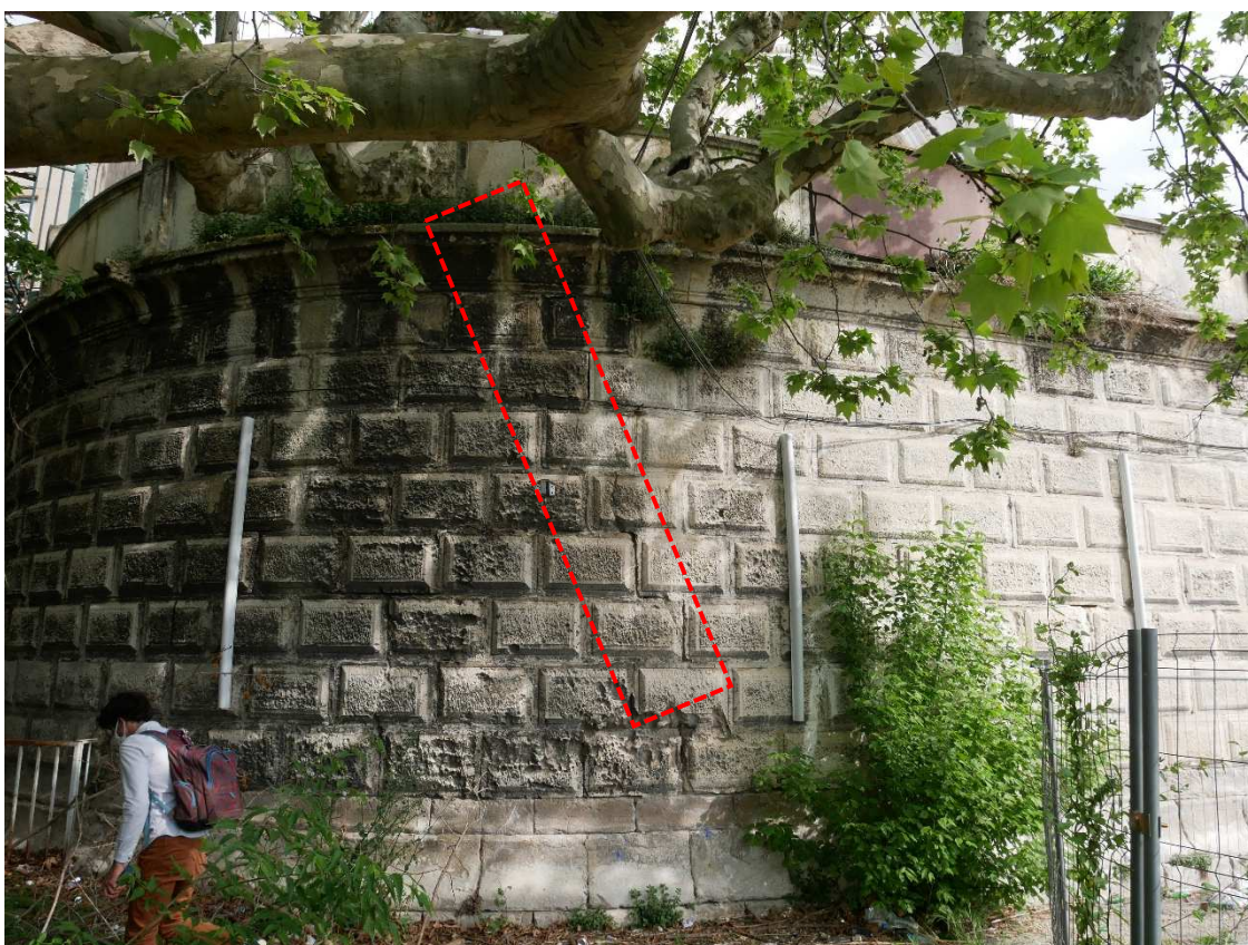
Fig 34. Vue de la partie courbe nord fissurée / EQ 2021
