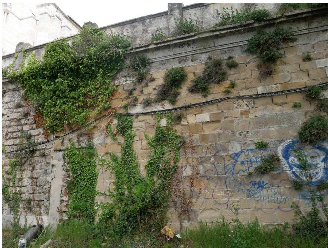
Fig 35. Végétation envahissante sur les corniches et les parements des murs M2 et M3 / EQ 2021
