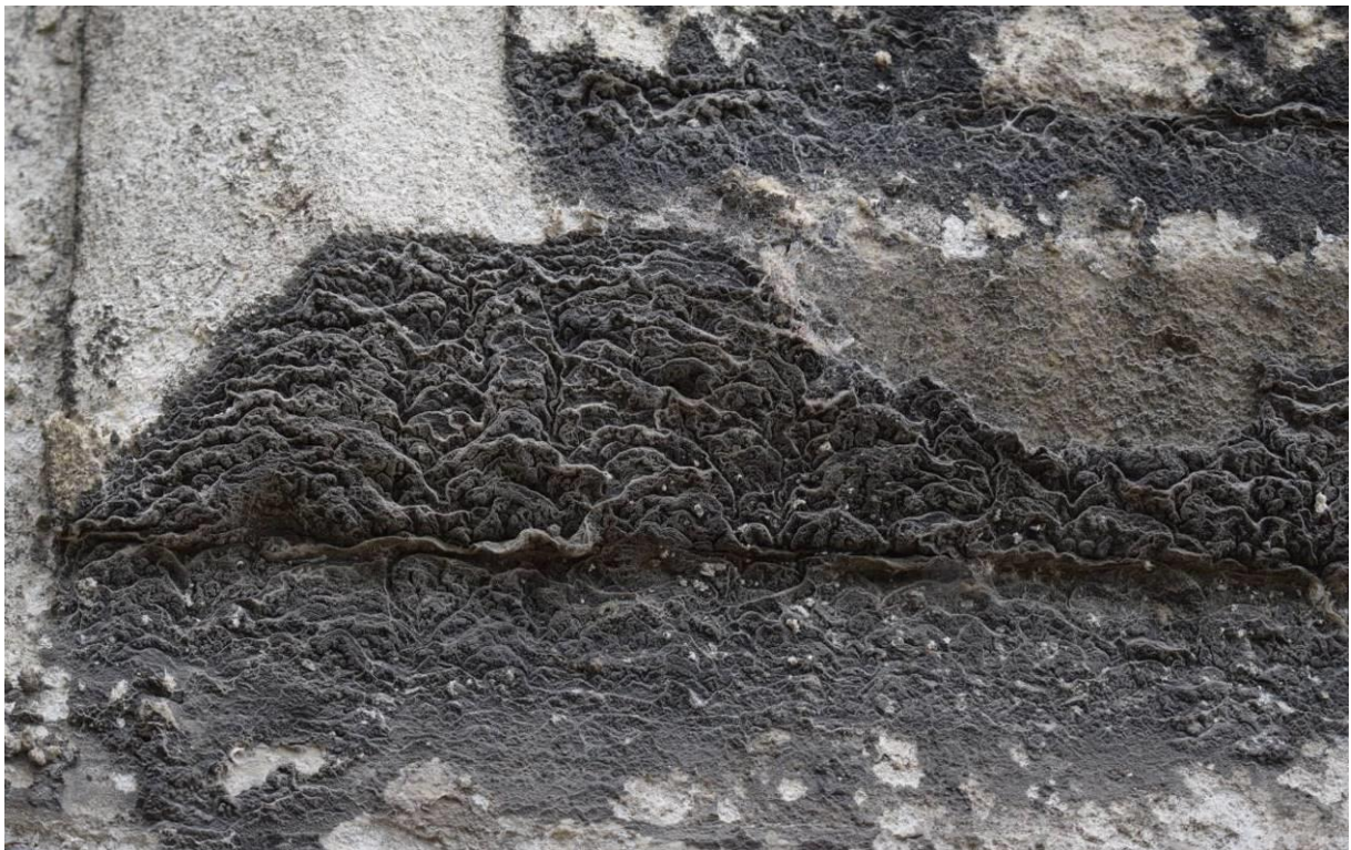
Vue de la portion de parement recouverte de croûte noire et détail de l'aspect bourgeonnant de cette dernière
