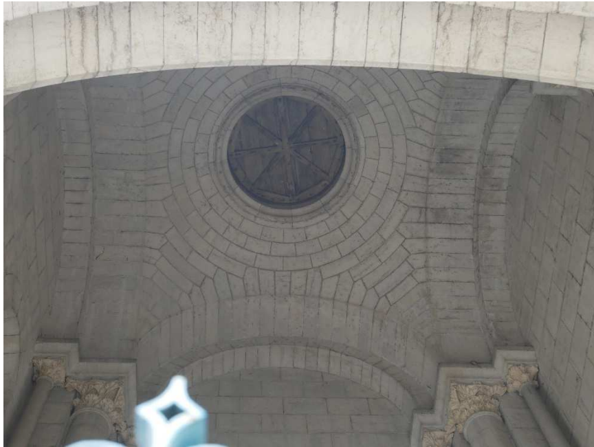
Fig 30. Coupole sur pendentif en plancher haut du RDC / EQ 2021
