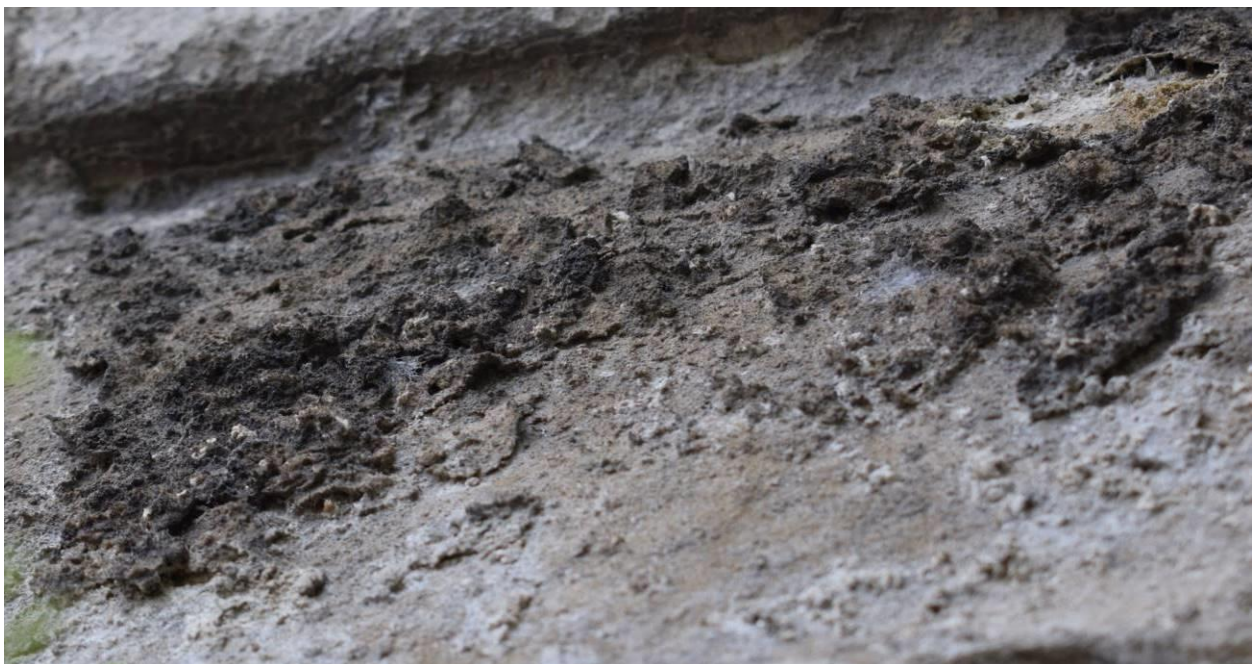
Détail des boursouflures affectant la corniche en calcaire
