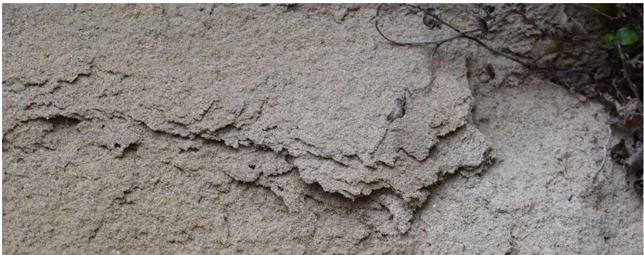
Détail d'un bloc de molasse comportant un délitement sous forme de micro-feuillets
