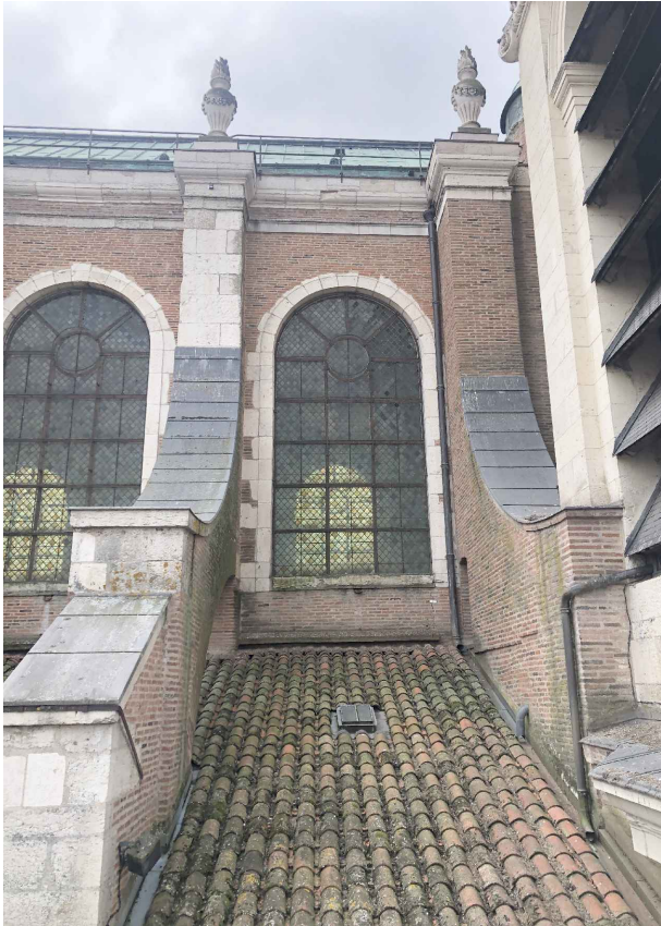
Verrières hautes de la nef à protéger, couverture en tuile des bas-côtés à déposer partiellement
