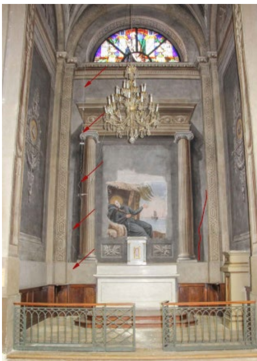
Exemples de décor peint endommagé par des fissures. Mur de fond et voûte de la chapelle Saint François-Xavier
