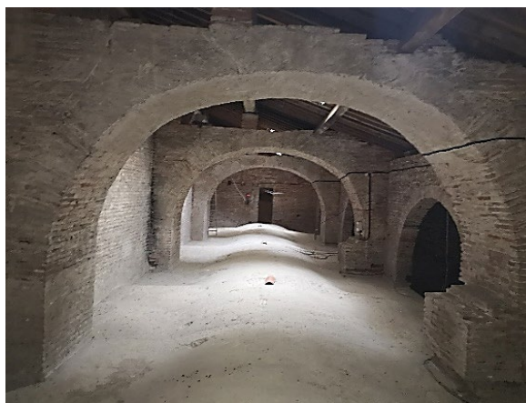
Coup de sabre entre le massif occidental et la nef. Arcs diaphragmes des combles des collatéraux ©BMI 2022
