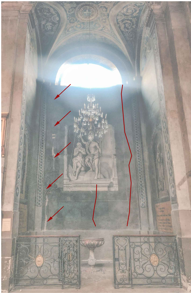
Vue générale de la chapelle avec les fissures existantes
