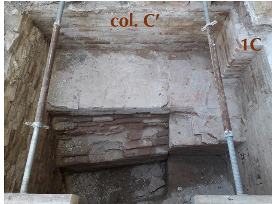
Figure 13 : fondations de l'avant-corps central observées dans la fouille RF5 – photo GEOLIA
