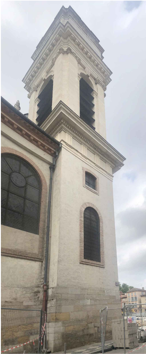
Menuiseries et abat-sons à déposer en conservation, baies à étrésillonner
