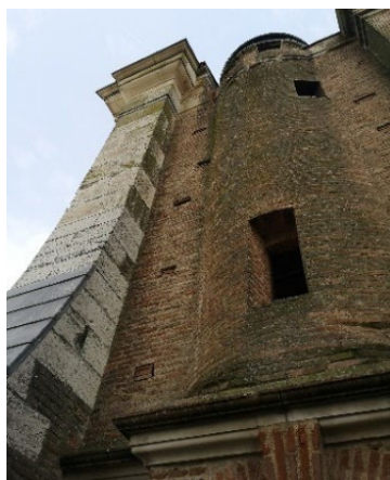
Coup de sabre entre le massif occidental et la nef. Arcs diaphragmes des combles des collatéraux ©BMI 2022
