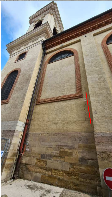
Fissures sur les façades latérales
