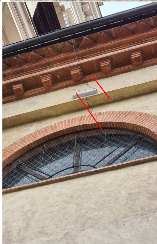
Fissures sur les façades latérales
