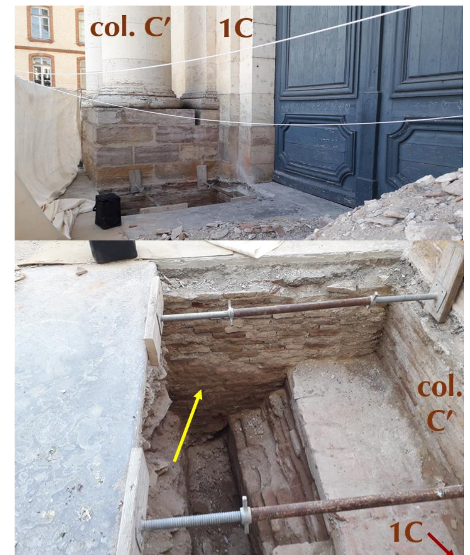
Figure 8 (sup. et inf.) : vues de la fouille RF5 au pied de l'avant-corps de la façade, avec repérage d'infrastructures en brique ne semblant pas appartenir au système de fondations de l'avant-corps (flèche jaune) – photo GEOLIA
