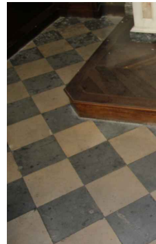
Carreaux de pierre noire et blanche à déposer
