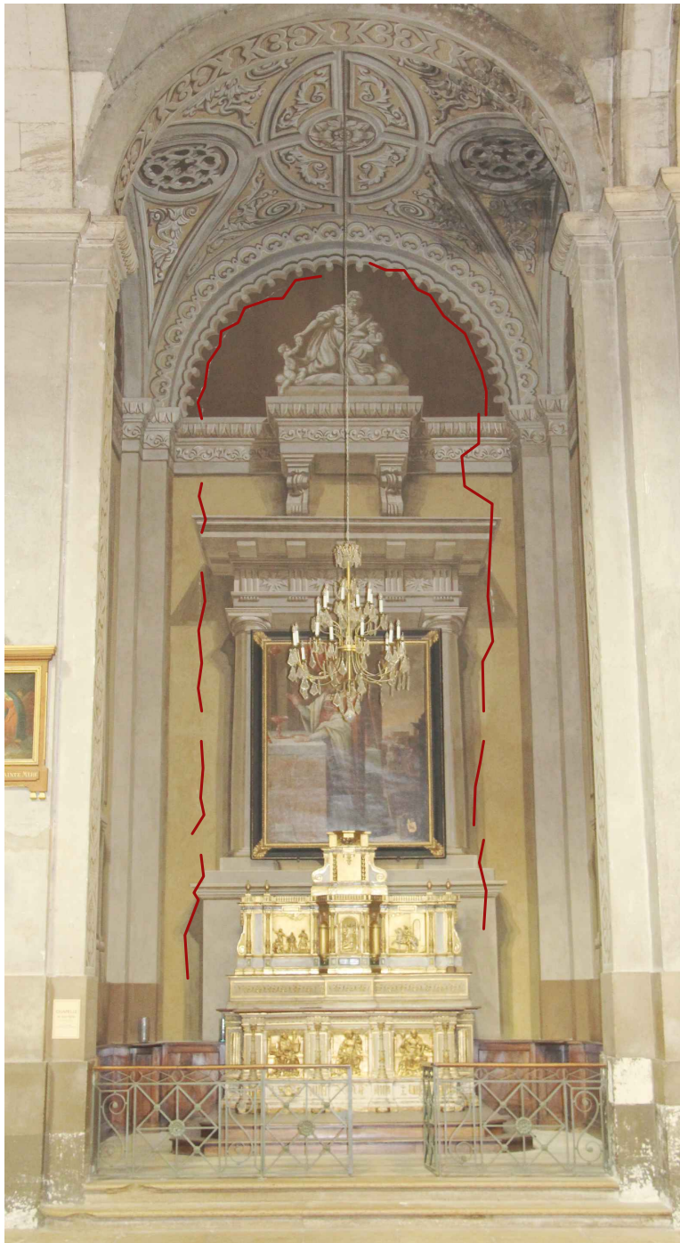
Vue générale de la chapelle avec les fissures existantes
