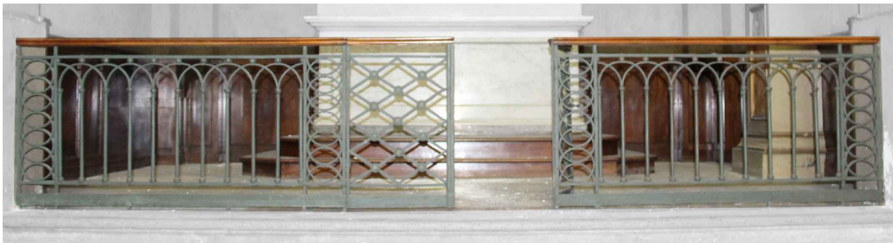
Grille de communion en fer forgé et lisse en bois
