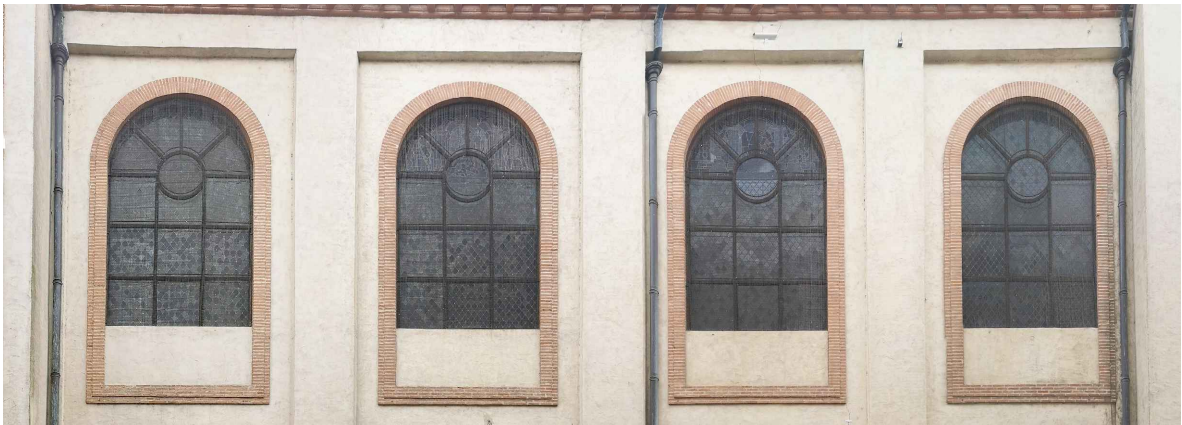
Verrière aveugle (4 ème travée - Chapelle St-Martin ) à protéger, les 2 verrières aveugles et vitraux d'imposte (3 ème travée - Chapelle St-Théodard et 2 ème travée - Chapelle St-Fraçois-Xavier ) à protéger, et verrière (1 ère travée - Chapelle Lenoir ) à déposer en conservation et à étrésillonner
