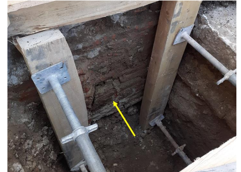
Figure 11 : Dislocation de la maçonnerie des fondations observée localement en fond de fouille RF4
