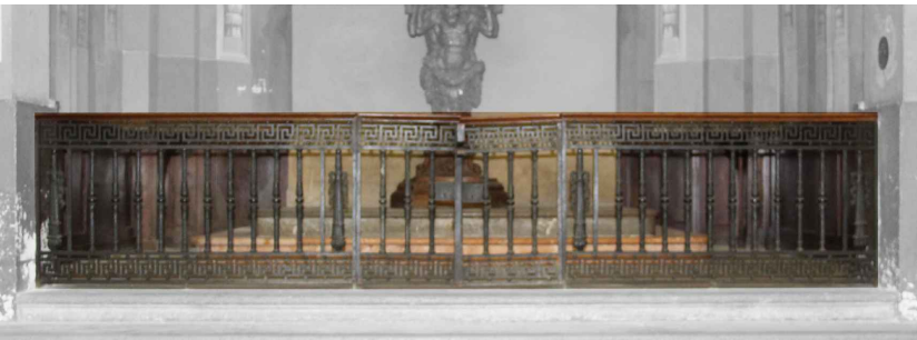
Grille de communion en fer forgé et lisse en bois
