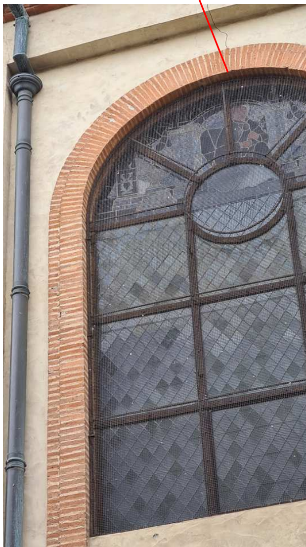
Fissure sur ouverture coté façade latérale Nord
