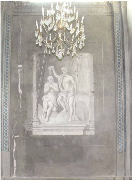
Fissures et chute d'éléments de décor peint
