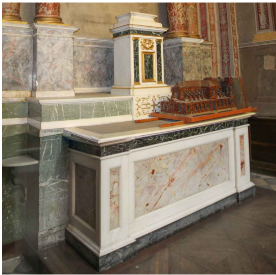
Autel en maçonnerie de brique et plâtre, couvert de plaques et moulures en marbre ; tabernacle en plaque de marbre
