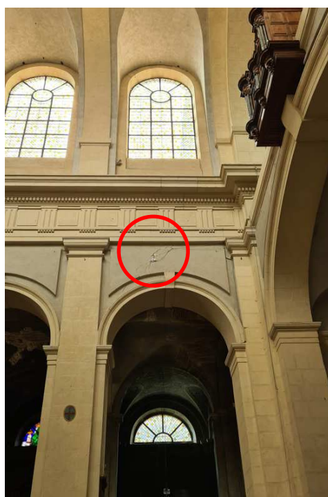
Fissures à l'intérieur de l'édifice
