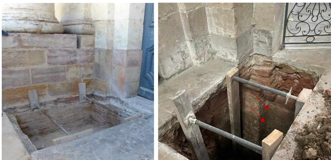
A gauche, les fondations en brique du massif ouest. A droite, vue d'une longrine en briques reliant les massifs de fondation des piles de la nef. Clichés @BMI et Géolia
