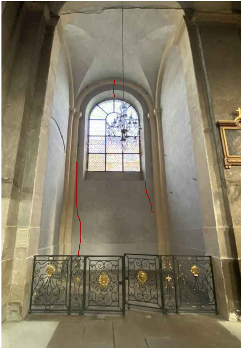
Vue générale de la chapelle avec les fissures existantes
