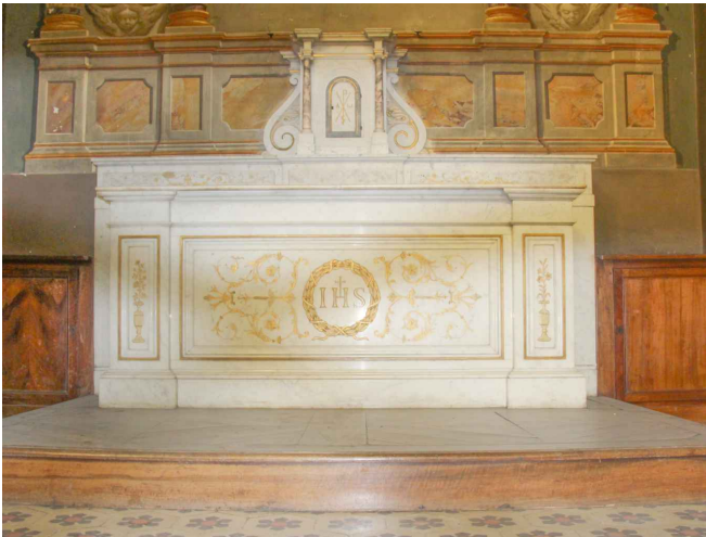
Autel en maçonnerie de brique et plâtre, couvert de plaques et moulures en marbre partiellement doré ; tabernacle en plaque de marbre ; emmarchement en bois
