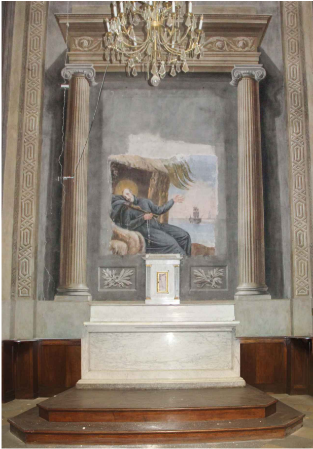
Autel en maçonnerie de brique et plâtre, couvert de plaques et moulures en marbre ; tabernacle en plaque de marbre ; emmarchement en bois et retable en trompe-l'œil
