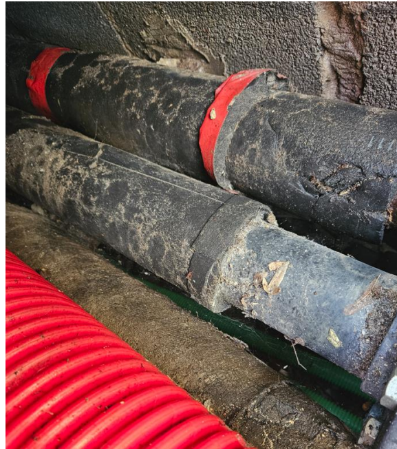
Réseau de chauffage existant en caniveau
