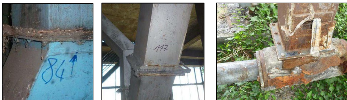
Figure 56 : Prélèvements P84, P117 et P236 : Joint entre module de de ventilation
