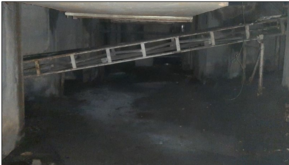
Figure 73 : Convoyeur en sous-sol pour évacuer les produits de combustion
