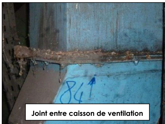
Figure 44 : Joints entre module de ventilation et joints de bride non quantifiés dans le pré-rapport
