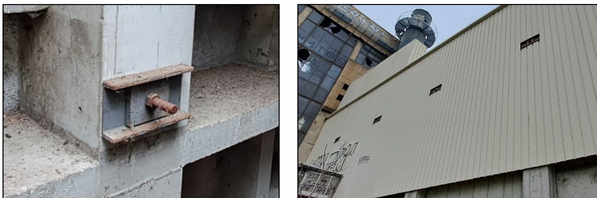
Figure 64 : Barres de moisage de poteaux à identifier
