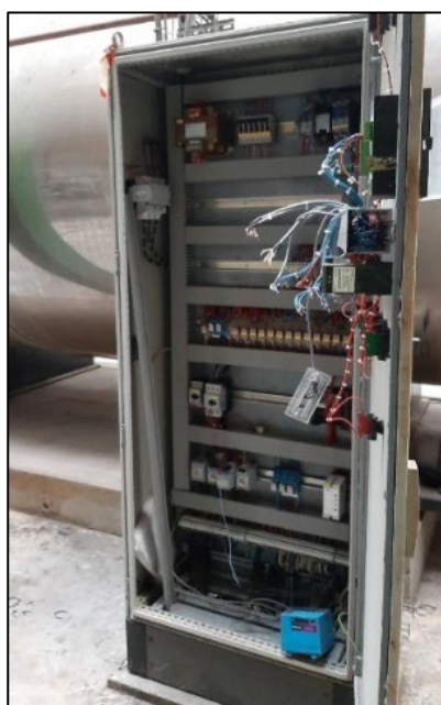
Figure 71 : Aperçu des câbles sectionnés
