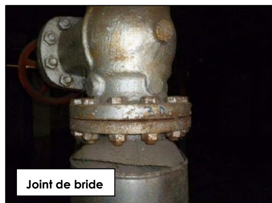
Figure 44 : Joints entre module de ventilation et joints de bride non quantifiés dans le pré-rapport
