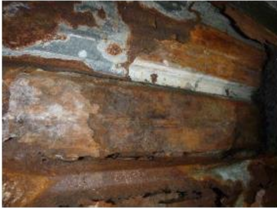
Bac acier corrodé en PH du sous-sol
