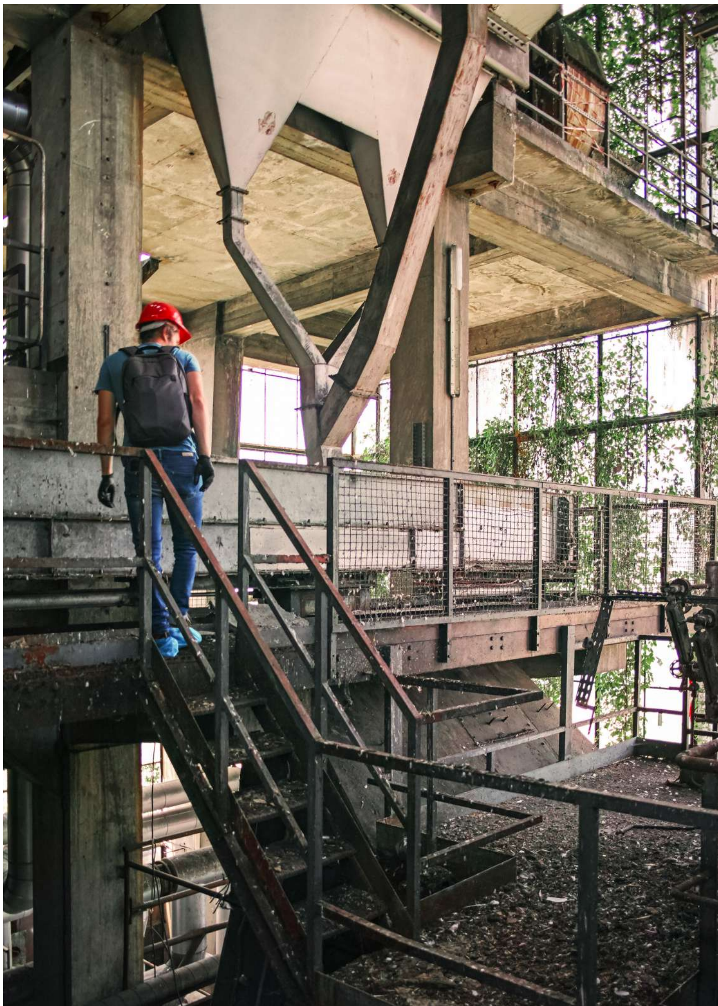
Vue intérieure de la Cathédrale - conduits - mezzanines béton et planchers métalliques
