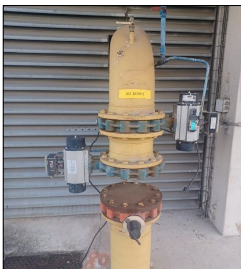
Figure 42 : Alimentation de la chaufferie en gaz de ville
