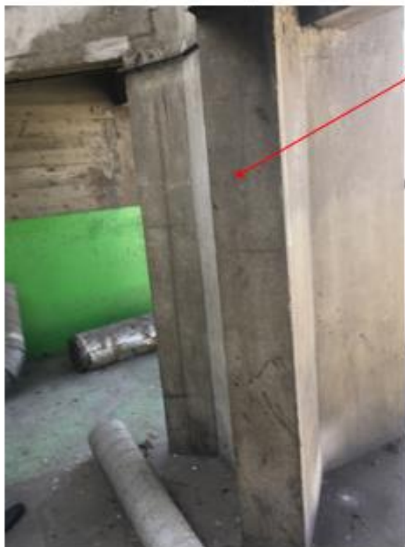
Poteau support du réseau de poutres croisées
