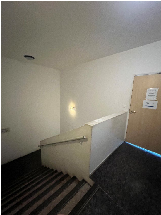
Cloison toute hauteur à surélever jusqu'au plafond
