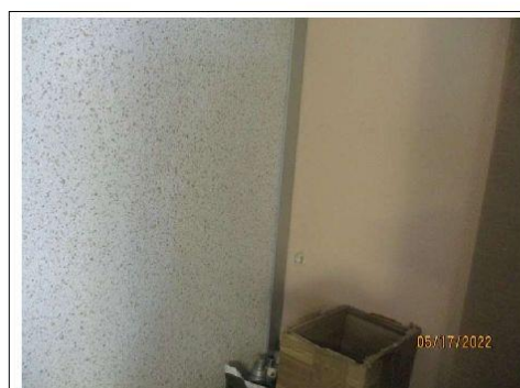
Prélèvement - P016 : R+1/Bât B / SDIF PTGC - Enduit- (Absence d'amiante)
