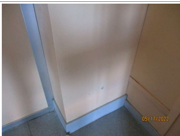
Prélèvement - P021 : R+1/Bât B / Cadre A - Enduit- (Présence d'amiante)
