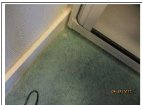
Prélèvement - P025 : R+2/Bât B / Bureau réception - Ragréage - (Présence d'amiante)
