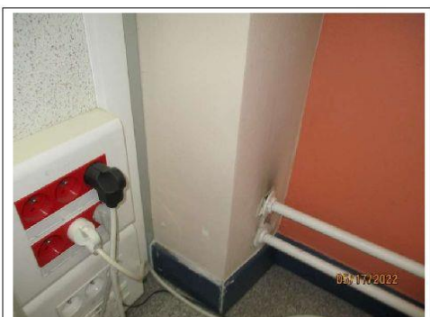
Prélèvement - P013 : R+1/Bât B / Cadre A SPF - Enduit- (Présence d'amiante)
