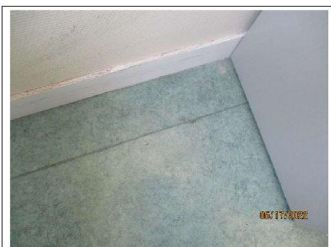
Prélèvement - P023 : R+2/Bât B / Bureau 220 - Ragréage- (Absence d'amiante)
