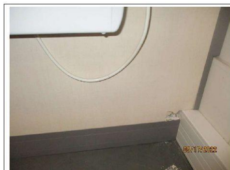
Prélèvement - P002 : R+1/Bât A / Chef DSPL - Enduit- (Absence d'amiante)
