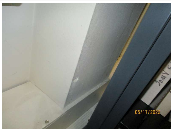
Prélèvement - P009 : R+1/Bât A / Municipale - Enduit- (Présence d'amiante)
