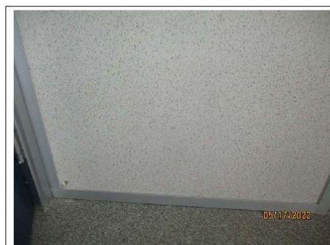
Prélèvement - P012 : R+1/Bât B / Cadre A SPF - Enduit- (Absence d'amiante)
