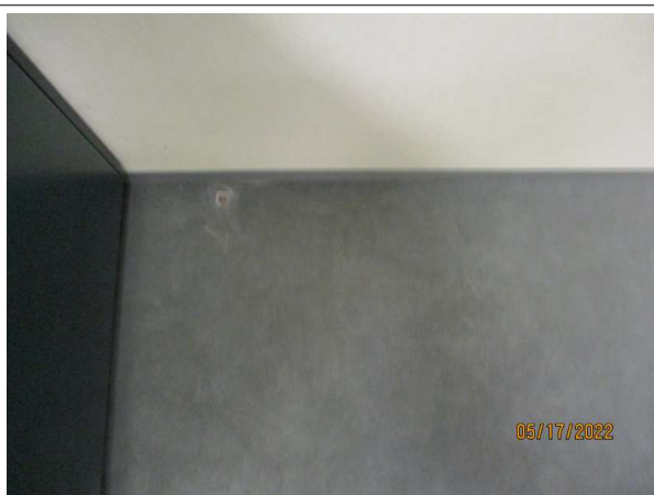
Prélèvement - P003 : R+1/Bât A / Chef DSPL - Ragraéage- (Absence d'amiante)
