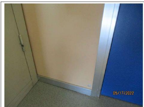
Prélèvement - P019 : R+1/Bât B / Cadre A - Enduit- (Absence d'amiante)
