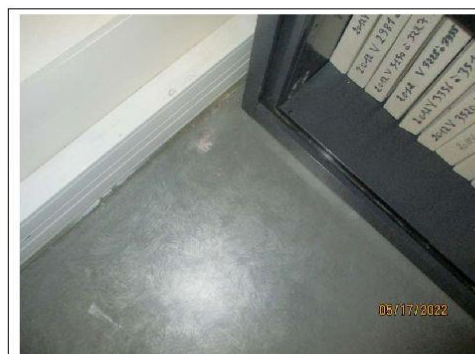
Prélèvement - P008 : R+1/Bât A / Municipale - Ragréage- (Absence d'amiante)
