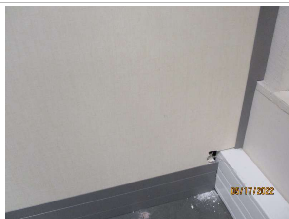
Prélèvement - P004 : R+1/Bât A / Salle de réunion - Enduit- (Absence d'amiante)
