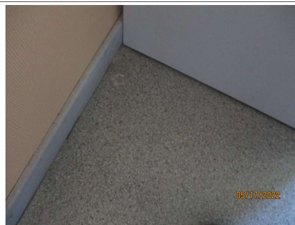
Prélèvement - P020 : R+1/Bât B / Cadre A - Ragréage- (Absence d'amiante)
