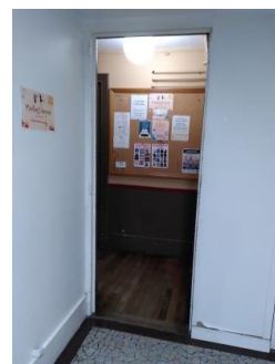
Porte avec passage en chicane L. 0,8 m ; h. 2,20 Les caisses d'une longueur supérieure à 1,86 m sont susceptibles de ne pas passer
