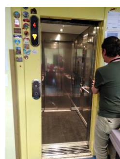
Ascenseur L. porte 0,79 m ; h. 2 m Cabine L. 90 m ; h. 2,19 m ; p. 1,36 m Capacité de 630 kg
