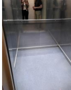
Ascenseur triplex Porte L. 1,05 m ; h. 2 m Cabine L. 1,3 m ; h. 2,22m ; p. 1,3m Capacité 630 kg
