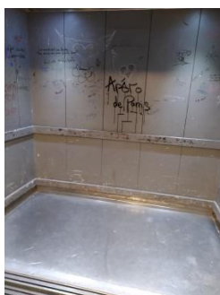
Monte-charge L. de la porte 2m ; h. 2,1 m Cabine L. 2,43 m ; h. 2,35 m ; p. 1,38 m Capacité 2000 kg
