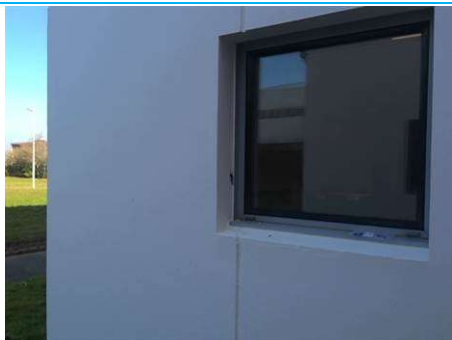
Matériaux : ZPSO-006 Prélèvement : P013 Description : Joint d'étanchéité entre menuiserie et structure Localisation : EXTERIEURS - FACADE NORD Résultat : Absence d'amiante
