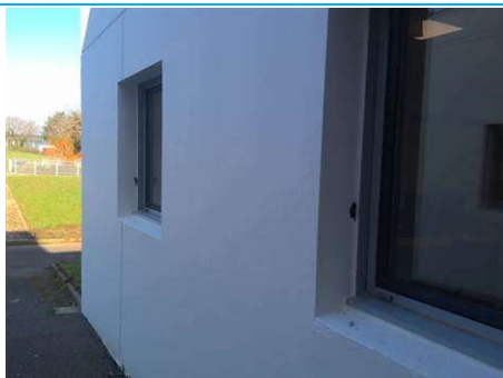
Matériaux : ZPSO-006 Prélèvement : P011; P013 Description : Joint d'étanchéité entre menuiserie et structure Localisation : EXTERIEURS - FACADE NORD Résultat : Absence d'amiante
