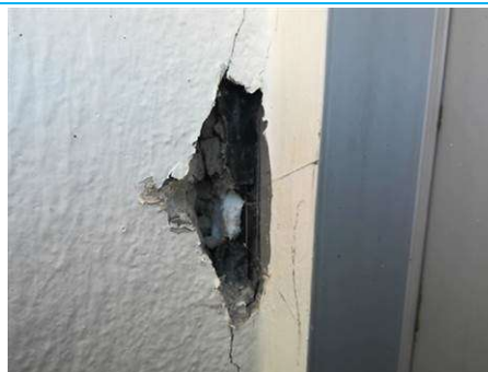
Matériaux : ZPSO-004 Prélèvement : P012 Description : Joint d'étanchéité entre menuiserie et structure Localisation : EXTERIEURS - FACADE NORD Résultat : Absence d'amiante
