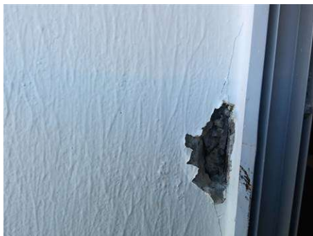
Matériaux : ZPSO-003 Prélèvement : P003 Description : Enduit extérieur (projeté, lissé ou taloché) Localisation : EXTERIEURS - FACADE NORD Résultat : Absence d'amiante
