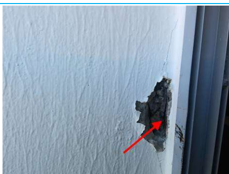
Matériaux : ZPSO-004 Prélèvement : P004 Description : Joint d'étanchéité entre menuiserie et structure Localisation : EXTERIEURS - FACADE NORD Résultat : Absence d'amiante
