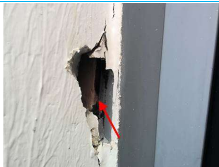
Matériaux : ZPSO-006 Prélèvement : P013 Description : Joint d'étanchéité entre menuiserie et structure Localisation : EXTERIEURS - FACADE NORD Résultat : Absence d'amiante
