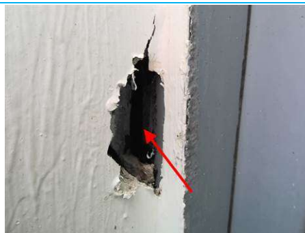
Matériaux : ZPSO-006 Prélèvement : P011 Description : Joint d'étanchéité entre menuiserie et structure Localisation : EXTERIEURS - FACADE NORD Résultat : Absence d'amiante
