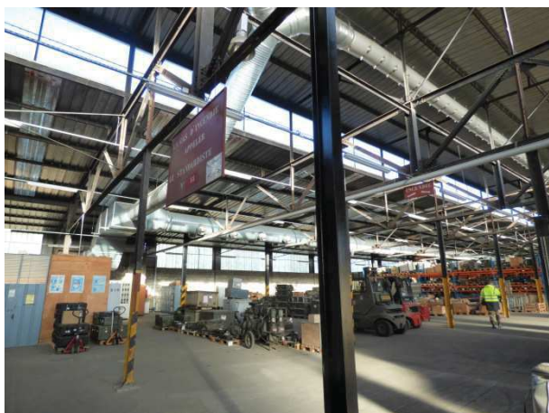
5 - Ferme treillis principale comprenant une surélévation sur toute la longueur du bâtiment
