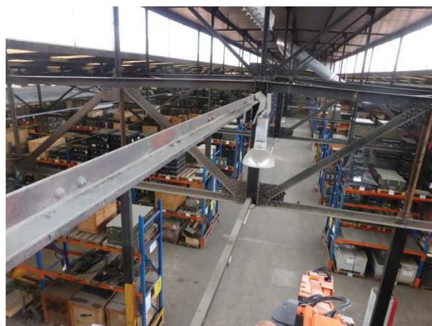
5 - Ferme treillis principale comprenant une surélévation sur toute la longueur du bâtiment
