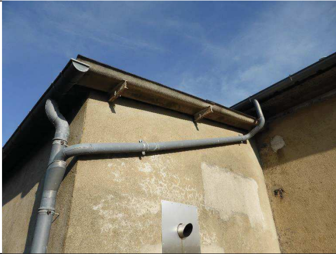
7 – Déversement dauphin EP sur dallage extérieur Dallage envahie par la mousse contre cloture.
