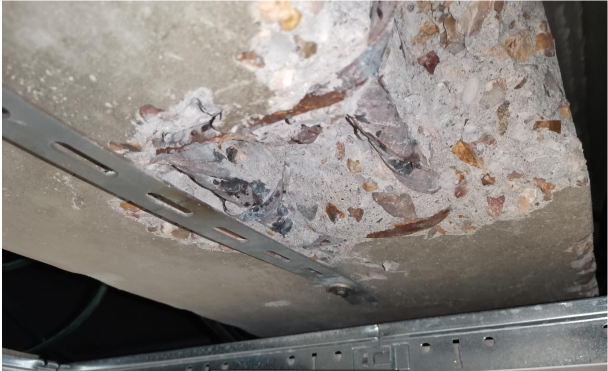
Sondage sous-face poutre
