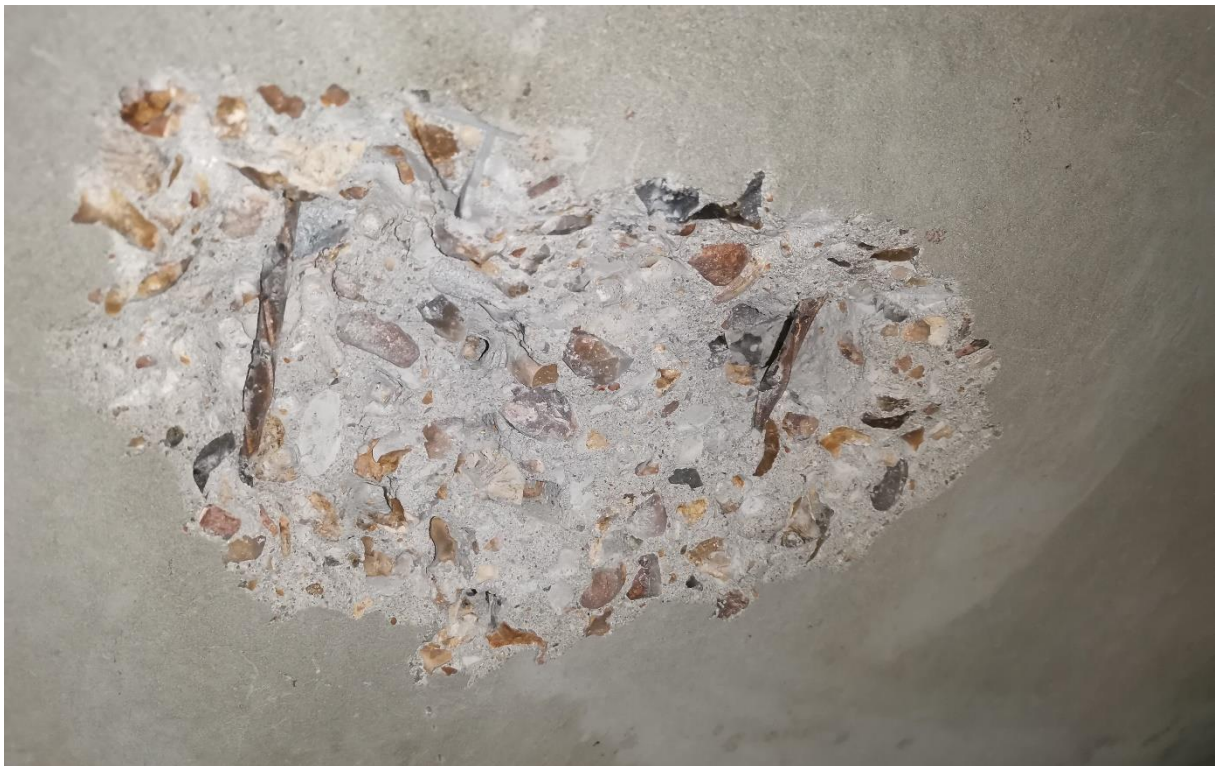
Sondage sous-face dalle
