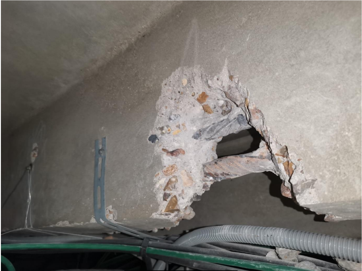
Sondage sur nervure dalle
