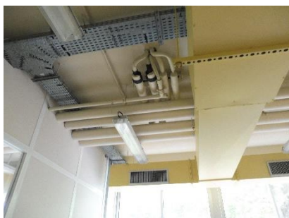
Réseaux d'alimentation des ventilo-convecteurs du R+2 en plafond du R+1
