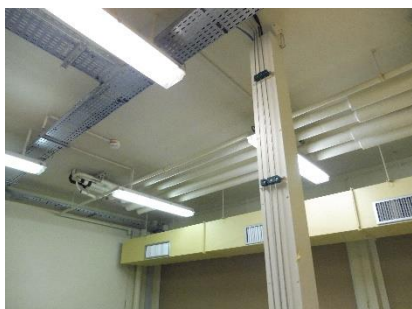
Réseaux d'alimentation des ventilo-convecteurs du R+2 en plafond du R+1
