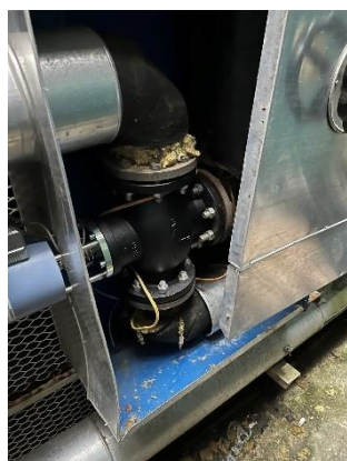
Vanne de régulation CTA Nord-Est
