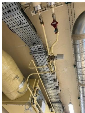
Réseau batterie terminale - Laboratoire
