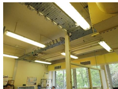
Réseaux d'alimentation des ventilo-convecteurs du R+2 en plafond du R+1
