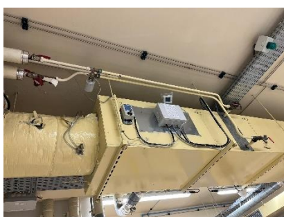
Batterie terminale - Laboratoire
