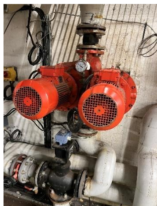
Pompe circuit terminaux labos + radiateurs – Circuit EC4
