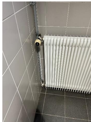
Radiateur vestiaires avec robinet ancien
