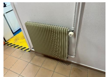
Radiateurs circulation avec robinet rénové
