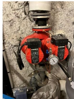
Pompe circuit radiateurs
