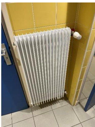
Radiateurs vestiaires avec robinet rénové
