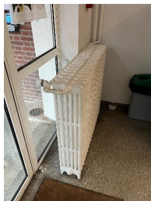
Radiateurs laboratoire avec robinet rénové
