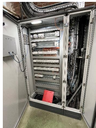
Armoire régulation – Vue intérieure
