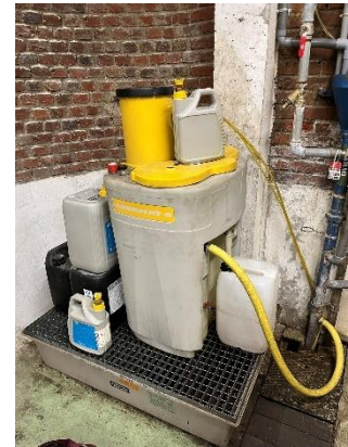
Traitement des condensats – Séparateur
