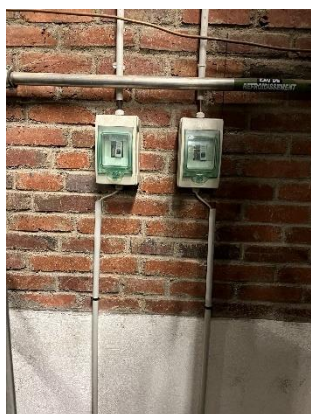
Coffrets disjoncteurs des purgeurs
