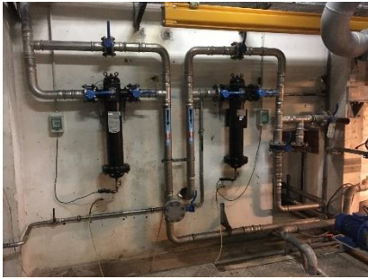
Filtres déshuileur et filtre particulaire
