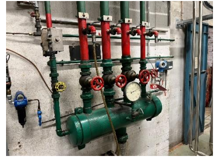
Nourrice de distribution air comprimé
