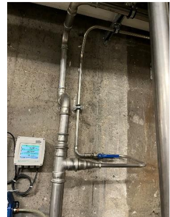
Départ air comprimé
