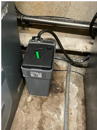
Traitement des condensats – Séparateur
