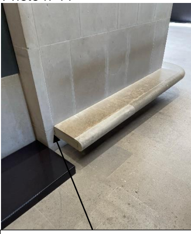
Pvt n°11 - Plâtre enduit / Mur derrière banc accueil - RDC Pavillon des sessions, amiante non détecté
