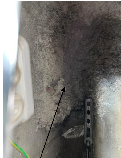
Pvt n°9 - Flocage plafond caisse - RDC Pavillon des sessions, amiante non détecté
