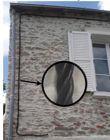
Réseau fils isolés façade BT
