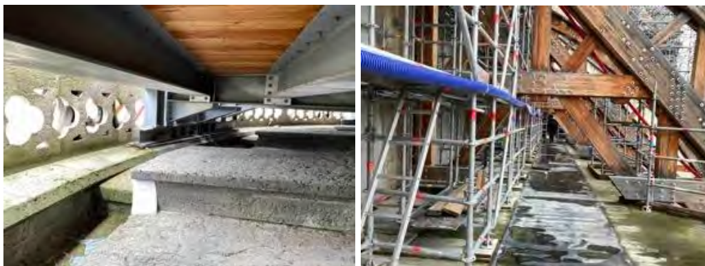
Figure 1 Plancher métallique-bois (vue de dessous et de dessus en 2024)
