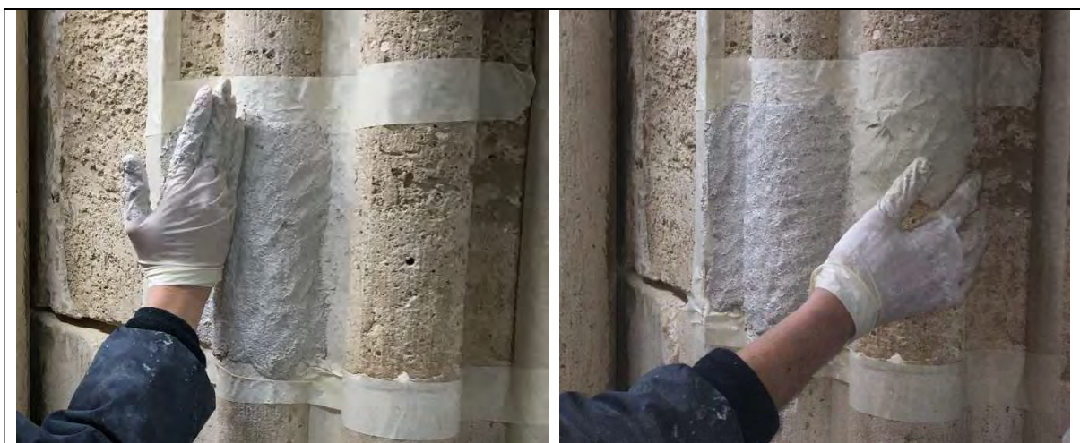
Figure 2 : Application des produits : la compresse K/S à gauche) a besoin d'être maintenue quelques secondes au contact du support pour amorcer son adhésion. La compresse C/K/S adhère très bien au jeté et s'étale plus facilement.
