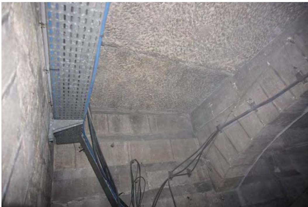
Figure 43 Dalles de pierre et des arcs surbaissés de la terrasse basse à l'aplomb des chapelles
