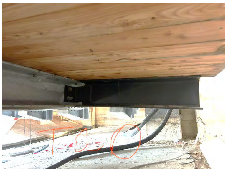
Plancher T20 / T18 : Flèche excessive des consoles, torsion des poutres de reprise Déchargement des zones en console à prévoir
