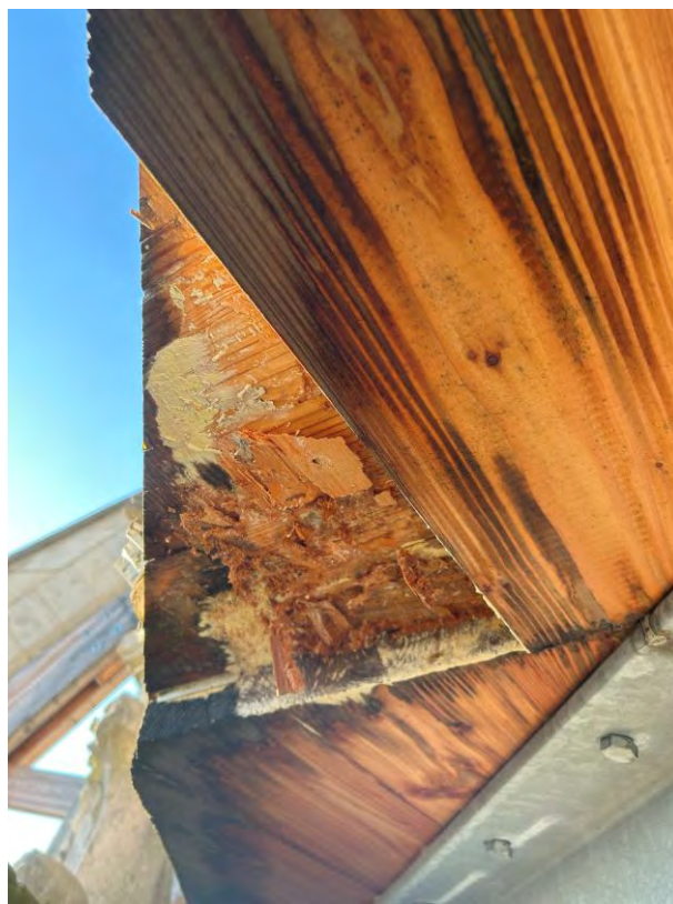
Développement de champignon sur les planchers CLT
