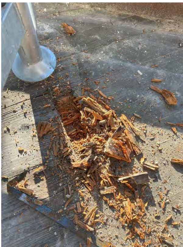
Plancher CLT : délamination entre lame, couche supérieure en très mauvais état Intégrités des panneaux compromise
