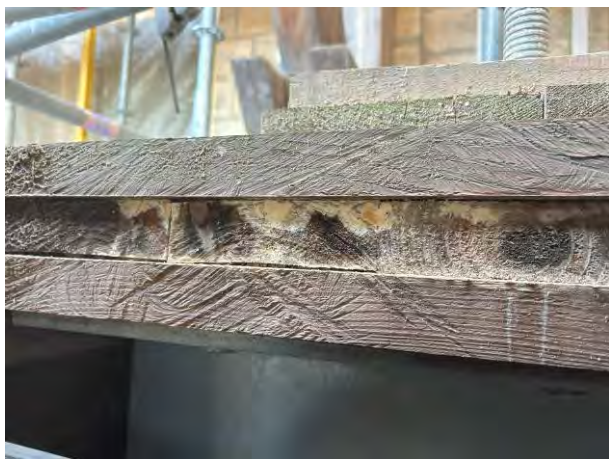
Développement de champignon sur les planchers CLT
