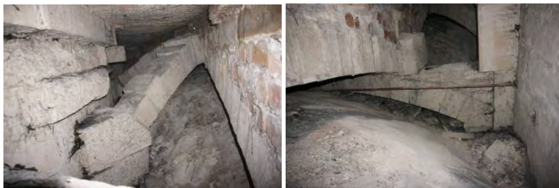
Figure 16 Arcs surbaissés portant la terrasse et tirants métallique reprenant leur poussée (l'extrados de la voûte visible est celui des voûtes des tribunes)
