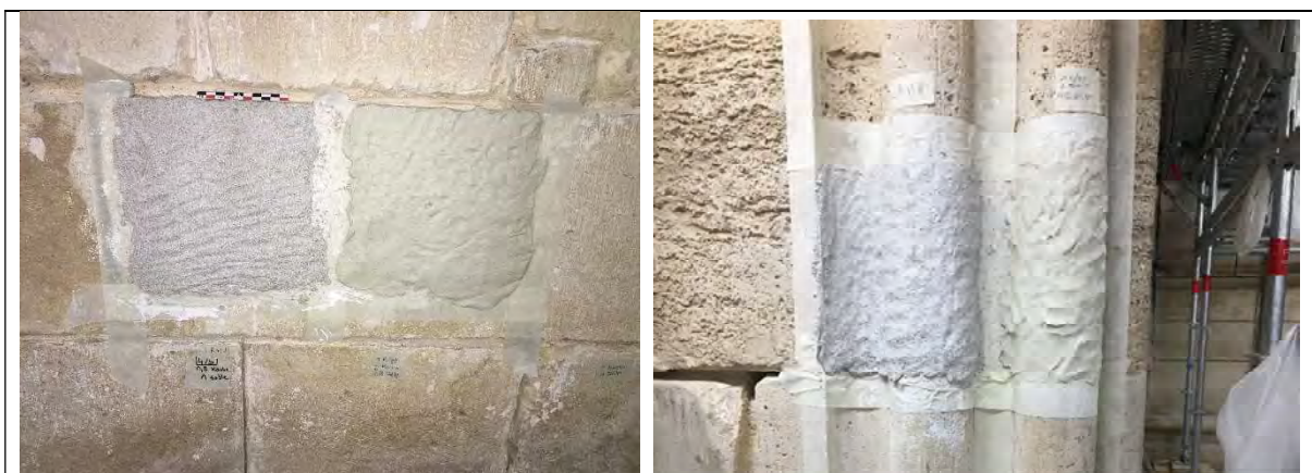
Figure 1 : Aspect des compresses après application sur le parement ouest et sur les colonnes engagées ouest à l'entrée de la chapelle Notre-Dame de Guadalupe.
