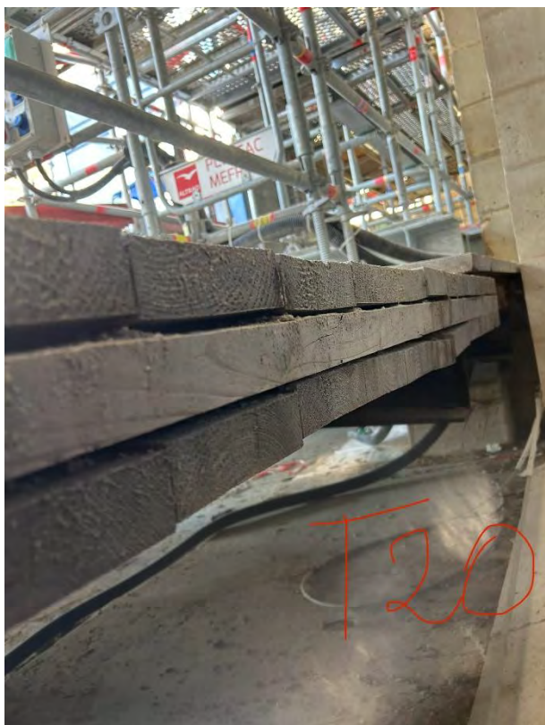
Plancher CLT : délamination entre lame, couche supérieure en très mauvais état Intégrités des panneaux compromise
