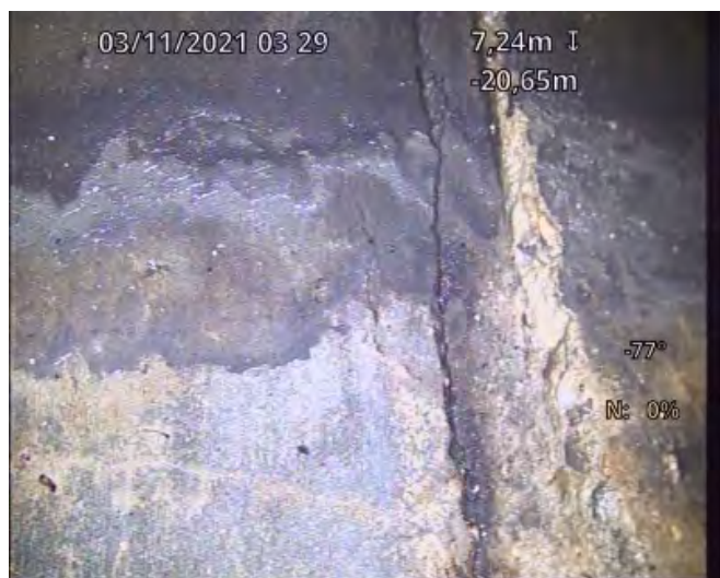
Photo img00217_003.jpg Position 7,24 m Vidéo 00:02:17 Code BAB Fissure, Micro fissure, Circonférentielle, Largeur de la fissure : 5mm, de 8 à 11 heure, Photo capturée
