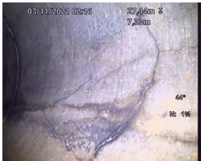
Photo img00319_005.jpg Position 27,44 m Vidéo 00:03:19 Code BAB Fissure, Micro fissure, Hélicoïdale, Largeur de la fissure : 0mm, de 2 à 4 heure, Fissure apparente Exfiltrante non confirmé, Photo capturée
