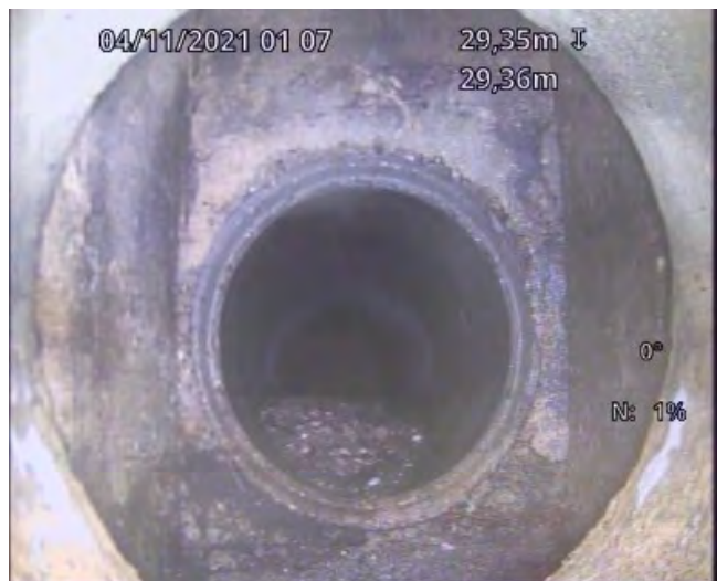
Photo img01140_006.jpg Position 29,35 m Vidéo 00:11:40 Code BCE Référence du noeud d'arrivée, Regard de visite, Référence du noeud: 6Nom, Coordonnées du noeud: 0Coordonnées , dommages au niveau de l'assemblage des tuyaux, le dommage de la section nr. 1 commence ici, Arrivée GR6
