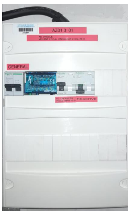
Coffret électrique AZ01.3.01 à énergie ondulée situé au sein des services EFR-RR au N-2
