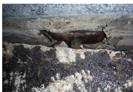
Figure 2 : Désordre entre l'appui béton et le voile - Fixation acier apparent
