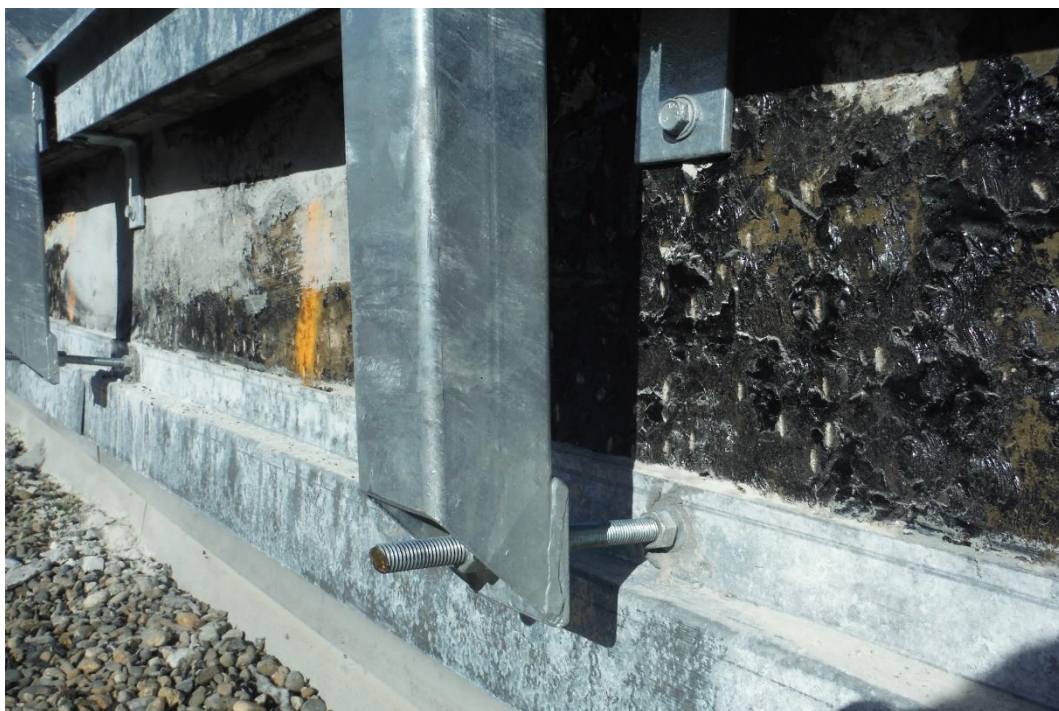
Photo 9 : conflit solin – ancrage de la solution 4
