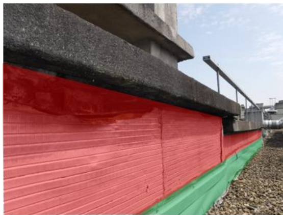
Figure 6 : principe de positionnement du larmier
