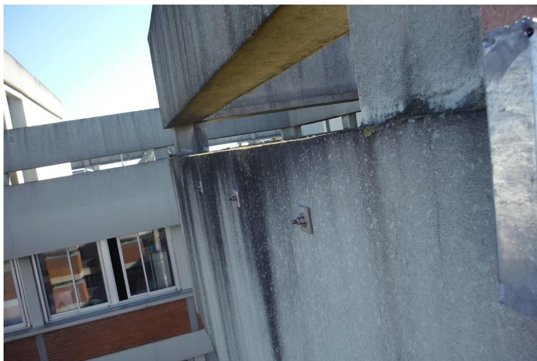
Photo 2 : Ancrage coté extérieur solution 3
