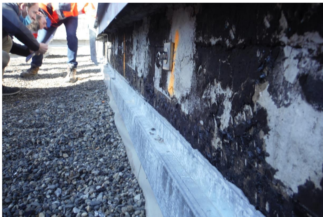
Photo 6 : Solin métallique de protection de l'étanchéité
