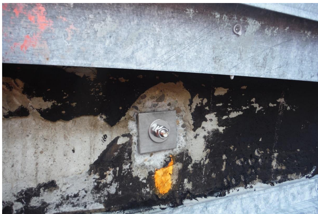
Photo 1 : Ancrage coté intérieur solution 3
