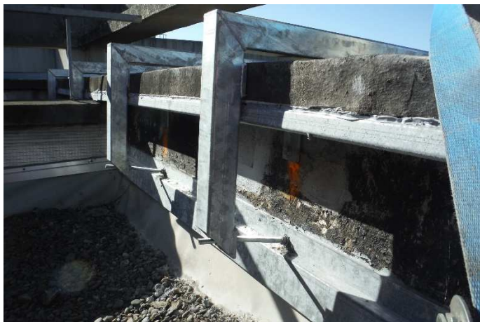
Figure 3 : Aucun discontinuité du larmier placé en dessous de l'appuie
