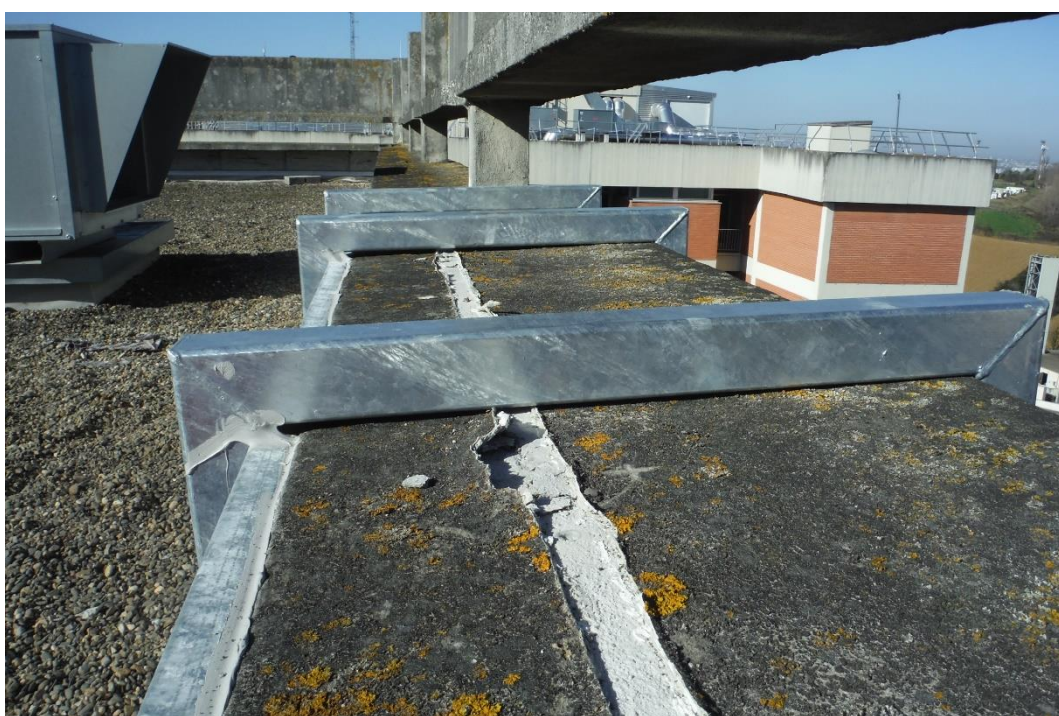
Photo 10 : conflit larmier en face avant – ferronnerie de la solution 4
