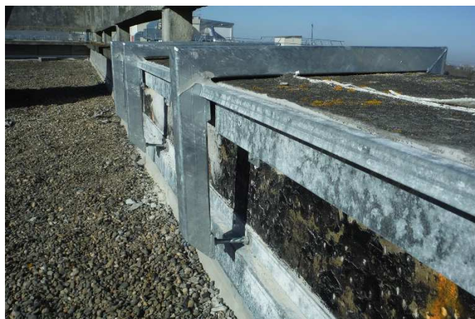
Figure 4 : Discontinuité du larmier placé sur la tranche de l'appuie
