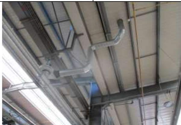
Bâtiment 0102 – vue système d'évacuation gaz vers l'extérieur
