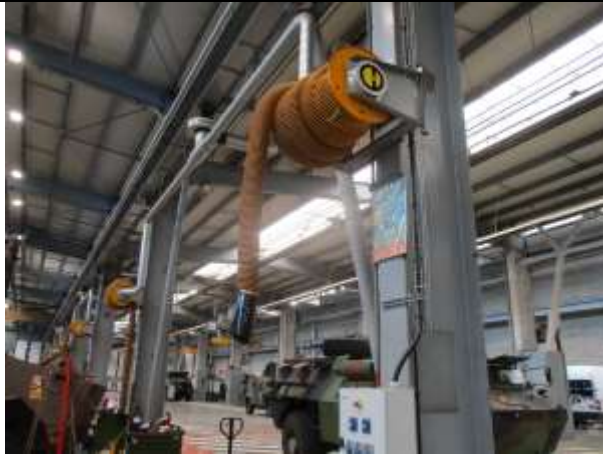
Bâtiment 0102 – vue système de captation des gaz
