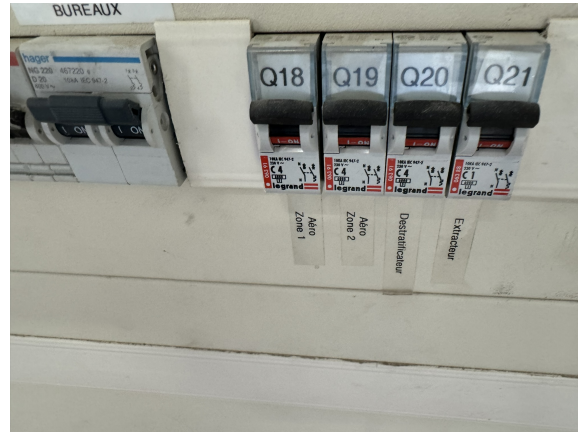
Départ aérothermes gaz et destratificateurs
