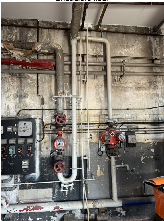
Départ panneaux rayonnant à déposer
