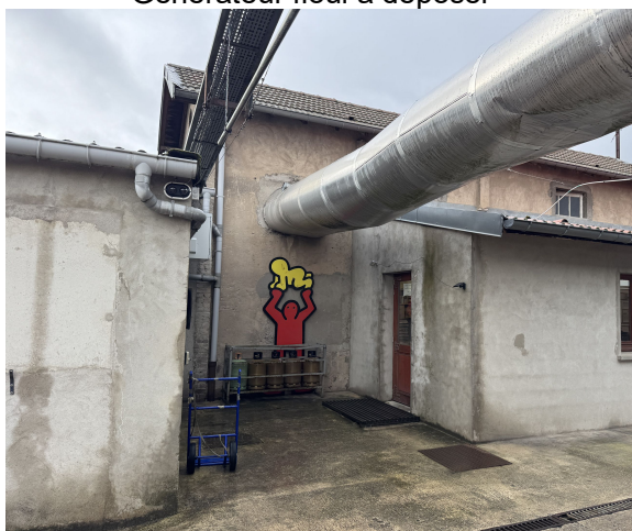
Gaines à déposer et orifice à obturer
