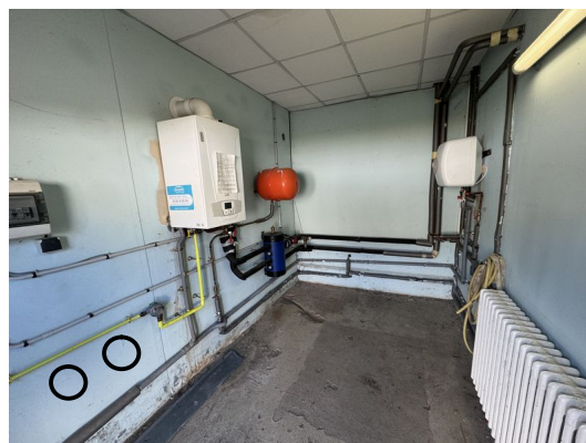
Pénétration à côté de la chaudière
