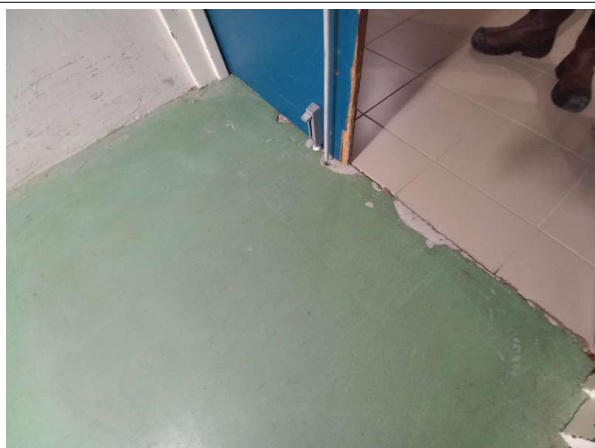
prélevé - idem P009 : C.P.A.M des Flandres / REZ-DE-JARDIN / Archives contrôle des Prest n°040 et 027 - Sol coulé- (Absence d'amiante)
