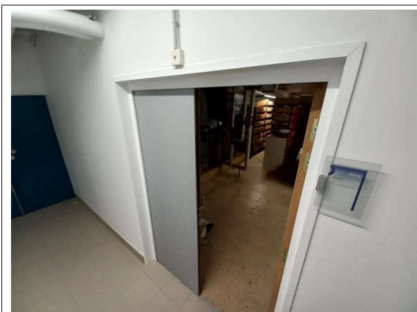
Déclaré - : C.P.A.M des Flandres / REZ-DE-JARDIN / Archives AT n°018 - Panneau de cloison- (Absence d'amiante)
