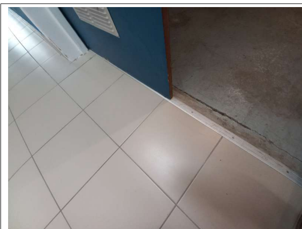
déclaré - : C.P.A.M des Flandres / REZ-DE-JARDIN / Local surpresseurs n°002 - Colle de carrelage- (Absence d'amiante)
