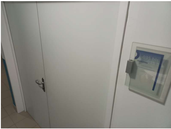
Prélèvement - P013 : C.P.A.M des Flandres / REZ-DE-JARDIN / Stockage Patri n°035 B - Panneau de cloison- (Absence d'amiante)
