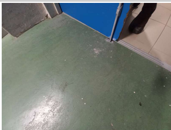
Prélèvement - P009 : C.P.A.M des Flandres / REZ-DE-JARDIN / Archives contrôle des Prest n°042 et 024 - Sol coulé- (Absence d'amiante)
