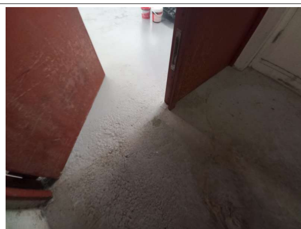
Prélèvement - P039 : C.P.A.M des Flandres / R+6 / Palier locaux techniques - Sol coulé- (Présence d'amiante)
