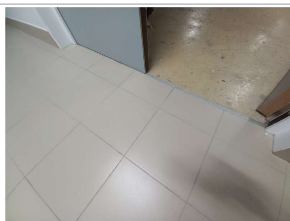
Déclaré - : C.P.A.M des Flandres / REZ-DE-JARDIN / Archives AT n°018 - Colle de carrelage- (Absence d'amiante)
