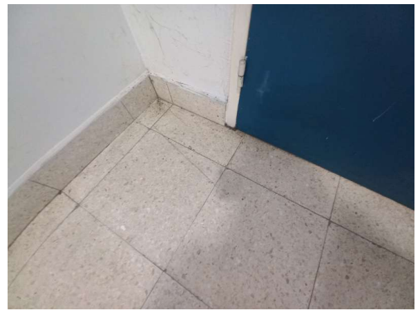
Prélèvement - P017 : C.P.A.M des Flandres / REZ-DE-JARDIN / Cage d'escalier NORD - Colle de carrelage- (Absence d'amiante)
