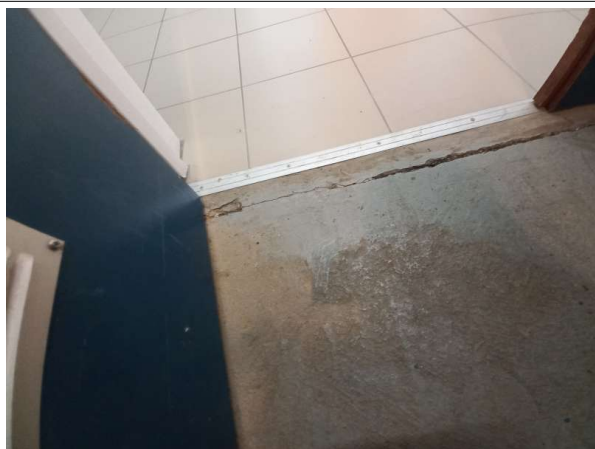
Prélèvement - P007 : C.P.A.M des Flandres / REZ-DE-JARDIN / Local surpresseurs n°002 - Sol coulé- (Absence d'amiante)
