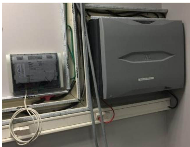
Exemple de centrale d'appel malade et UTL de contrôle d'accès fixées sur le mur
