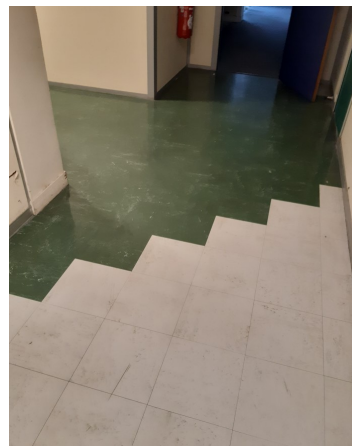
déclaré - : R+2 / CIRCULATION - Dalle de sol - EP- (Présence d'amiante)
