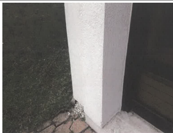
Déclaré - : RDC / FACADES - Enduit - BE- (Présence d'amiante)
