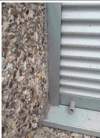
Déclaré - : RDC / FACADES - Mastic - BE- (Présence d'amiante)
