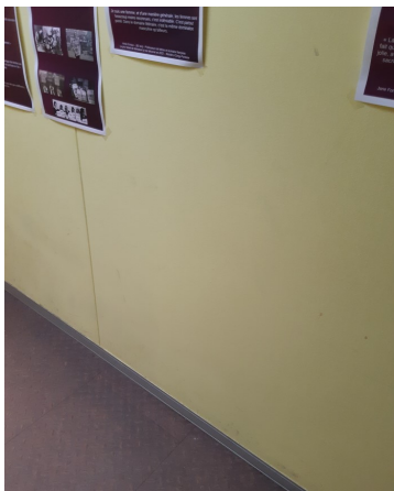
Déclaré - : R+2 / BUREAUX - Enduit - BE- (Présence d'amiante)
