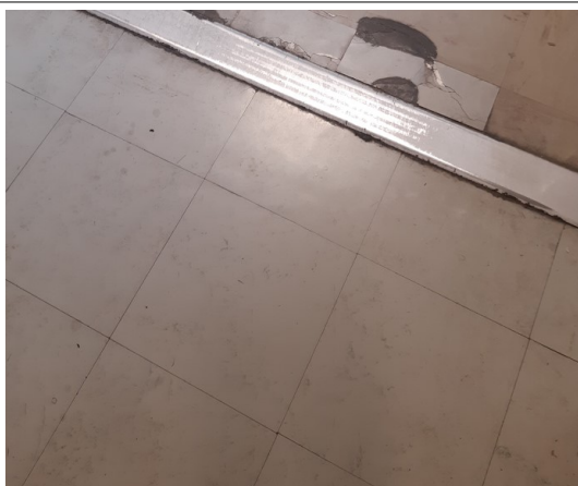
Déclaré - : RDC / BUREAUX - Dalle de sol - EP- (Présence d'amiante)
