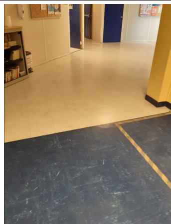
déclaré - : R+1 / CIRCULATION - Dalle de sol - EP- (Présence d'amiante)
