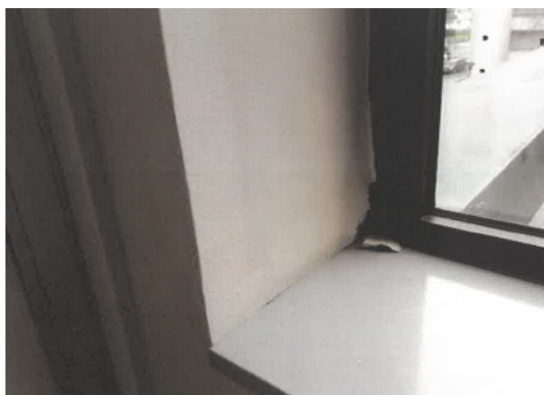
Déclaré - : R+2 / BUREAUX - Enduit - BE- (Présence d'amiante)
