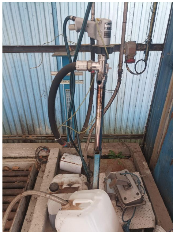
Photographie 3 : détail utilités extérieures - fûts sur balance et pompe de transfert
