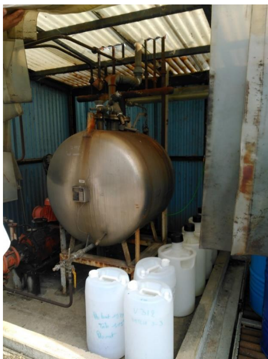
Photographie 2 : détail utilités extérieures - cuve Xylène
