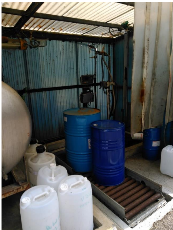
Photographie 3 : détail utilités extérieures - fûts sur balance et pompe de transfert
