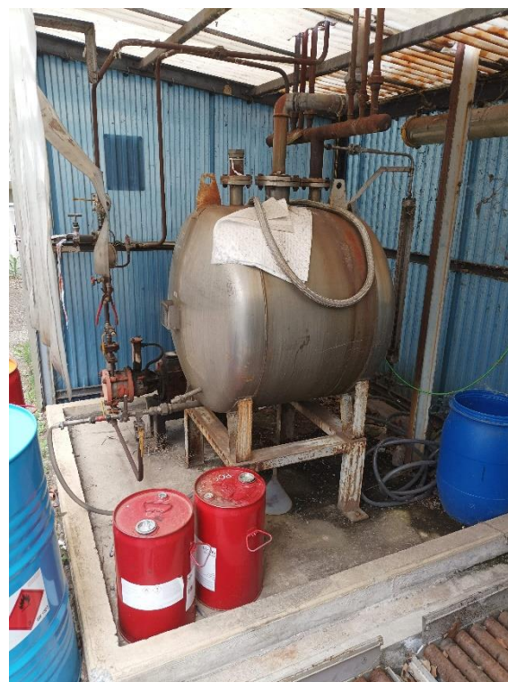
Photographie 2 : détail utilités extérieures - cuve Xylène
