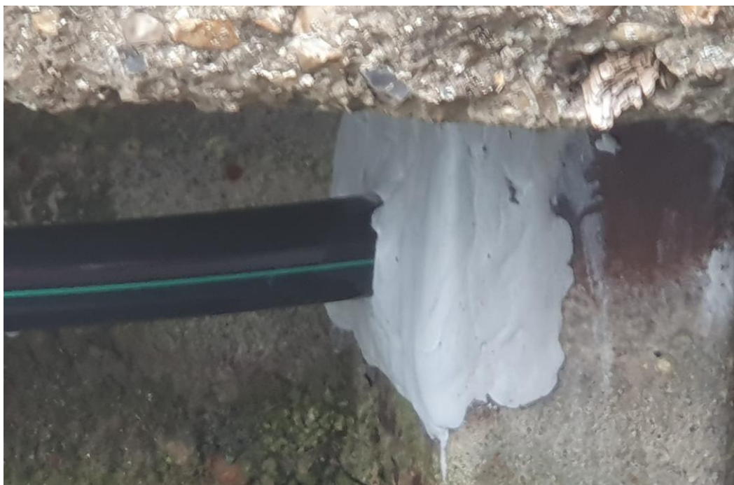
Résine époxydique autour d'un perçage de palplanche
