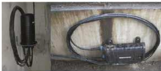
Exemple de lovage et de boîte d'épissures (BPEO)
