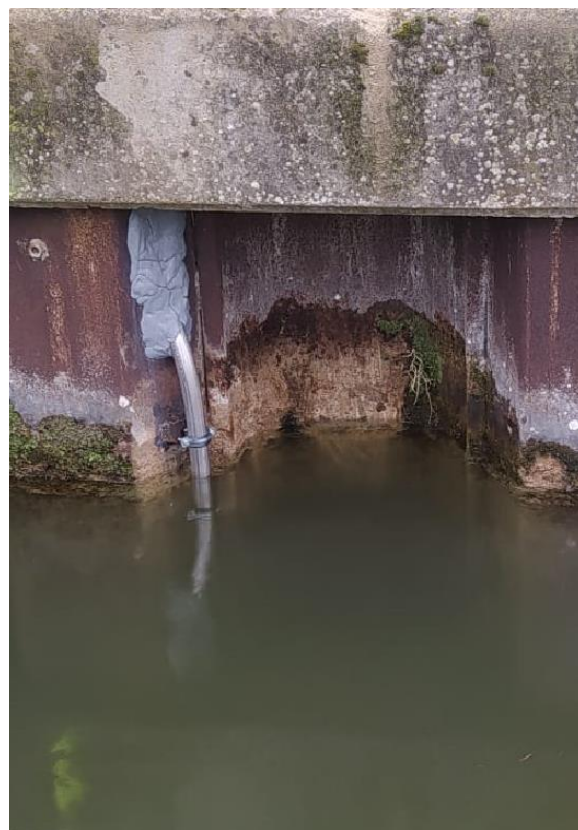
Tube inox de remontée sur palplanche
