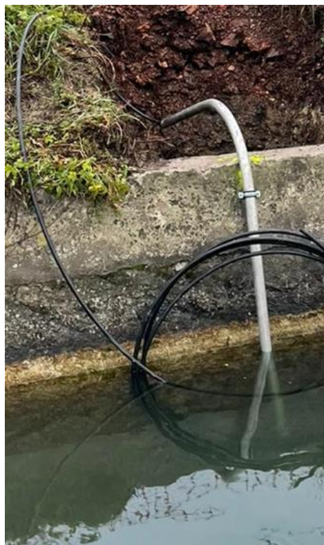
Tube inox de remontée sur perré béton
