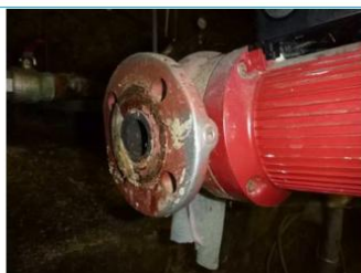
Matériaux : ZPSO-003 Prélèvement : P003 Description : Joint plat prédécoupé pour brides Localisation : Sous-Sol - Vide sanitaire Résultat : Présence d'amiante Quantité :
