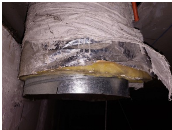
N RDC / Ancien réfectoire / Enveloppe de calorifuge [ Prélèvement n°2]
