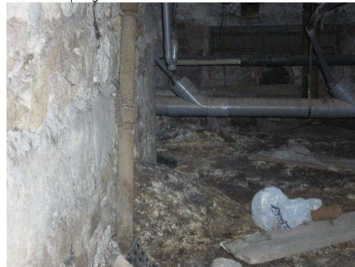
Composant : Conduit de fluide (eau) tuyaux PVC et fonte Vide sanitaires
