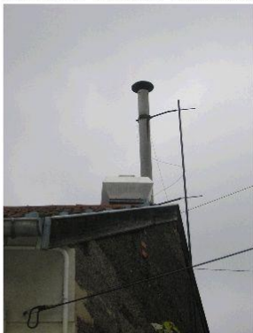
Composant : Conduit de cheminée tuyau amiante ciment En toiture (côté pignon Sud)
