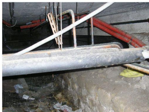
Composant : Calorifugeage coquille mousse polyuréthane Vide sanitaire
