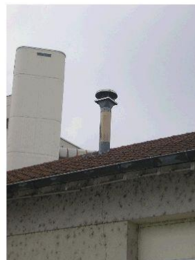
Composant : Conduit de fluide (air) tuyau amiante ciment En toiture (près du faîtage)
