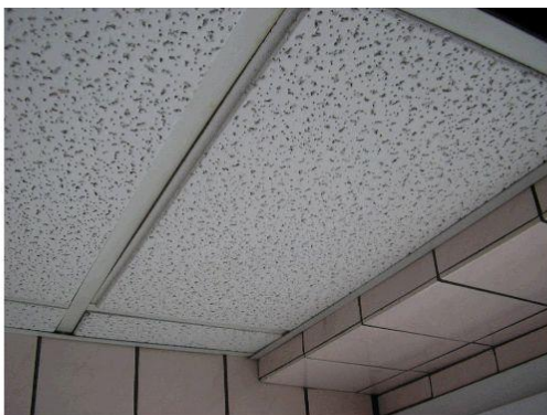
Composant : Faux plafond 60/60 fibres de roche et cellulose RdC sanitaires WC, idem self, grande et petite salle à manger
