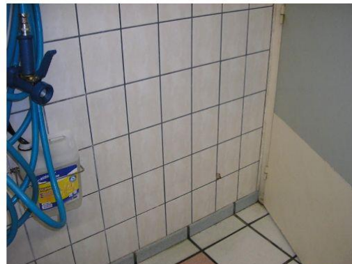
Composant : Colles des carrelages mural 15/20 banc veiné ( présence d'amiante ) RdC plonge
