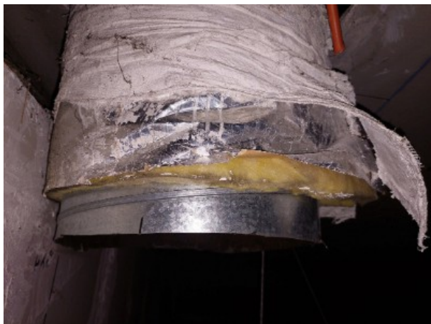
N RDC / Ancien réfectoire / Calorifuge [ Prélèvement n°1]
