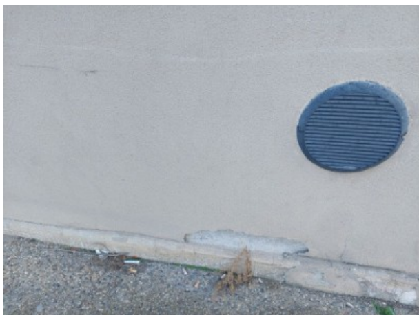
N Façade / Façade Ouest / Enduit projeté pied de mur [ Prélèvement n°4]
