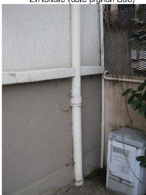
Composant : Conduit de fluide (eau) tuyau PVC et dauphin fonte En façades extérieures
