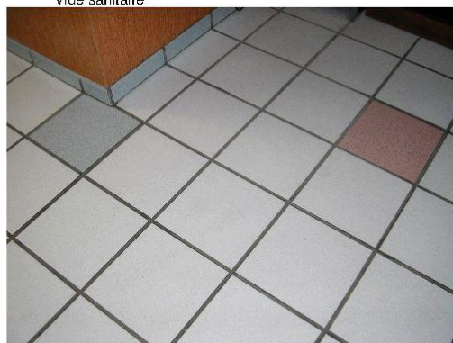
Composant : Colles des carrelages sol 30/30 blanc, gris et rose et chape maigre ( sans amiante ) RdC grande salle à manger, idem l'ensemble des locaux RdC
