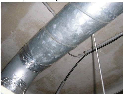
Composant : Conduit de fluide (air) tuyau métal galvanisé RdC sanitaires WC (plenum), idem dans l'ensemble des locaux RdC
