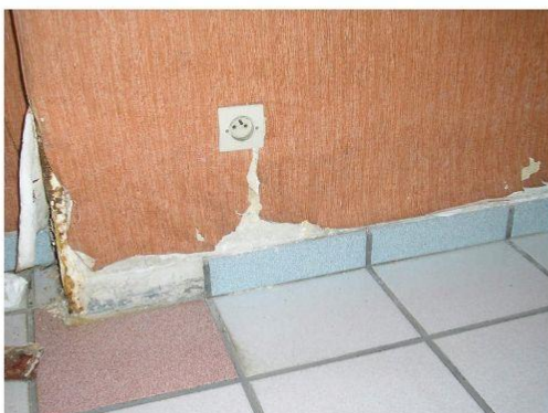
Composant : Colles des carrelages plinthe 8/30 gris ( sans amiante ) RdC self, idem entrée coin bureau, sanitaires WC grande et petite salle à manger
