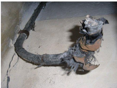
Composant : Câbles électriques résistant au feu ancien câbles dans plénum ( sans amiante ) RdC sanitaire WC (plénum)
