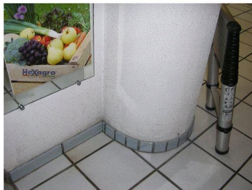
Composant : Enduits projetés enduit projeté mur blanc ( sans amiante ) RdC entrée self, idem coin bureau et self
