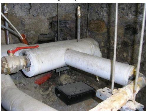
Composant : Calorifugeage laine de verre sous enveloppe PVC Vide sanitaire
