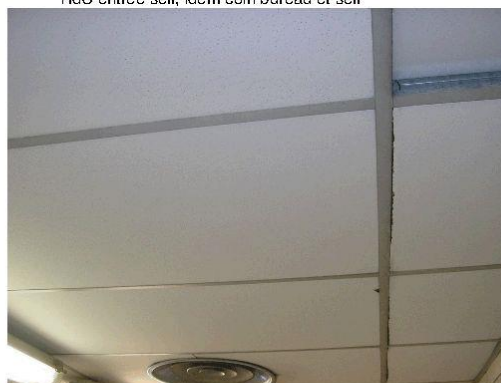
Composant : Faux plafond 60/120 fibres de roche et cellulose RdC plonge
