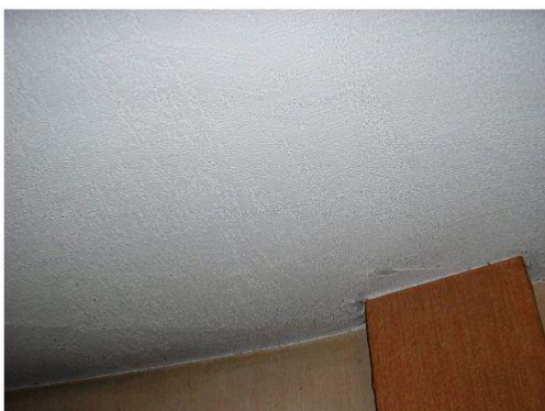
Composant : Enduits projetés enduit projeté plafond blanc ( sans amiante ) RdC entrée self
