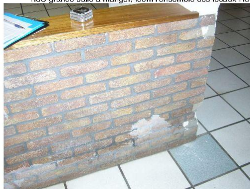
Composant : Colles des carrelages mural 5/20 brique ( sans amiante ) RdC self, idem grande salle à manger
