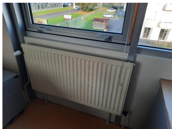
Radiateurs existants en allège sur façades
