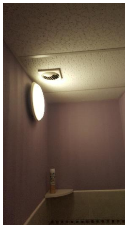
Bouche VMC existante en plafond des sanitaires
