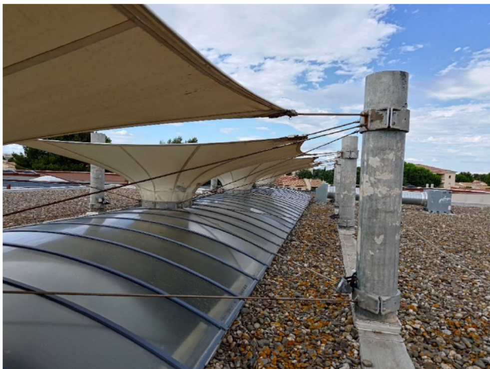
Vue extérieure de la toiture vitrée du patio avec les toiles d'ombrage
