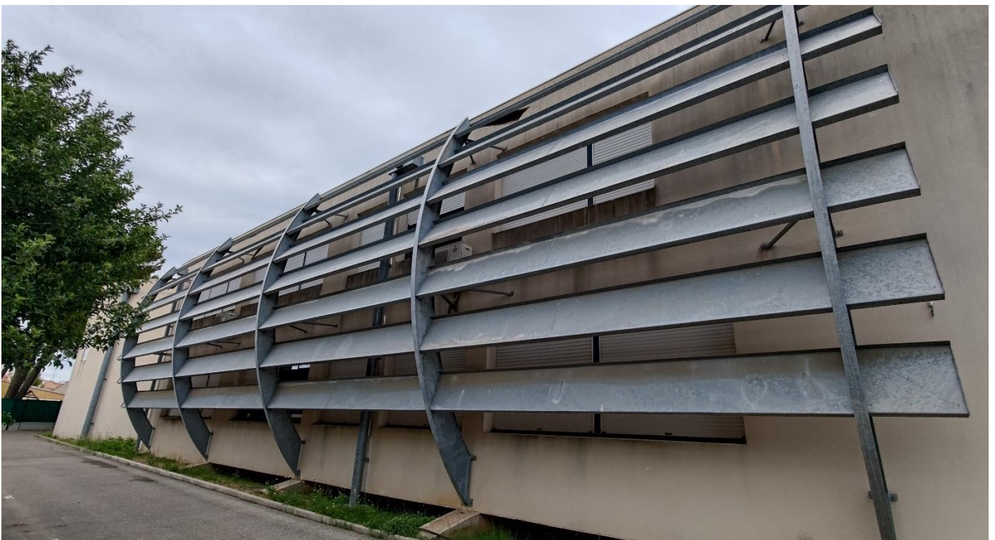
La façade ouest de la fac de droit est équipée d'un important brise soleil.
