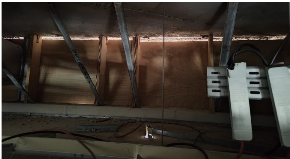
Mur extérieur de la cafeteria vue dans le faux plafond : manque d'isolation et d'étanchéité à l'air
