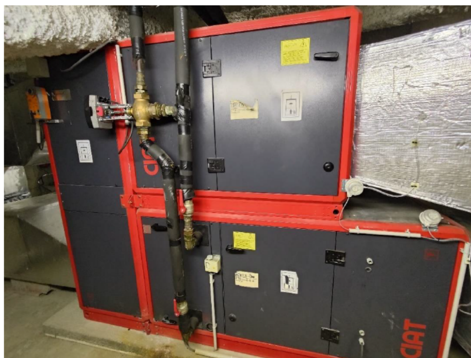
CTA CIAT du grand Amphi. En bas le caisson de soufflage. En haut le caisson de reprise. Au centre, la vanne 3 voies motorisée qui régule le débit d'eau dans la batterie de chauffage. A gauche le caisson de mélange.
