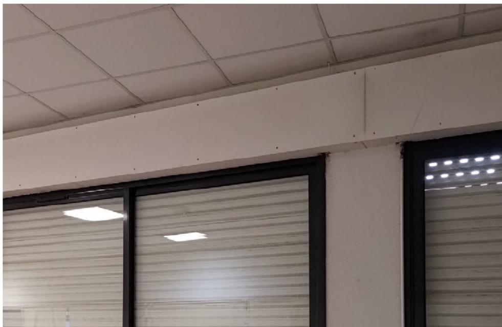
Coffres de volets roulants isolés dans la partie IUT
