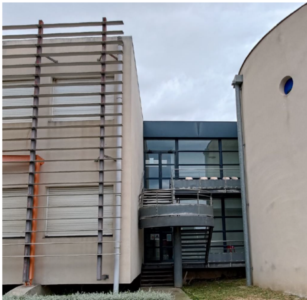
Façade Sud-Est : La façade rideau ne dispose d'aucune protection extérieure
