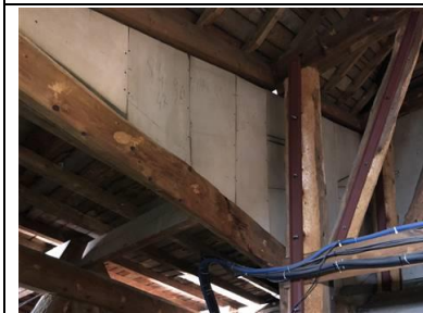
Photo n° PhA012 Localisation : 4ème étage - Comble Ouvrage : 3 - Parois verticales intérieures - Revêtements de murs, poteaux, cloisons, gaines, coffres Partie d'ouvrage : Panneau en fibre-ciment Description : Panneau en fibre-ciment Localisation sur croquis : Point012
