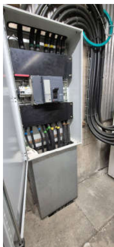
Coffret de raccordement du GE existant du poste centre
