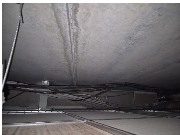
Figure 11 Vue des dalles alvéolaires précontraintes dans les plénums
