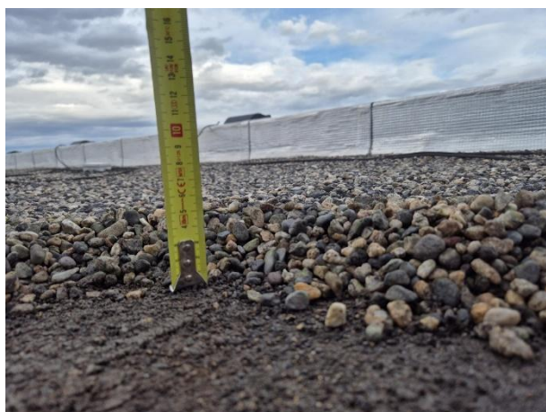
Fig. 40 - Vue de l'épaisseur de protection en gravillons
