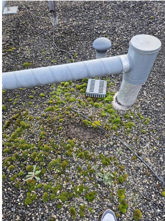
Fig. 44 - Vue d'apparition de mousse à proximité des exutoires
