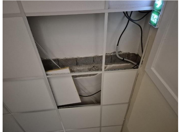
Figure 6 Vue de la sous-face de structure béton en poutrelle-hourdis
