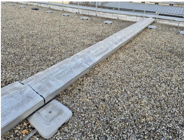
Figure 18 Vue du joint de dilatation en partie supérieure (relevé d'étanchéité), comportement et disposition conforme
