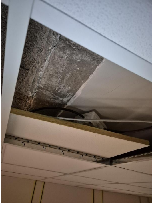
Figure 5 Vue de la sous-face de structure béton en poutrelle-hourdis
