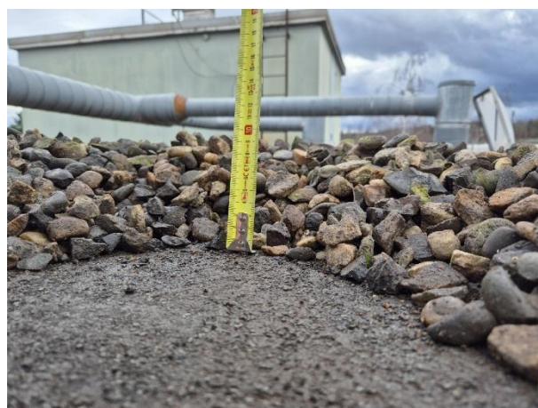
Fig. 37 - Vue de l'épaisseur conséquente de gravillons
