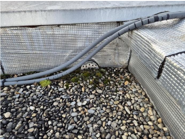
Figure 21 Les évacuations d'eaux pluviales ne sont ni bouchées ni altérées sauf certaines qui nécessitent un entretien.
