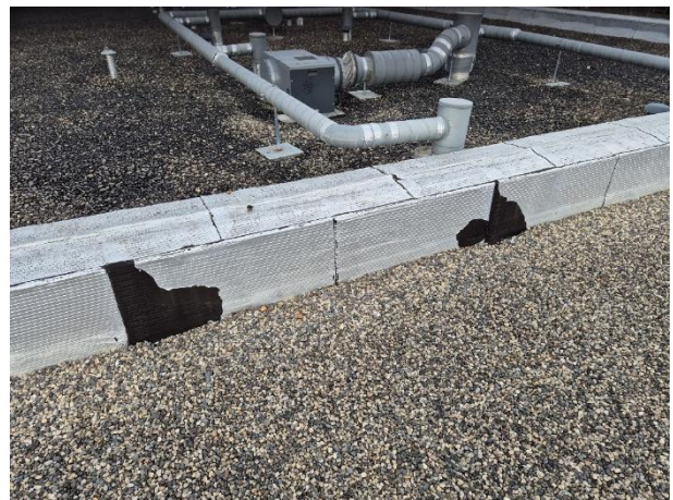
Fig. 42 et 43 - Vue en relevé d'étanchéité paxalu localement altéré
