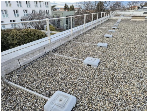
Figure 22 Présence de garde-corps auto lestés sur chacune des toitures terrasses
