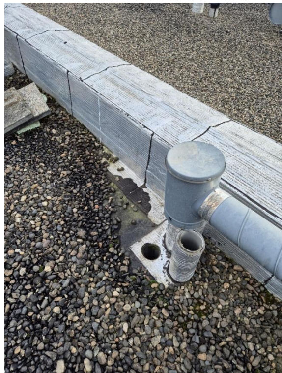
Fig. 45 et 46 – Constat de présence de mousse non généralisé
