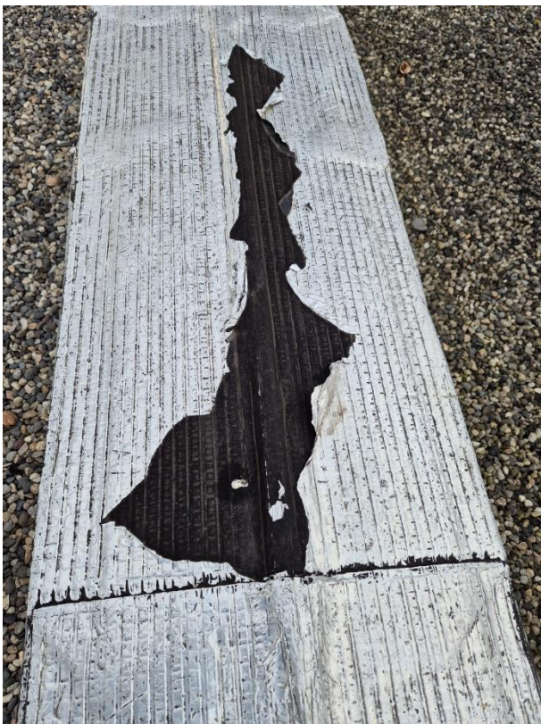
Fig. 42 et 43 - Vue en relevé d'étanchéité paxalu localement altéré
