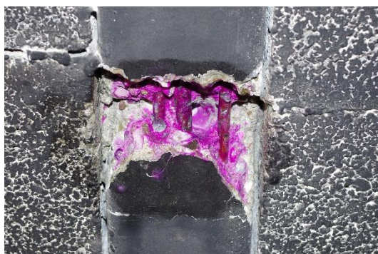
Fig. 10 - Exemple d'un sondage destructif réalisé au droit d'une poutrelle avec observation du ferrailage et mesure d'épaisseur de béton carbonaté
