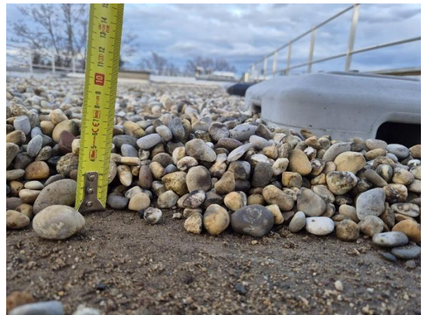
Figure 19 Vue de détail et mesure de l'épaisseur des gravillons
