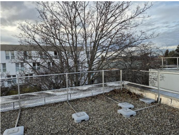
Figure 23 Nécessité d'entretien pour enlever la végétation qui commence à s'accumuler dans l'angle à cause de l'arbre qui devra être taillé
