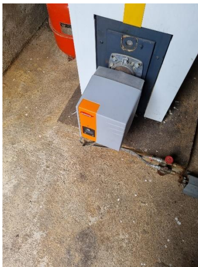
Chaudière fioul, brûleur et réseau fioul
