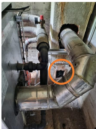
Porte d'accès et ventilations de la chaufferie
