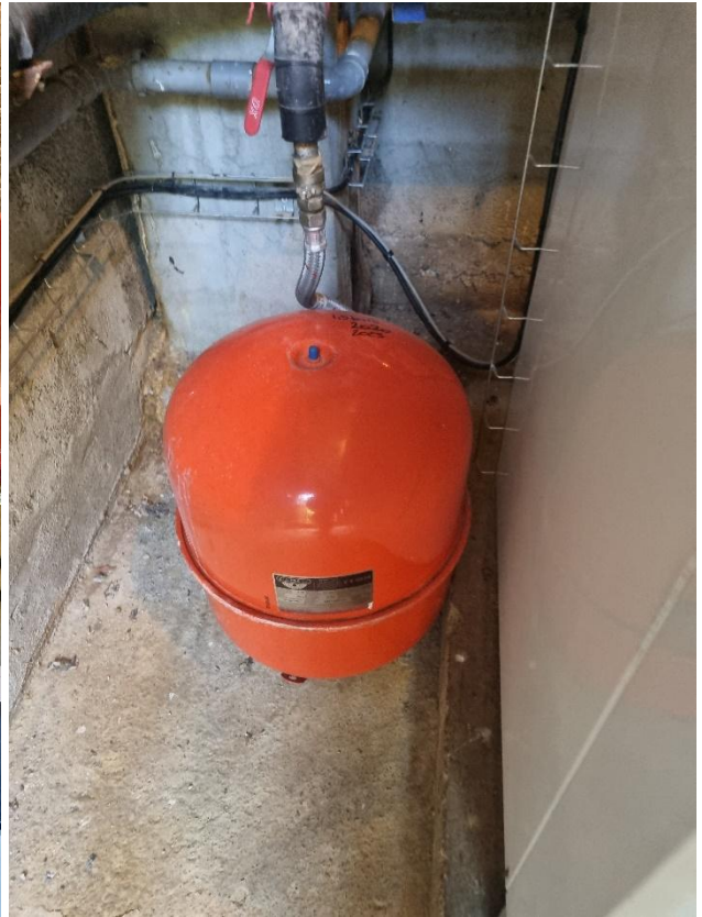
Réseaux de chauffage et vase d'expansion
