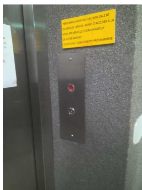
Commande palière du niveau principal
