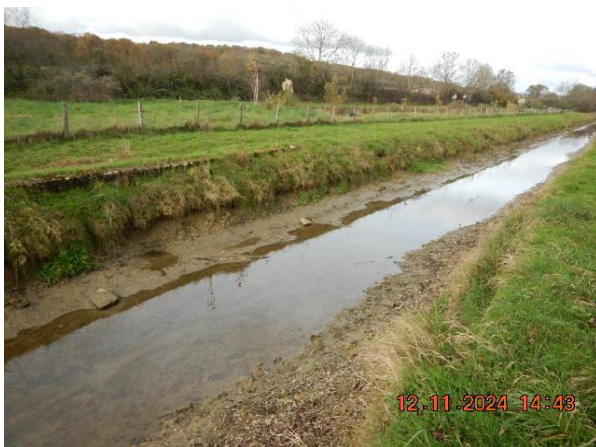
Berges érodées avec dalots en béton ou empierrements
