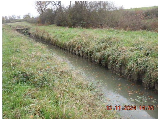
Berges érodées avec dalots en béton, empierrements ou palplanches
