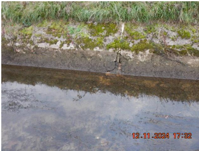
Photos de la seconde section avec béton dégradé
