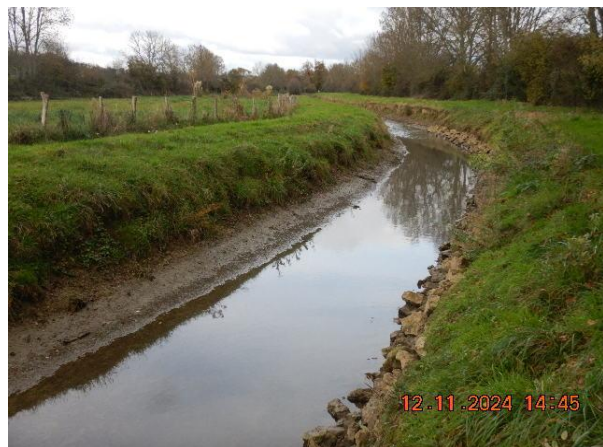
Berges érodées avec dalots en béton ou empierrements
