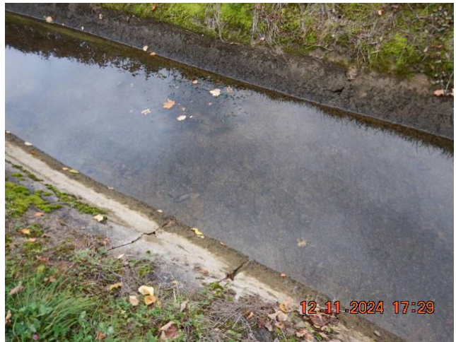
Photos de la seconde section avec béton dégradé
