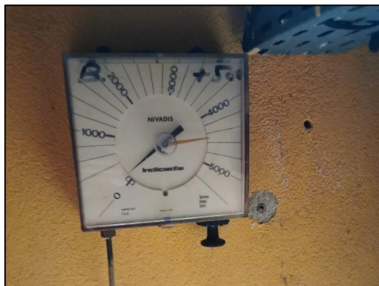
Photographie 5 : Jauge du réservoir enterré de 5 m³ de FOD associé à la chaufferie
