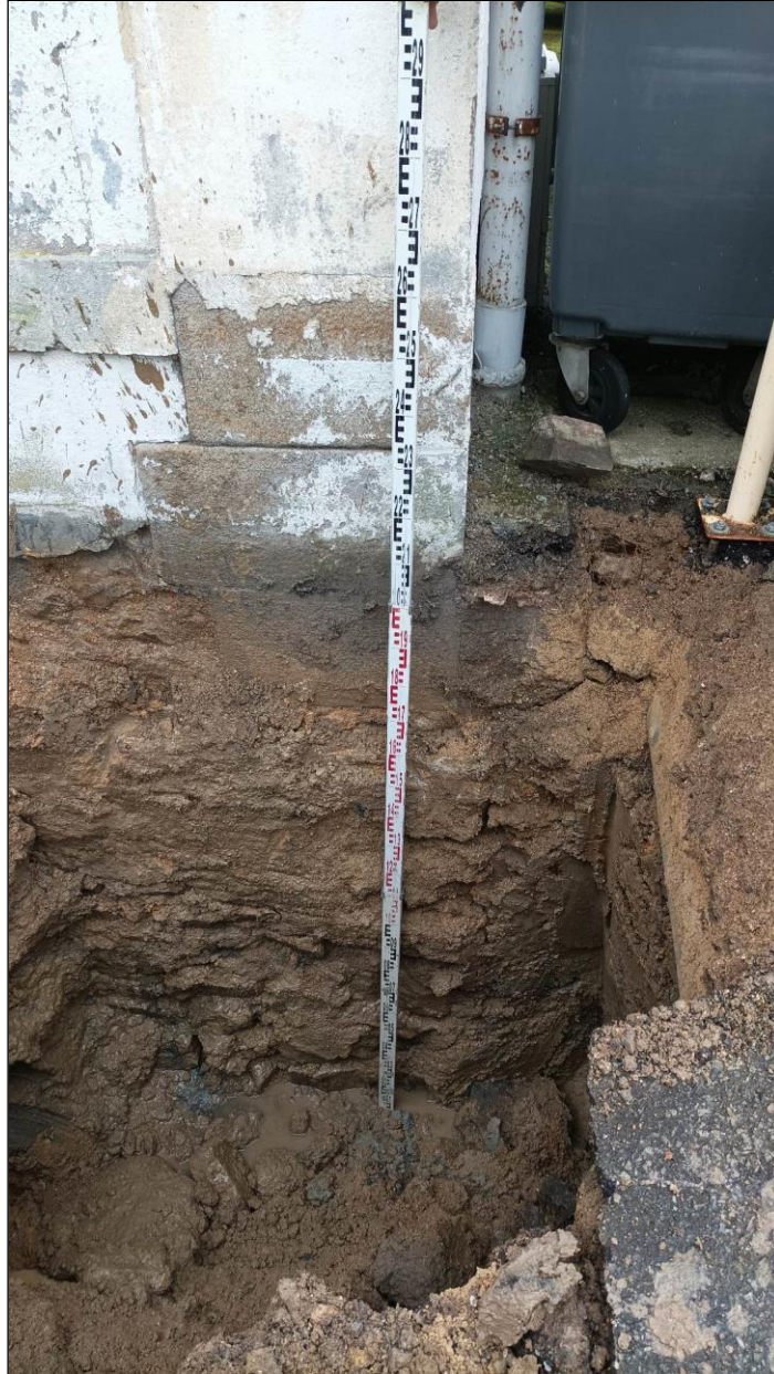
Figure 6 : Photographie de la reconnaissance de fondation RF3
