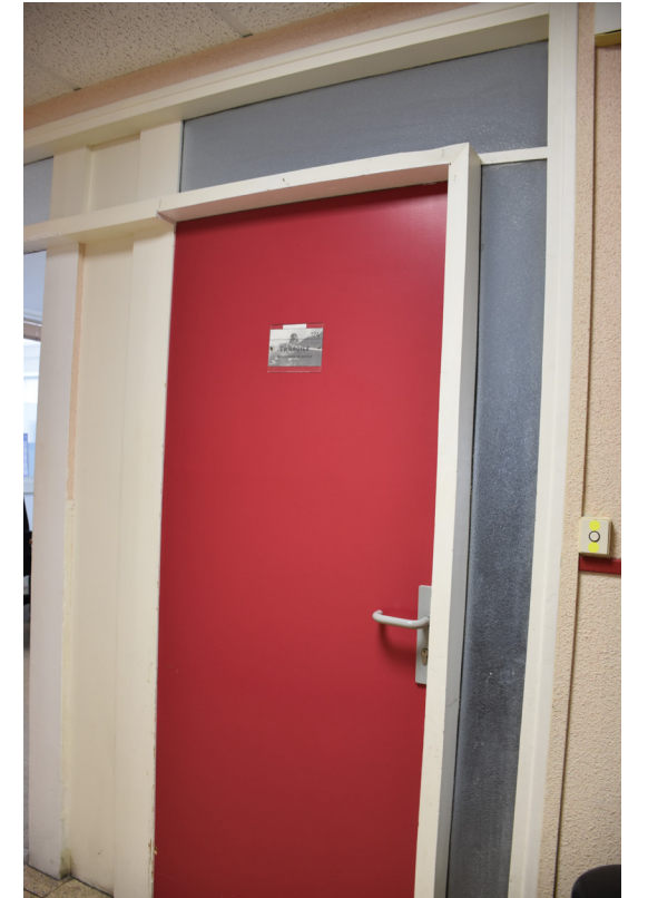
Porte existante avec imposte vitrée
