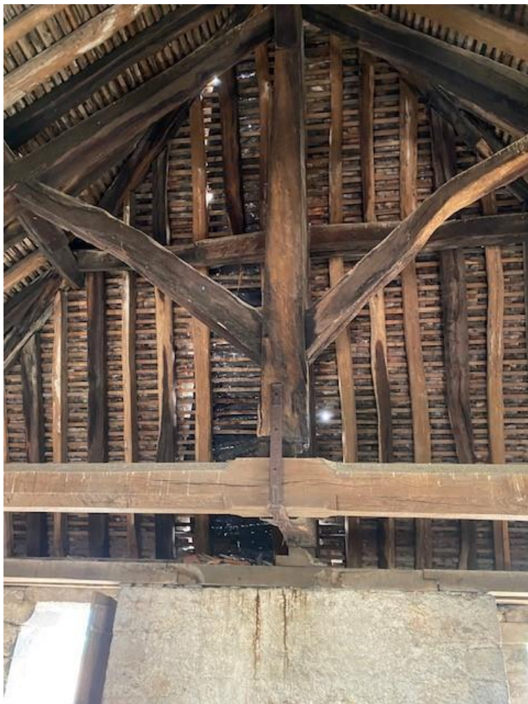
Vue de la charpente dégradée par l'impact de l'orage après mise en place d'une protection provisoire
