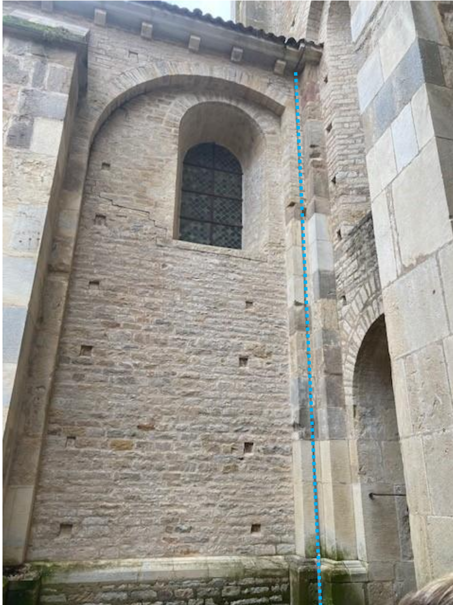
Vue de la descente du parafoudre du clocher de l'Eau Bénite
