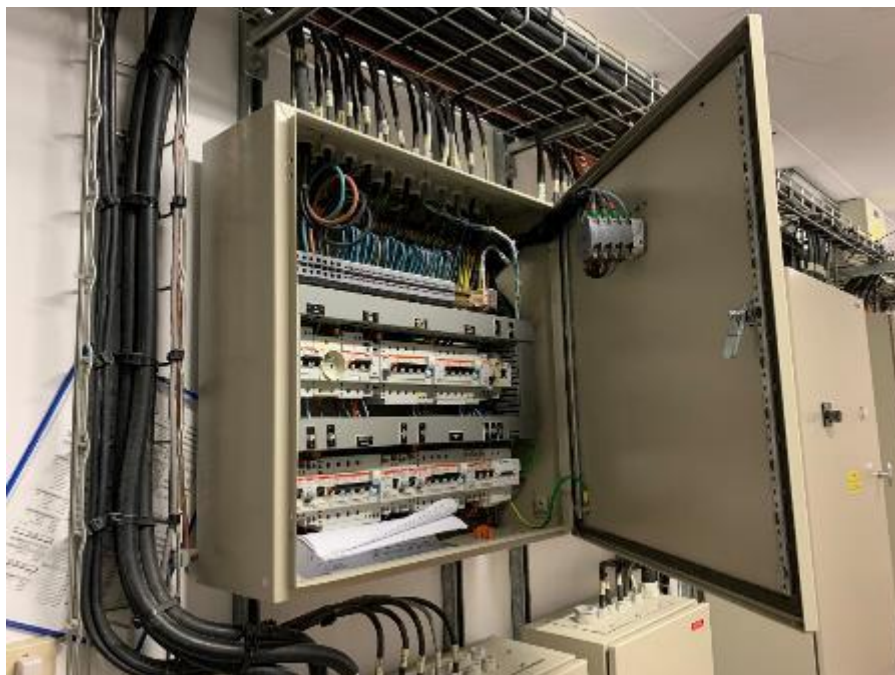
« Exemple coffret T2-2 qui ne disposent pas suffisamment de réserve pour ajouter un inverseur en tête. »
