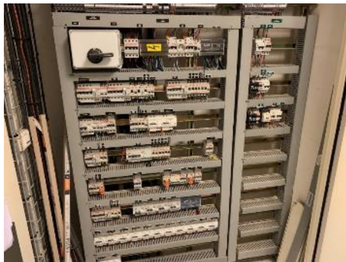
« Exemple armoire de niveau T1.4 - insertion d'un inverseur possible mais avec réorganisations des équipements et du câblage. »
