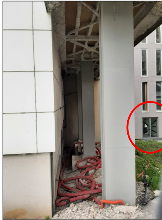
Issue de secours maintenue durant la déconstruction de la passerelle P3
