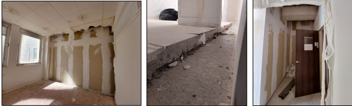
Photo d'une zone tampon et de la limite de désamiantage au niveau des sols
