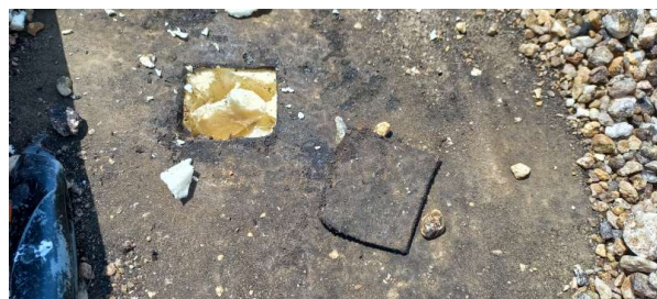
Prélèvement - P002 : Bâtiment MCO / Extérieur / Toiture - Pare-vapeur- (Absence d'amiante)
