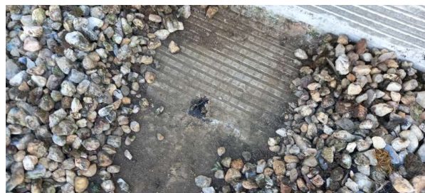
Prélèvement - P003 : Bâtiment MCO / Extérieur / Toiture - Relevé d'étanchéité- (Absence d'amiante)
