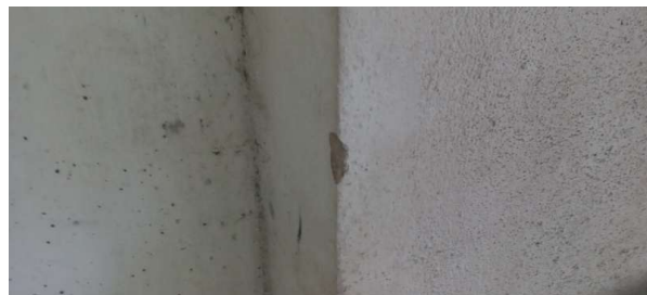
Prélèvement - P006 : Bâtiment MCO / Extérieur / Façades - Enduit- (Absence d'amiante)
