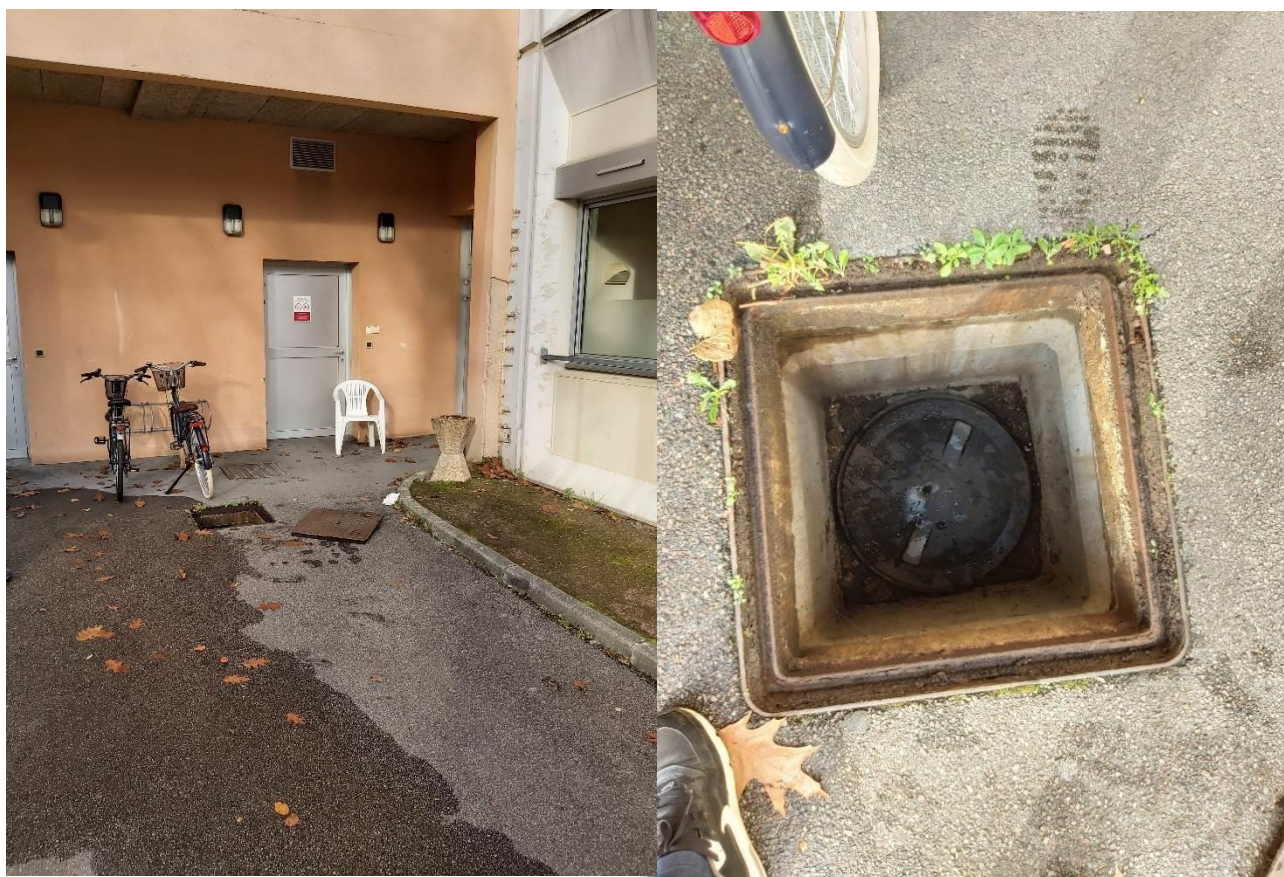
Photo 4 : Bac à graisse accessible en extérieur coté Flaubert
