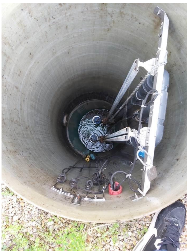
Photo 9 : Pompe de relevage UNACOR accès extérieur
