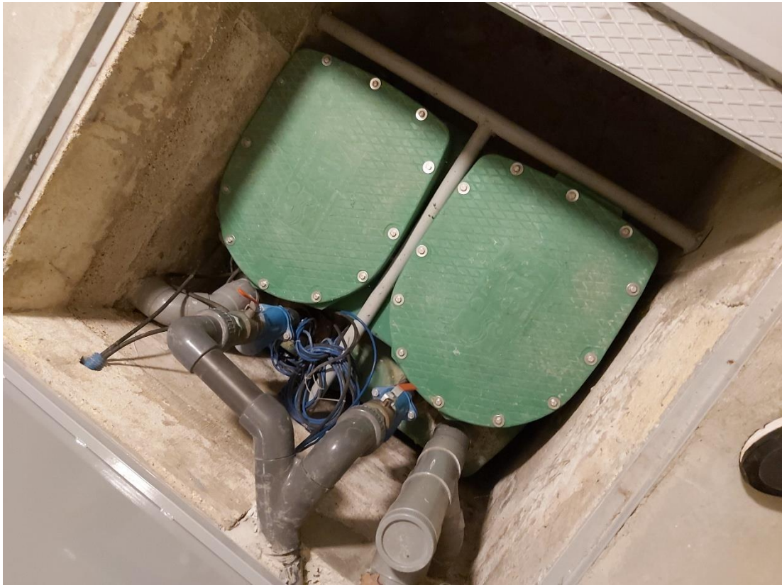
Photo 5 : Pompes de relevage accessible R-1 coté Monet
