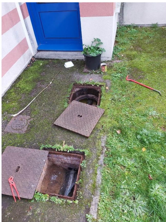
Photo 6 : Accès extérieur bac à graisse - UREHA
