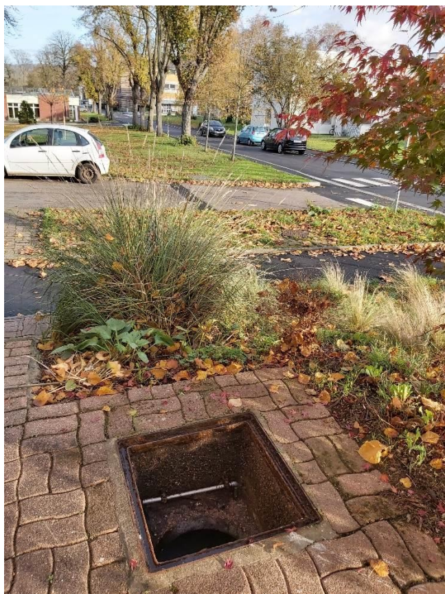
Photo 5 : Accès plaques bacs à graisse UPC
