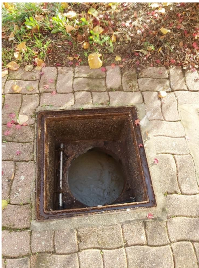
Photo 5 : Accès plaques bacs à graisse UPC
