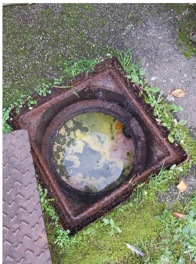
Photo 6 : Accès extérieur bac à graisse - UREHA
