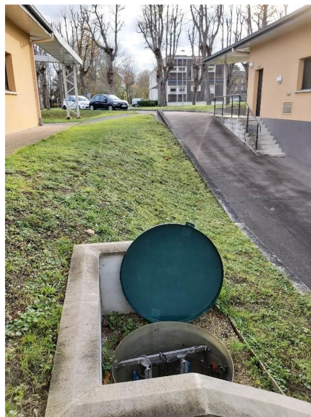
Photo 9 : Pompe de relevage UNACOR accès extérieur
