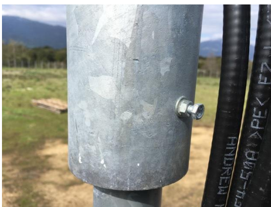
Pièce d'adaptation galvanisée mât DME
