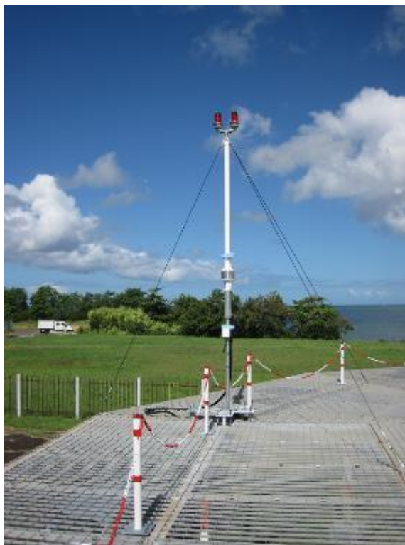
Exemple de montage du mât support DME haubané en bordure de contrepoids
