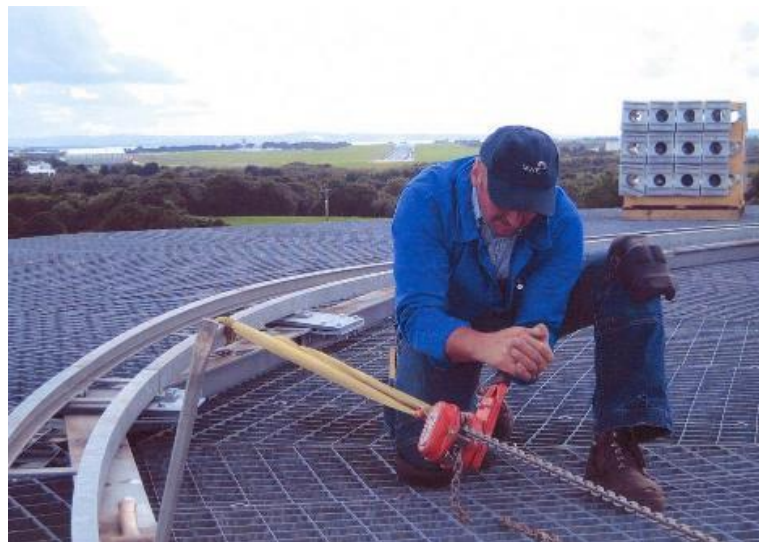
Montage d'un anneau de contrepoids (image non contractuelle)
