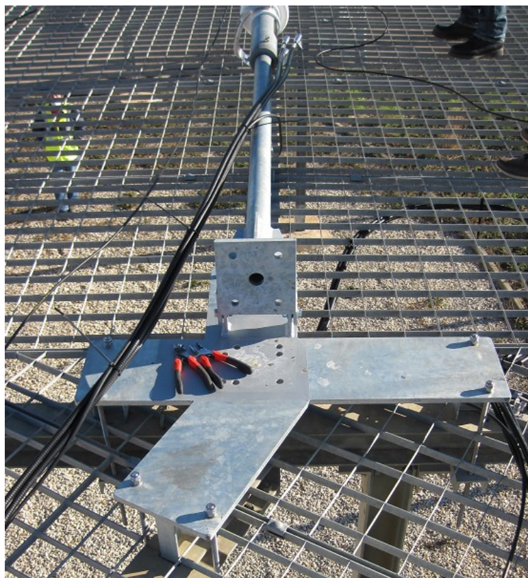
Support Modifié pour basculement latéral sur contrepoids Thomson
