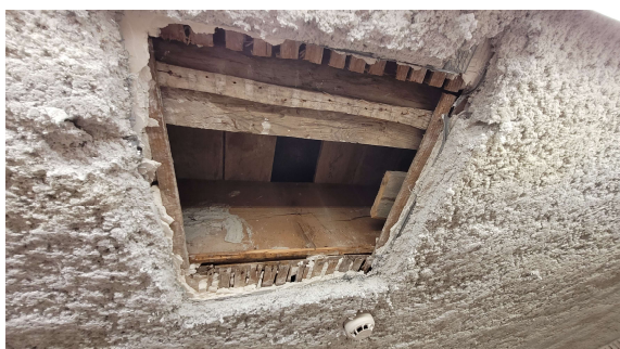
Sous-face de plancher – sondage S3
