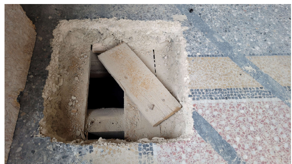
Finition plancher – sondage S1
