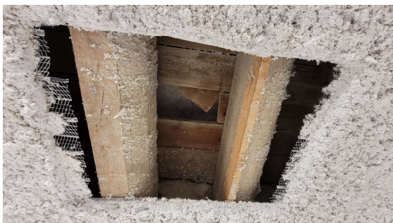
Sous-face de plancher – sondage S1
