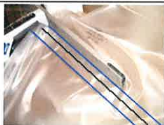
Réaliser deux autres cordons parallèles au-dessus du premier (environ 1cm entre les cordons)
