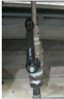
Figure 6 : Vanne manuelle pour fluide gazeux de type 1/4 de tour ; pour illustration uniquement
