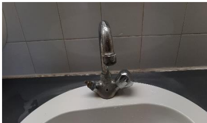
FIGURE 16 ILLUSTRATION D'UN ROBINET A L'ARRIVEE D'EAU CHAUDE CONDAMNEE
