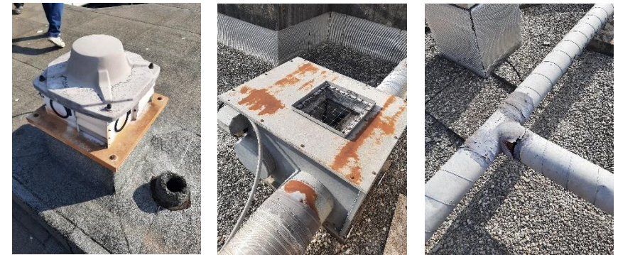
FIGURE 17 TOURELLE, EXTRACTEUR ET RESEAU AERAUQUE EN TOITURE
