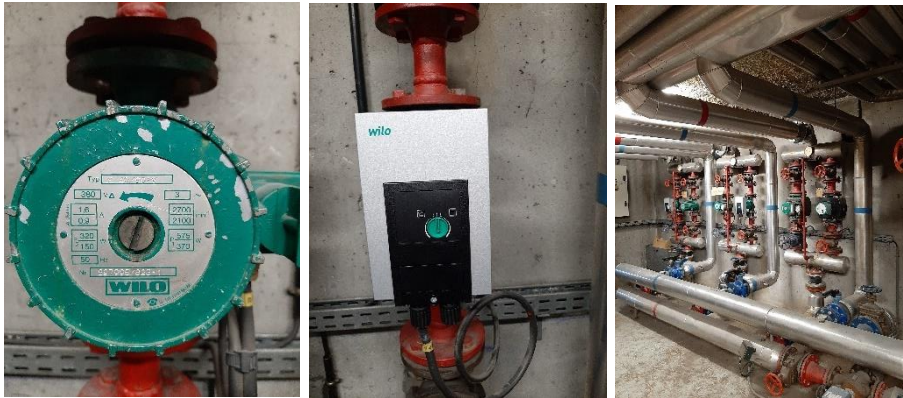
FIGURE 9 POMPE D'ORIGINE (A GAUCHE) ET POMPE RECENTE (AU CENTRE) ET DEPARTS SECONDAIRES
