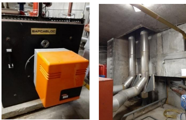
FIGURE 7 CHAUDIERE ET LE BRULEUR, EVACUATION DES FUMÉES (A DROITE)
