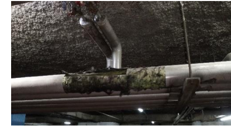
FIGURE 8 CALORIFUGE ENDOMMAGE (PARKING)
