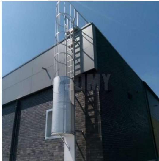
Installation échelle crinoline
