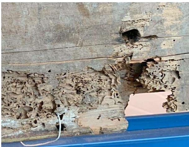
Dégradation des bois par des galeries de xylophages
