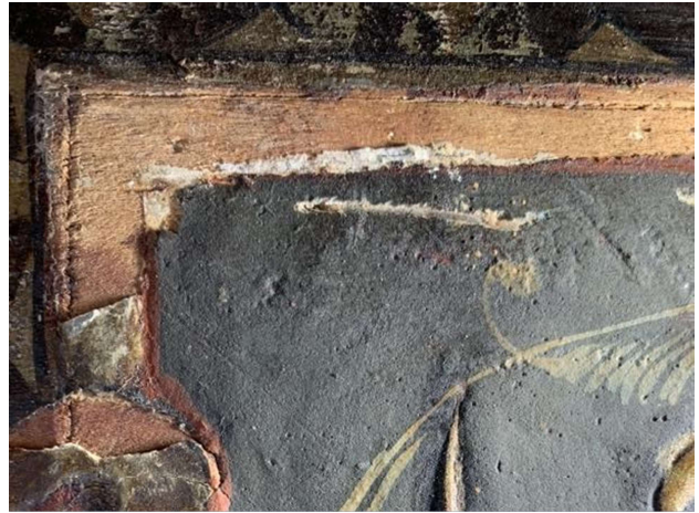
Tracés d'implantation des décors peints à la pointe sèche ou au trusquin
