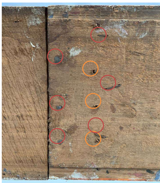
Chevilles et clous forgés maintenant les entures
