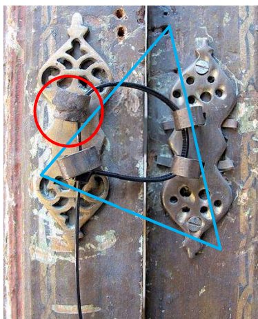
Boucles à doubles pattes : 3 restituées et 1 d'origine
