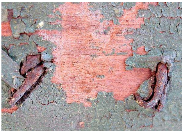
Éléments de fixation en fer forgé insérés avant mise en peinture. Insertion de la face vers l'arrière (pied visible) et inversement (tête visible).
