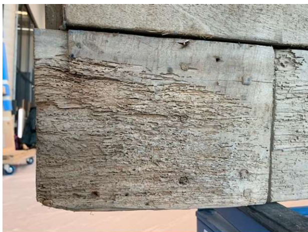
Dégradation des bois par des galeries de xylophages
