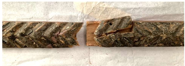
Désassemblage d'une enture de petite traverse sculptée
