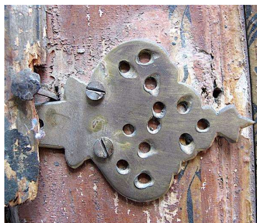
Applique ajourée horizontale restituée fixée par des vis à fente plate récentes (intervention au XXe siècle ?).
