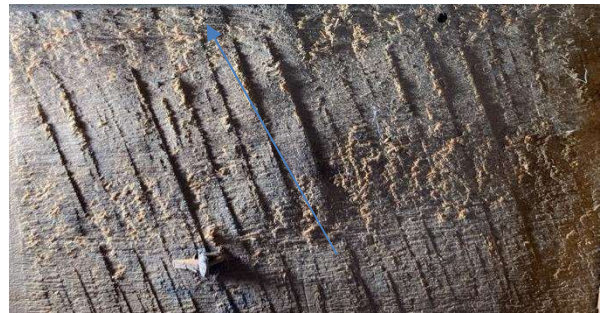
Détail de traces de sciage
