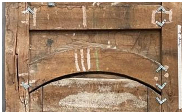
Détail des équerres de renfort fixées au revers
