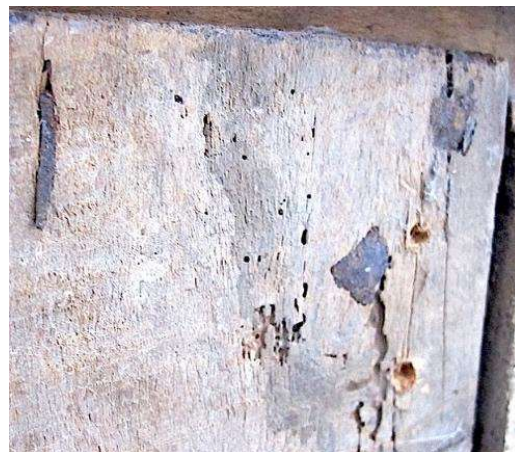
Éléments de fixation en fer forgé insérés avant mise en peinture. Insertion de la face vers l'arrière (pied visible) et inversement (tête visible).
