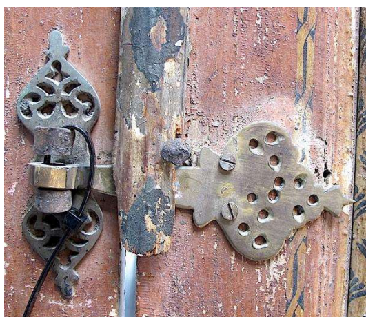
Applique ajourée horizontale restituée fixée par des vis à fente plate récentes (intervention au XXe siècle ?).
