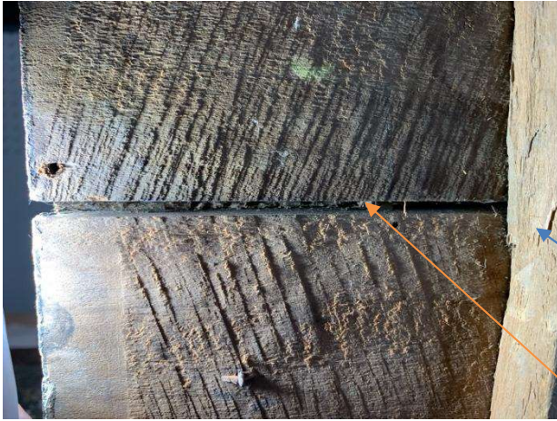
Assemblage à plat-joint renforcé de goujons et d'un tasseau cloué
