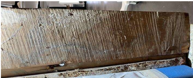
Traces de sciages au revers de montants
