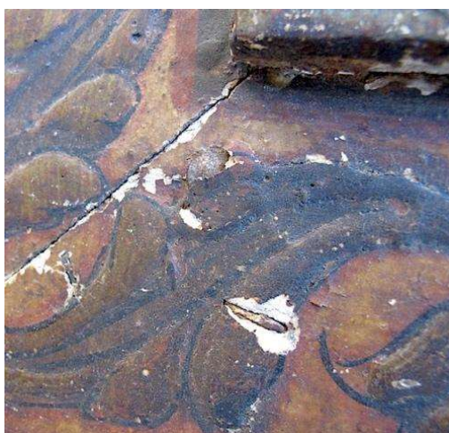
Éléments de fixation en fer forgé insérés avant mise en peinture visibles sur la face.
