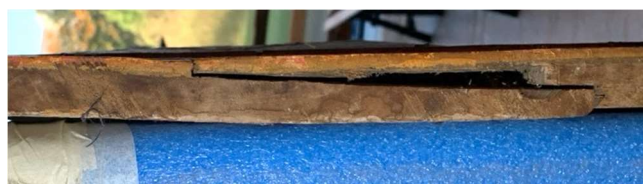
Réutilisation d'un montant avec mortaise, partiellement découpée par une enture
