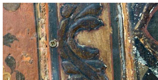
Vis de fixation des panneaux appliqués
