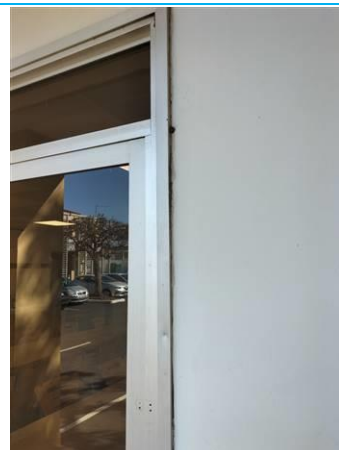
Matériaux : ZPSO-065 Prélèvement : P065 Description : Joint d'étanchéité entre menuiserie et structure Localisation : Façade A Résultat : Présence d'amiante
