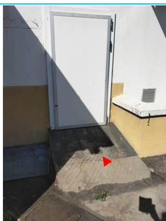
Matériaux : ZPSO-071 Prélèvement : P071 Description : Crépis extérieur beige Localisation : Façade B Résultat : Absence d'amiante
