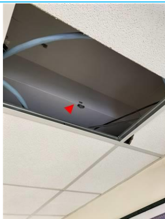
Matériaux : ZPSO-050 Prélèvement : P050 Description : Peinture beige sur poutre beton Localisation : PCE 18 Résultat : Absence d'amiante
