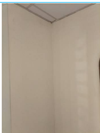
Matériaux : ZPSO-029 Prélèvement : P029 Description : Peinture creme Localisation : PCE 8 Résultat : Absence d'amiante
