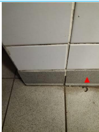
Matériaux : ZPSO-105 Prélèvement : P105 Description : Colle de plinthe grise Localisation : PCE 32 Résultat : Absence d'amiante
