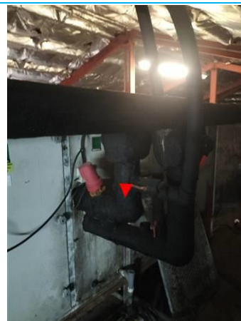
Matériaux : ZPSO-118 Prélèvement : P118 Description : calorifuge noir Localisation : Grenier Résultat : Absence d'amiante
