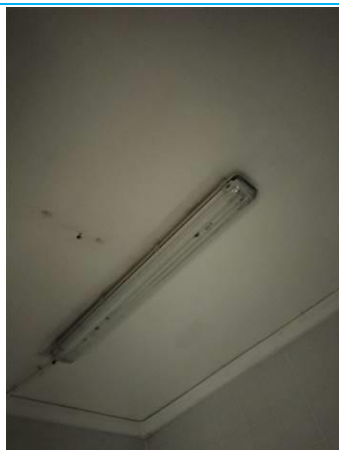
Matériaux : ZPSO-101 Prélèvement : P101 Description : Peinture plafond blanc Localisation : PCE 29 Résultat : Absence d'amiante
