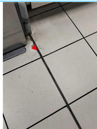
Matériaux : ZPSO-002 Prélèvement : P002 Description : -joint de dilatation Localisation : PCE 1 Résultat : Absence d'amiante
