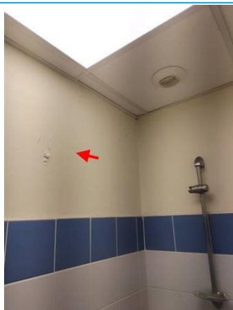
Matériaux : ZPSO-093 Prélèvement : P093 Description : Peinture beige Localisation : PCE 20 Résultat : Absence d'amiante
