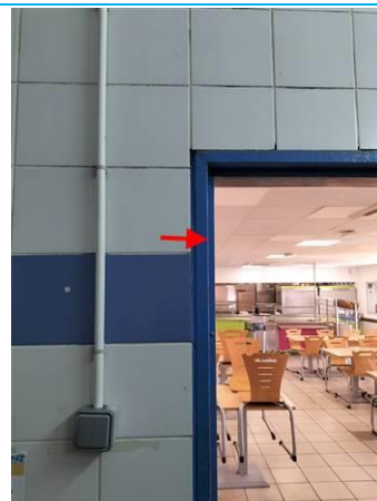
Matériaux : ZPSO-014 Prélèvement : P014 Description : joint entre porte et batis Localisation : PCE 6 Résultat : Présence d'amiante
