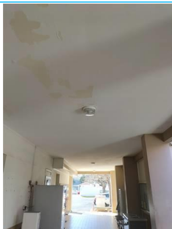
Matériaux : ZPSO-086 Prélèvement : P086 Description : Peinture plafond blanc Localisation : Varangue Résultat : Absence d'amiante
