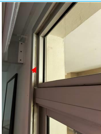
Matériaux : ZPSO-027 Prélèvement : P027 Description : -joint entre le batis et la menuiserie Localisation : PCE 7 Résultat : Présence d'amiante
