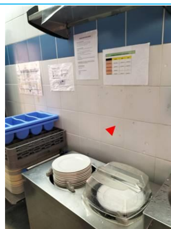
Matériaux : ZPSO-012 Prélèvement : P012 Description : Colle de faïence 20X20 blanche Localisation : PCE 6 Résultat : Absence d'amiante
