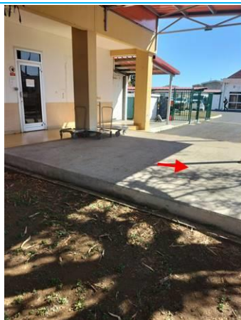
Matériaux : ZPSO-064 Prélèvement : P064 Description : Ragréege beton Localisation : Façade A Résultat : Absence d'amiante
