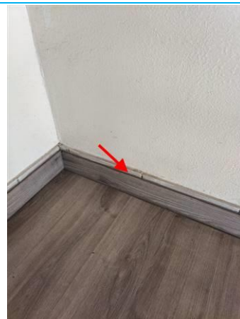
Matériaux : ZPSO-028 Prélèvement : P028 Description : Colle de plinthe sous plinthe bois Localisation : PCE 8 Résultat : Absence d'amiante
