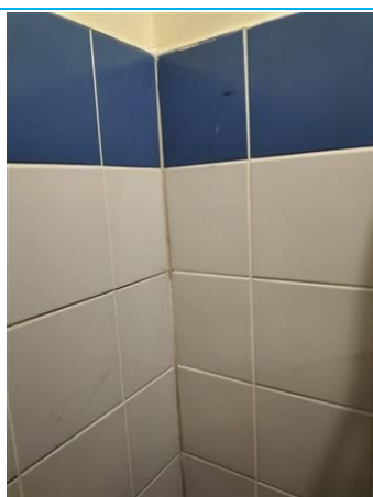
Matériaux : ZPSO-042 Prélèvement : P042 Description : Colle de faïence 20X20 blanche Localisation : PCE 17 Résultat : Absence d'amiante
