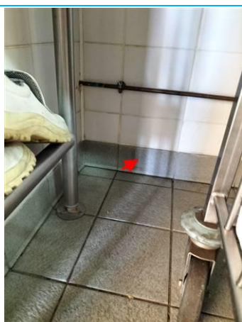
Matériaux : ZPSO-011 Prélèvement : P011 Description : Colle de plinthe grise Localisation : PCE 6 Résultat : Absence d'amiante
