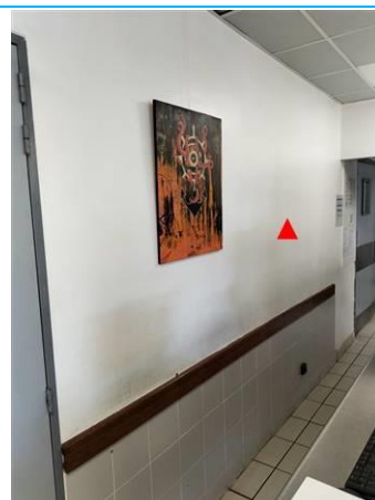
Matériaux : ZPSO-006 Prélèvement : P006 Description : Peinture blanche Localisation : PCE 1 Résultat : Absence d'amiante
