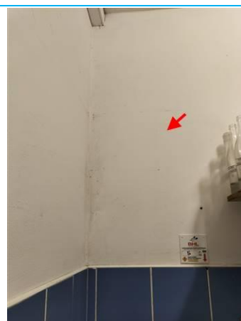
Matériaux : ZPSO-043 Prélèvement : P043 Description : Peinture blanche Localisation : PCE 17 Résultat : Absence d'amiante
