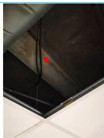
Matériaux : ZPSO-024 Prélèvement : P024 Description : béton poutre Localisation : PCE 7 Résultat : Absence d'amiante
