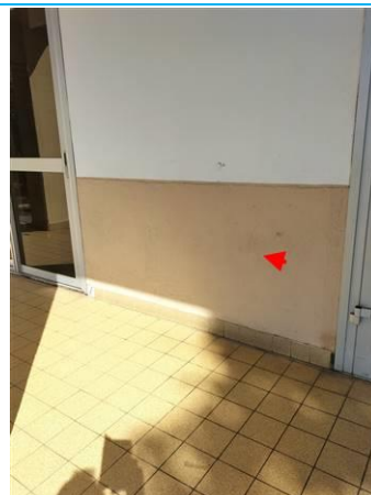
Matériaux : ZPSO-059 Prélèvement : P059 Description : Enduit extérieur (projeté, lissé ou taloché) marron Localisation : Façade A Résultat : Absence d'amiante
