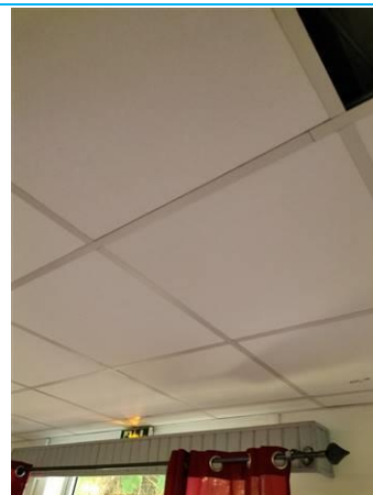
Matériaux : ZPSO-026 Prélèvement : P026 Description : Panneaux et plaques 60X60 blanche Localisation : PCE 7 Résultat : Absence d'amiante
