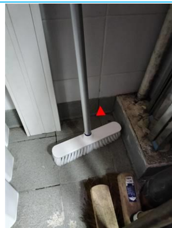
Matériaux : ZPSO-041 Prélèvement : P041 Description : Colle de plinthe grise Localisation : PCE 17 Résultat : Absence d'amiante
