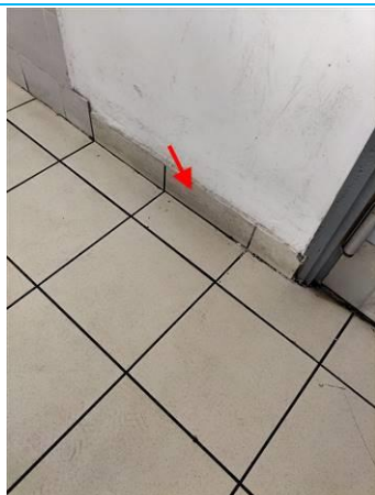
Matériaux : ZPSO-003 Prélèvement : P003 Description : Colle de plinthe grise Localisation : PCE 1 Résultat : Absence d'amiante
