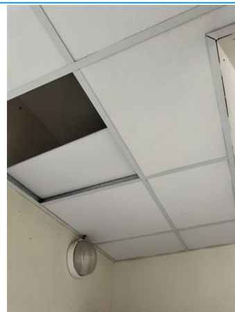
Matériaux : ZPSO-094 Prélèvement : P094 Description : Panneaux et plaques 60X60 blanche Localisation : PCE 23 Résultat : Absence d'amiante
