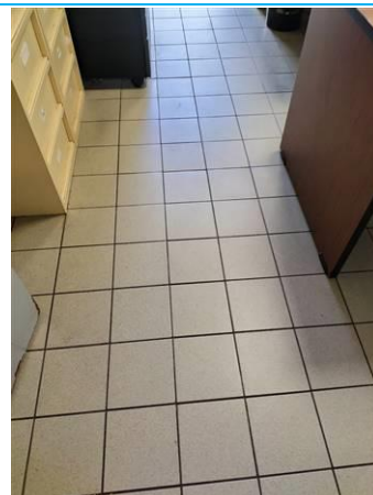
Matériaux : ZPSO-045 Prélèvement : P045 Description : Colle de carrelage 20X20 moucheté gris Localisation : PCE 18 Résultat : Absence d'amiante
