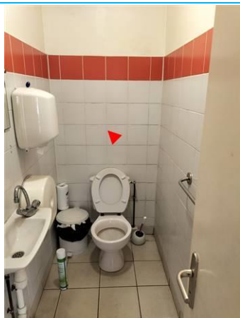
Matériaux : ZPSO-033 Prélèvement : P033 Description : Colle de faïence blanche Localisation : PCE 9 Résultat : Absence d'amiante
