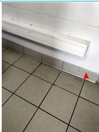
Matériaux : ZPSO-046 Prélèvement : P046 Description : Colle de plinthe grise Localisation : PCE 18 Résultat : Absence d'amiante
