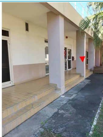
Matériaux : ZPSO-080 Prélèvement : P080 Description : Peinture sur béton marron Localisation : Façade C Résultat : Absence d'amiante
