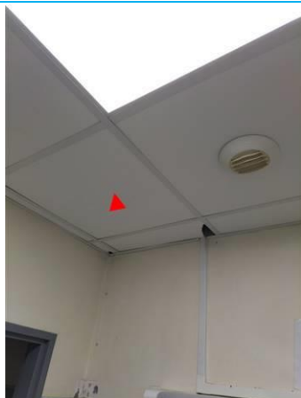
Matériaux : ZPSO-019 Prélèvement : P019 Description : Panneaux et plaques 60X60 blanche Localisation : PCE 3 Résultat : Absence d'amiante
