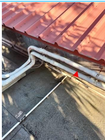
Matériaux : ZPSO-115 Prélèvement : P115 Description : Calorifuge blanc Localisation : Toiture terrasse Résultat : Absence d'amiante
