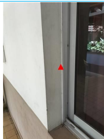
Matériaux : ZPSO-088 Prélèvement : P088 Description : Joint d'étanchéité entre menuiserie et structure Localisation : Varangue Résultat : Présence d'amiante
