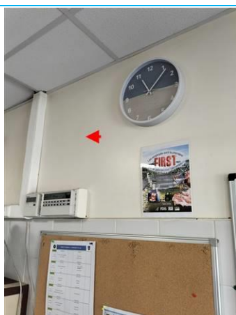
Matériaux : ZPSO-048 Prélèvement : P048 Description : Peinture beige Localisation : PCE 18 Résultat : Absence d'amiante
