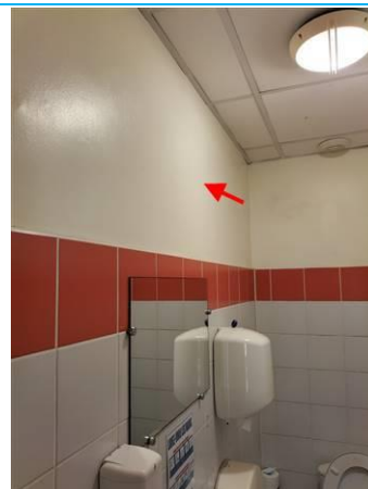
Matériaux : ZPSO-032 Prélèvement : P032 Description : Peinture beige Localisation : PCE 10 Résultat : Absence d'amiante
