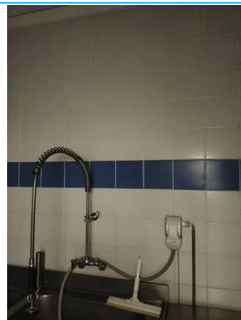
Matériaux : ZPSO-100 Prélèvement : P100 Description : Colle de faïence blanche Localisation : PCE 29 Résultat : Absence d'amiante
