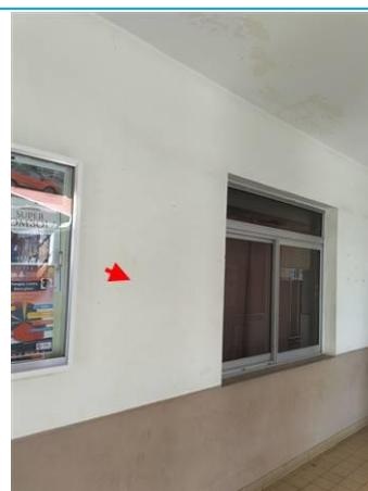
Matériaux : ZPSO-085 Prélèvement : P085 Description : Peinture sur béton blanc Localisation : Varangue Résultat : Absence d'amiante
