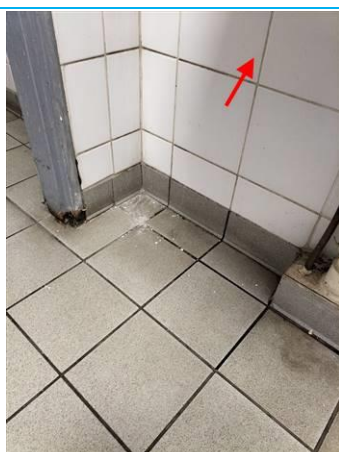
Matériaux : ZPSO-017 Prélèvement : P017 Description : Colle de faïence 20X20 blanche Localisation : PCE 3 Résultat : Absence d'amiante
