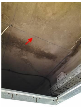
Matériaux : ZPSO-009 Prélèvement : P009 Description : plafond beton Localisation : PCE 1 Résultat : Absence d'amiante
