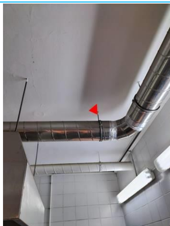
Matériaux : ZPSO-013 Prélèvement : P013 Description : Peinture blanche Localisation : PCE 6 Résultat : Absence d'amiante
