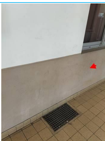
Matériaux : ZPSO-084 Prélèvement : P084 Description : Enduit extérieur (projeté, lissé ou taloché) marron Localisation : Varangue Résultat : Absence d'amiante
