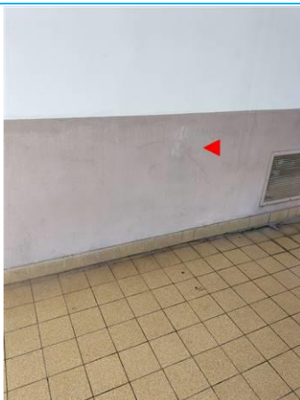
Matériaux : ZPSO-077 Prélèvement : P077 Description : Enduit extérieur (projeté, lissé ou taloché) marron Localisation : Façade C Résultat : Absence d'amiante
