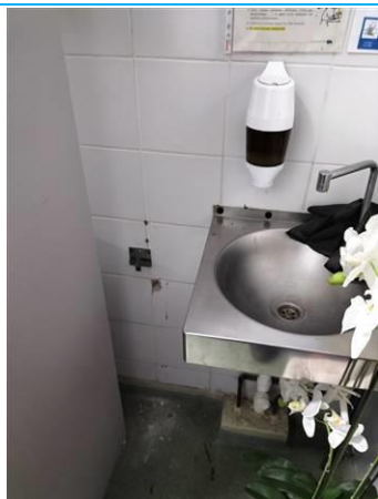
Matériaux : ZPSO-038 Prélèvement : P038 Description : Colle de faïence blanche Localisation : PCE 12 Résultat : Absence d'amiante
