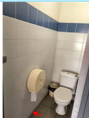
Matériaux : ZPSO-053 Prélèvement : P053 Description : Colle de plinthe grise Localisation : PCE 15 Résultat : Absence d'amiante
