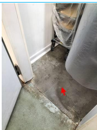
Matériaux : ZPSO-103 Prélèvement : P103 Description : Ragréeage beton Localisation : PCE 36 Résultat : Absence d'amiante
