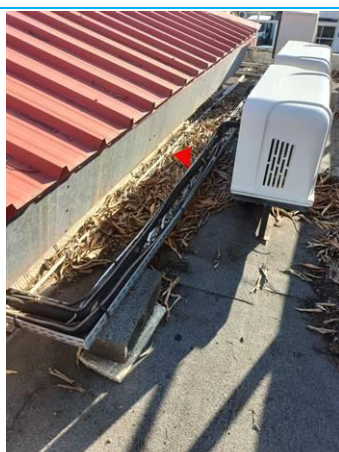
Matériaux : ZPSO-119 Prélèvement : P119 Description : calorifuge noir Localisation : Toiture terrasse Résultat : Absence d'amiante
