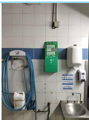
Matériaux : ZPSO-097 Prélèvement : P097 Description : Colle de faïence blanche Localisation : PCE 25 Résultat : Absence d'amiante
