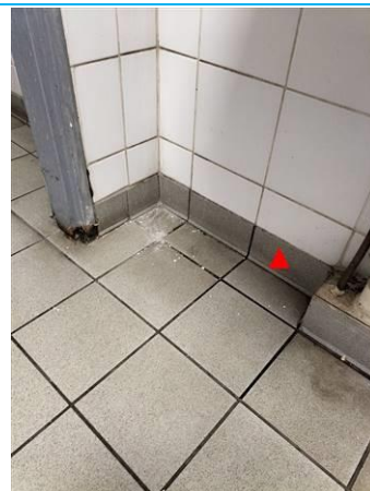
Matériaux : ZPSO-016 Prélèvement : P016 Description : Colle de plinthe grise Localisation : PCE 3 Résultat : Absence d'amiante
