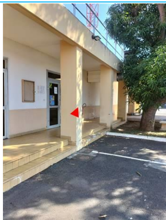
Matériaux : ZPSO-062 Prélèvement : P062 Description : Peinture sur béton beige Localisation : Façade A Résultat : Absence d'amiante
