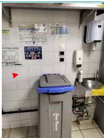
Matériaux : ZPSO-005 Prélèvement : P005 Description : Colle de faïence blanche Localisation : PCE 1 Résultat : Absence d'amiante
