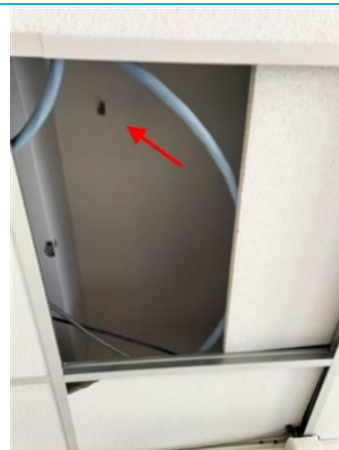
Matériaux : ZPSO-051 Prélèvement : P051 Description : Peinture plafond beige Localisation : PCE 18 Résultat : Absence d'amiante
