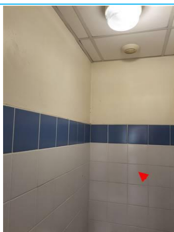
Matériaux : ZPSO-054 Prélèvement : P054 Description : Colle de faïence 20X20 blanche Localisation : PCE 15 Résultat : Absence d'amiante
