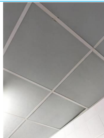
Matériaux : ZPSO-039 Prélèvement : P039 Description : Panneaux et plaques 60X60 verte Localisation : PCE 11 Résultat : Absence d'amiante
