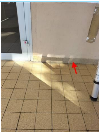
Matériaux : ZPSO-058 Prélèvement : P058 Description : Colle de plinthe moucheté beige Localisation : Façade A Résultat : Absence d'amiante
