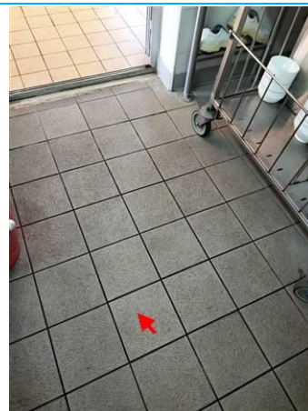
Matériaux : ZPSO-010 Prélèvement : P010 Description : Colle de carrelage 20X20 gris Localisation : PCE 6 Résultat : Absence d'amiante
