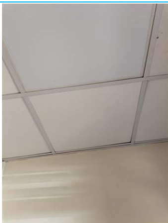
Matériaux : ZPSO-056 Prélèvement : P056 Description : Panneaux et plaques 60X60 blanche Localisation : PCE 15 Résultat : Absence d'amiante
