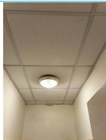
Matériaux : ZPSO-034 Prélèvement : P034 Description : Panneaux et plaques 60X60 blanche Localisation : PCE 9 Résultat : Absence d'amiante
