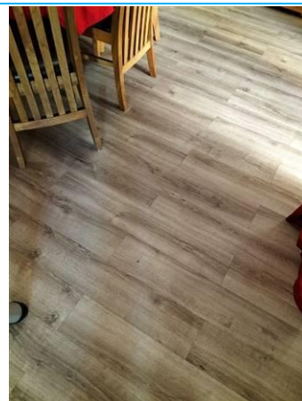
Matériaux : ZPSO-022 Prélèvement : P022 Description : Colle de carrelage sous vinyl effet parquet Localisation : PCE 7 Résultat : Absence d'amiante
