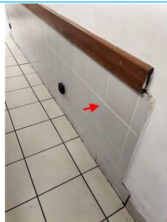
Matériaux : ZPSO-004 Prélèvement : P004 Description : Colle de faïence grise Localisation : PCE 1 Résultat : Absence d'amiante
