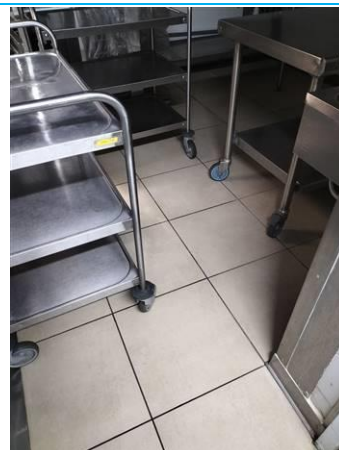
Matériaux : ZPSO-102 Prélèvement : P102 Description : Colle de carrelage 45X45 beige Localisation : PCE 30 Résultat : Absence d'amiante
