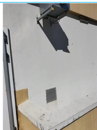
Matériaux : ZPSO-067 Prélèvement : P067 Description : Peinture sur béton blanc Localisation : Façade B Résultat : Absence d'amiante
