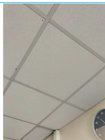
Matériaux : ZPSO-049 Prélèvement : P049 Description : Panneaux et plaques moucheté blanc Localisation : PCE 18 Résultat : Absence d'amiante
