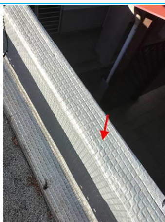
Matériaux : ZPSO-109 Prélèvement : P109 Description : Relevé : revêtement bitumineux (bandes, lés...), verale alu Localisation : Toiture terrasse Résultat : Absence d'amiante
