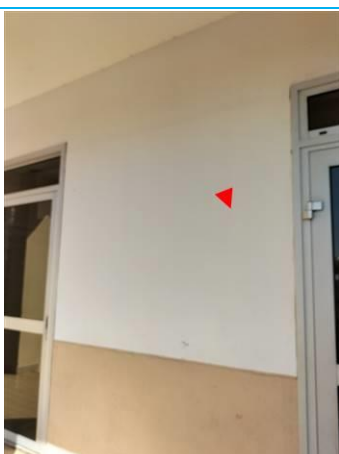
Matériaux : ZPSO-060 Prélèvement : P060 Description : Peinture sur béton blanc Localisation : Façade A Résultat : Absence d'amiante
