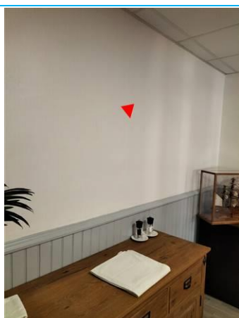
Matériaux : ZPSO-023 Prélèvement : P023 Description : Peinture blanche Localisation : PCE 7 Résultat : Absence d'amiante
