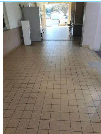
Matériaux : ZPSO-082 Prélèvement : P082 Description : Colle de carrelage moucheté beige Localisation : Varangue Résultat : Absence d'amiante
