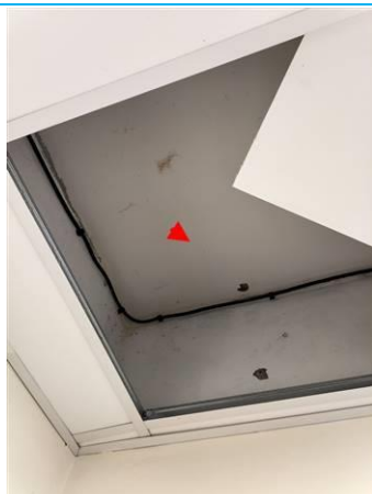
Matériaux : ZPSO-021 Prélèvement : P021 Description : Peinture plafond beige Localisation : PCE 3 Résultat : Absence d'amiante
