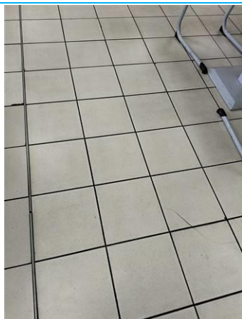
Matériaux : ZPSO-001 Prélèvement : P001 Description : Colle de carrelage 30X30 moucheté gris Localisation : PCE 1 Résultat : Absence d'amiante
