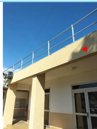
Matériaux : ZPSO-063 Prélèvement : P063 Description : Peinture sur béton beige Localisation : Façade A Résultat : Absence d'amiante
