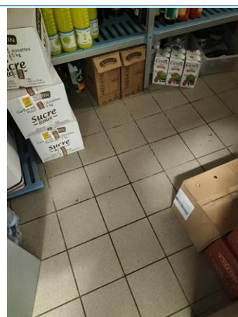
Matériaux : ZPSO-104 Prélèvement : P104 Description : Colle de carrelage moucheté gris Localisation : PCE 32 Résultat : Absence d'amiante
