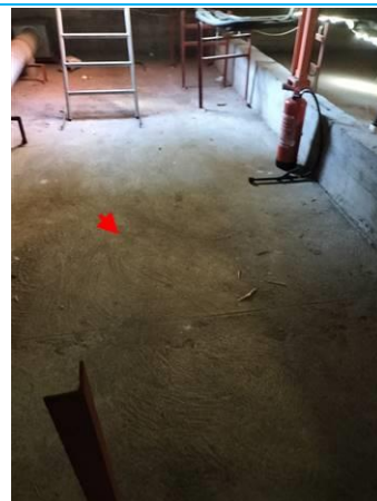
Matériaux : ZPSO-116 Prélèvement : P116 Description : Ragrage beton Localisation : Grenier Résultat : Absence d'amiante
