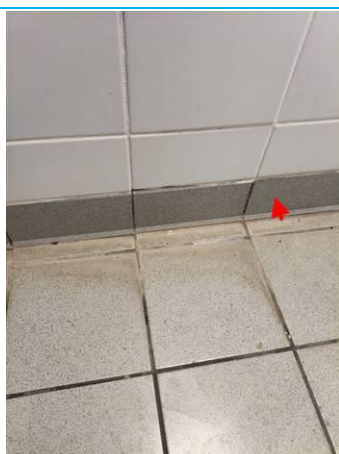
Matériaux : ZPSO-091 Prélèvement : P091 Description : Colle de plinthe grise Localisation : PCE 20 Résultat : Absence d'amiante
