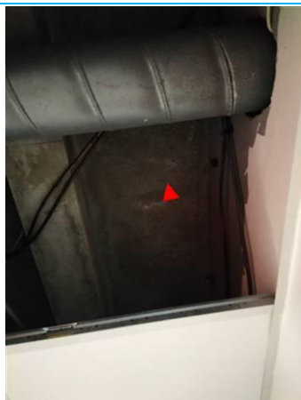
Matériaux : ZPSO-025 Prélèvement : P025 Description : plafond beton Localisation : PCE 7 Résultat : Absence d'amiante
