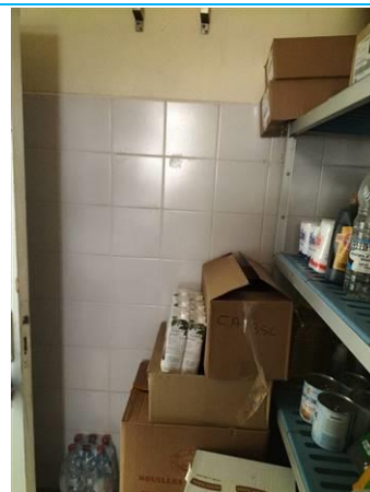
Matériaux : ZPSO-106 Prélèvement : P106 Description : Colle de faïence 20X20 blanche Localisation : PCE 32 Résultat : Absence d'amiante
