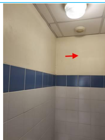
Matériaux : ZPSO-055 Prélèvement : P055 Description : Peinture beige Localisation : PCE 15 Résultat : Absence d'amiante
