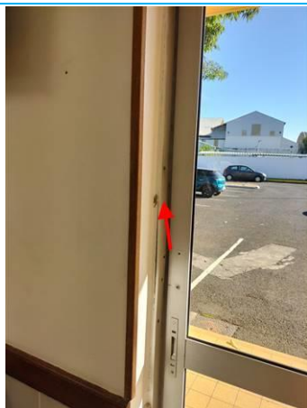
Matériaux : ZPSO-007 Prélèvement : P007 Description : joint de menuiseries Localisation : PCE 1 Résultat : Présence d'amiante
