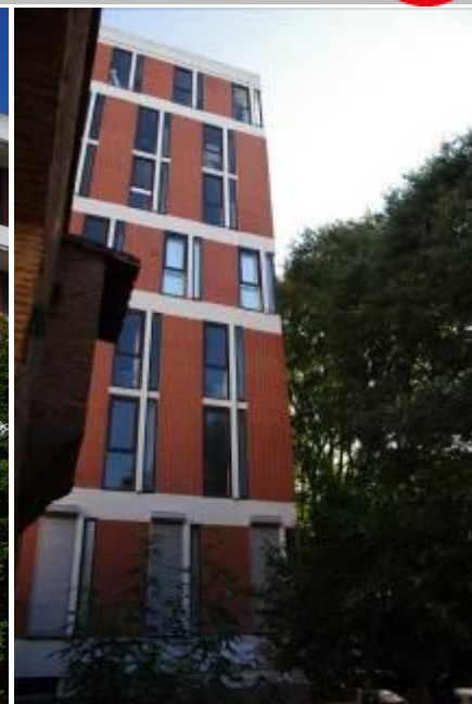
Façade Nord Façade lisse
