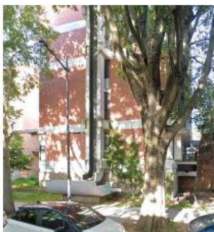
Façade Ouest Façade sur rue, Descente d'eau pluviale monumentale et petit bassin
