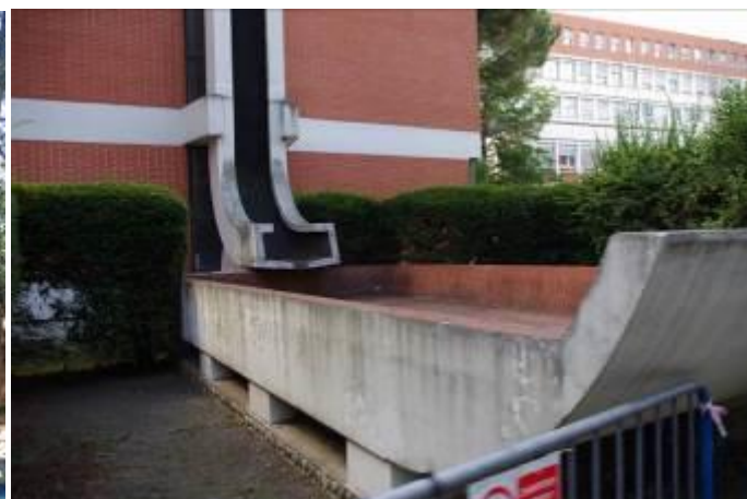
Façade Est Façade sur cour Descente d'eau pluviale monumentale et grand bassin
